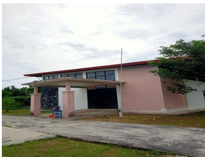
Gambar 1.3 Gedung bengkel non logam
