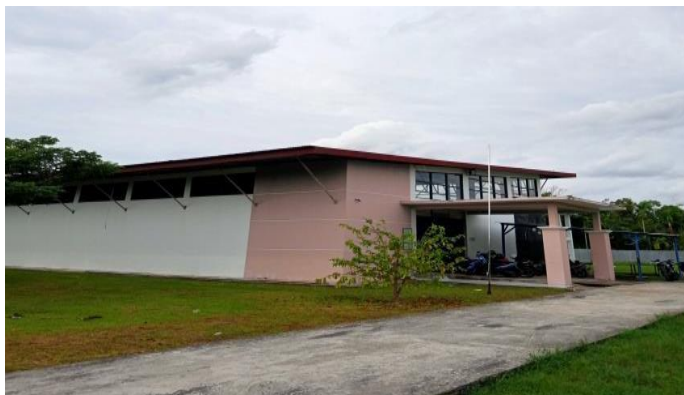
Gambar 1.2 Gedung Bengkel las pipa dan plat
