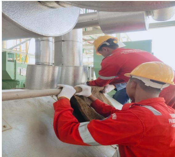
Gambar 3.8 Perbaikan pompa NaOcl (Sumber : Dokumentasi Pribadi)
