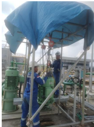
Gambar 4.10 Pembongkaran (sumber: Dokumentasi pribadi)
