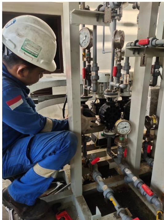
Gambar 3.9 Perbaikan pompa NaOcl (Sumber : Dokumentasi Pribadi)
