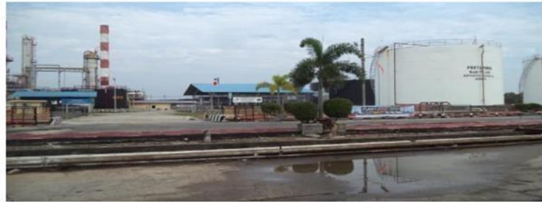
Gambar 2.1: Kilang PT. Pertamina (persero) RU II Sei. Pakning
