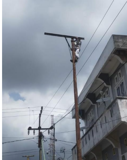
Gambar 4.3.3.b Pemeliharaan Cross Arm Miring (Sumber: PT. PLN PERSERO ULP DURI, 2023)
