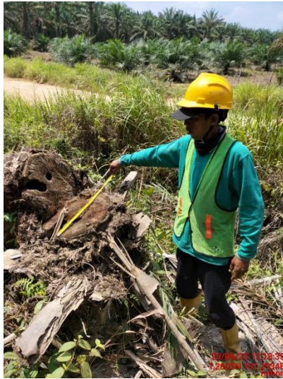
Lampiran 5. Ikut melaksanakan sample ROW yaitu mengukur diameter pohon yang bertujuan untuk mengevaluasi hasil pekerjaan tim ROW
