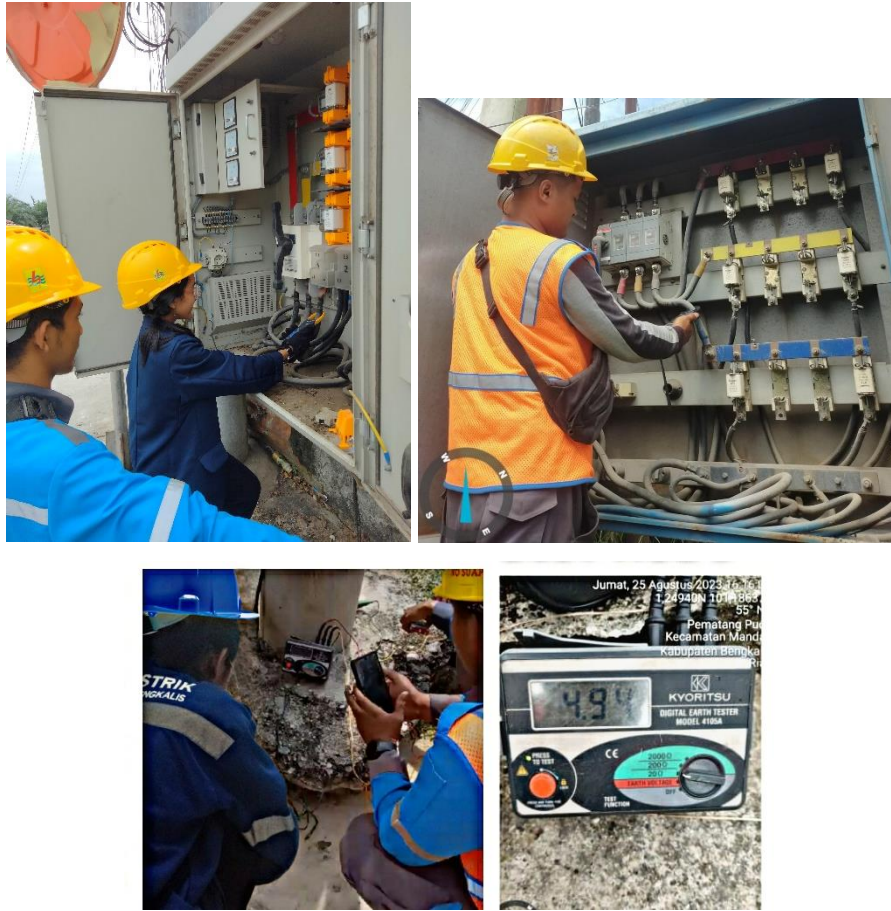
Lampiran 8. Ikut melaksanakan pengukuran beban Jurusan pada Gardu Distribusi dan pengukuran tahanan LA
