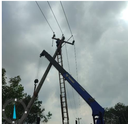
Gambar 4.3.2.b Pemeliharaan Tiang Miring (Sumber: PT. PLN PERSERO ULP DURI, 2023)
