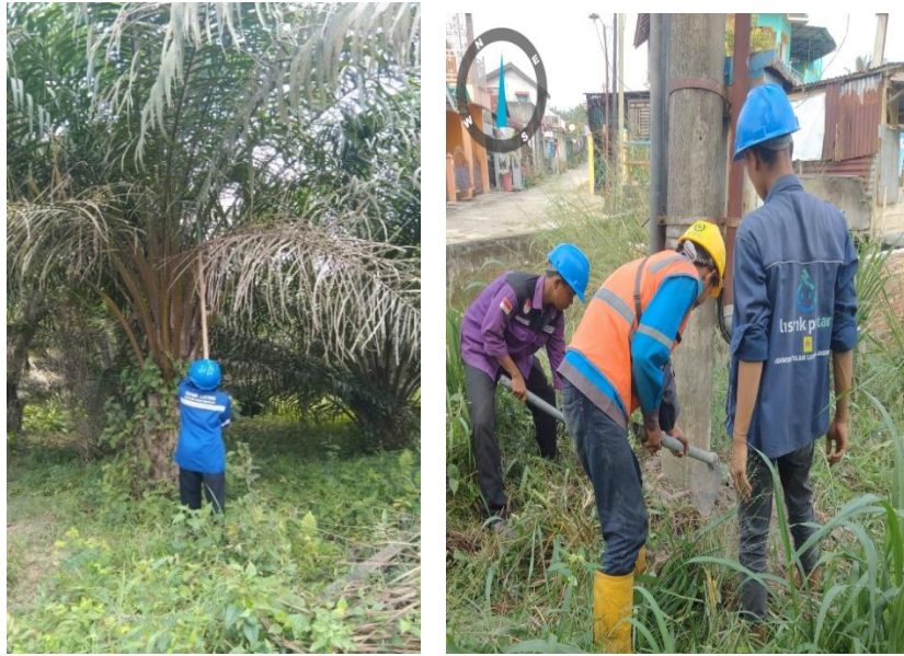
Lampiran 3. Melakukan pemeliharaan yakni dengan melakukan pembersihan, penebangan dan pemangkasan agar tidak menyebabkan gangguan
