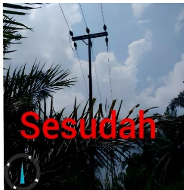
Gambar 4.3.4.b Pemeliharaan Isolator Rusak/Pecah (Sumber: PT. PLN PERSERO ULP DURI, 2023)
