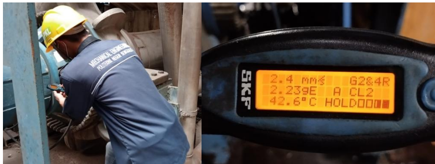
Gambar 4.7 Cek Vibrasi Pompa Sumber dokumentasi sendiri
