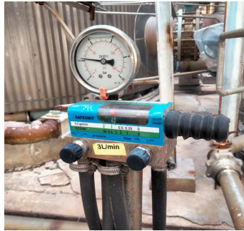
Gambar 4.10 Cek Pressure Gauge Sumber dokumentasi sendiri
