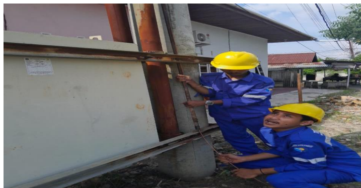
Gambar 2. 10 pemasangan grounding pada trafo
