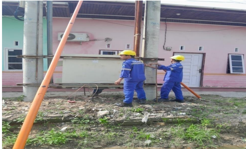
gambar 2. 12 pemasangan grounding pada trafo
