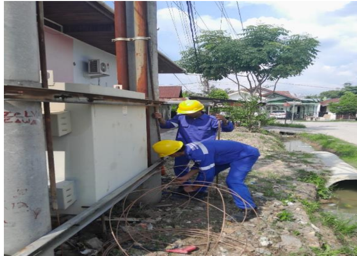
gambar 2. 15 pemasangan grounding pada trafo
