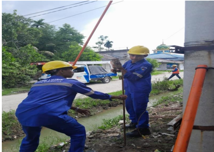
Gambar 2. 11 pemasangan gronding pada trafo
