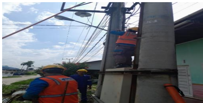
gambar 2. 16 pemasangan grounding pada trafo
