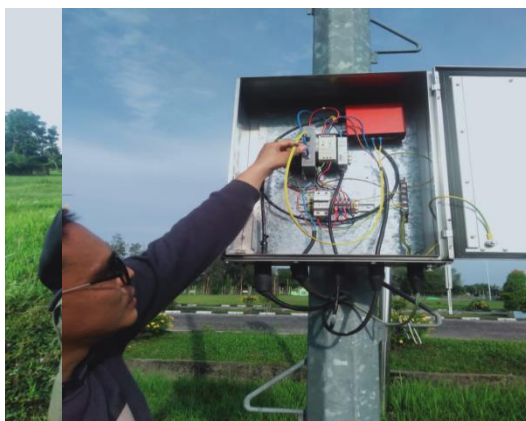
Gambar 3.7 Pengecekan jaringan cctv
