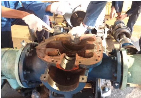
Gambar 4.14 Pembersihan pompa (Sumber : Dokumentasi sendiri)
