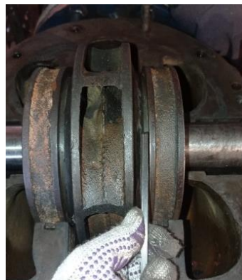
Gambar 4.20 Shaft Pompa C3W (Sumber : Dokumentasi Sendiri )
