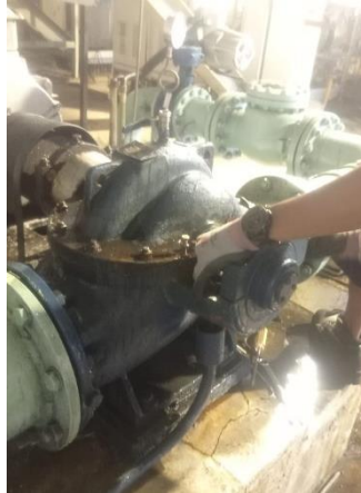
Gambar 3.2 PM Pada Pompa C3W (Sumber : Dokumentasi Pribadi)
