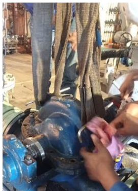
Gambar 4.5 Pengangkatan upper casing (Sumber : Dokumentasi sendiri)
