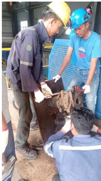
Gambar 3.4 Pembongkaran pompa sampit (Sumber : Dokumentasi Pribadi)
