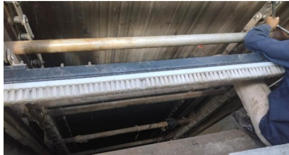
Gambar 2.5 Corrective Maintenance pada traveling water screen (Sumber : Dokumentasi Pribadi)
