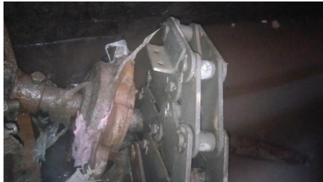
Gambar 3.12 Perbaikan traveling screen (Sumber : Dokumentasi Pribadi)
