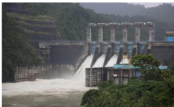
Gambar 1.1 ULPLTA Koto Panjang (Sumber: Unit Layanan PLTA Koto Panjang. 2023)
