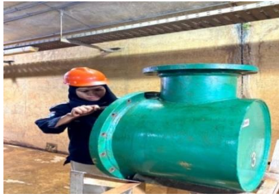
Gambar 2.59 Heat Exchanger 1 dan unit 3
