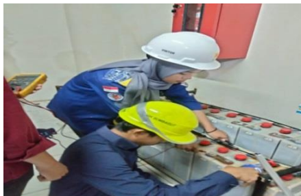
Gambar 2.48 Baterai Basah
