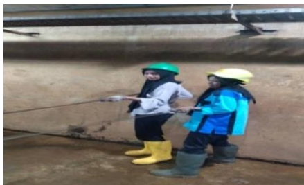
Gambar 2.46 Heat Exchanger unit 2 dan unit 3
