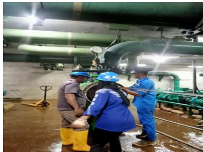
Gambar 2.57 Heat Exchanger 2 dan unit 3
