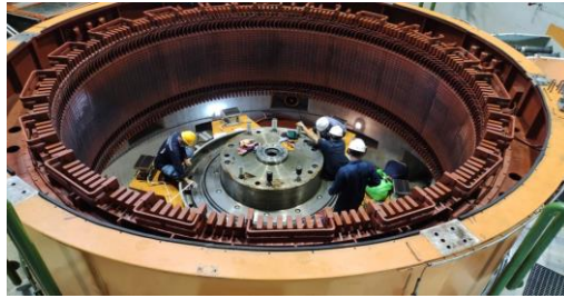
Gambar 3.9 Stator ULPLTA Koto Panjang
