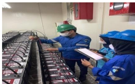
Gambar 2.16 Baterai Kering
