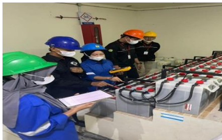
Gambar 2. 28 Baterai Basah
