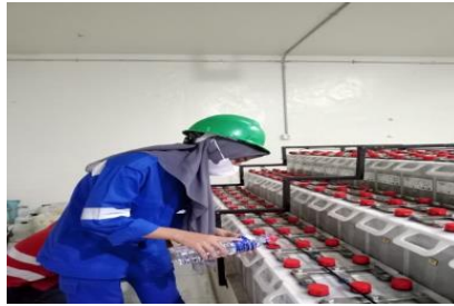
Gambar 2.23 Baterai Basah
