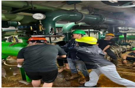
Gambar 2.17 Heat Exchanger 1 dan unit 2
