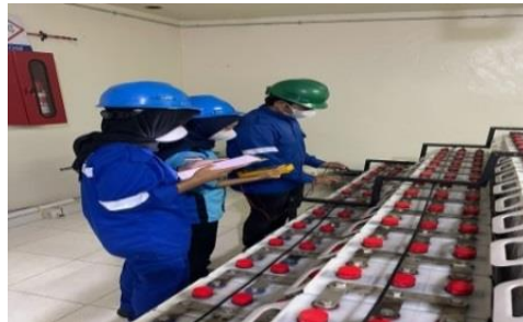
Gambar 2.6 Baterai basah
