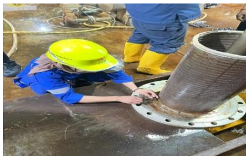
Gambar 2.7 Strainer unit 2.1 dan unit 2.2
