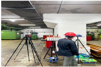
Gambar 2.33 Pemeliharaan lingkungan kerja di area Top Cover
