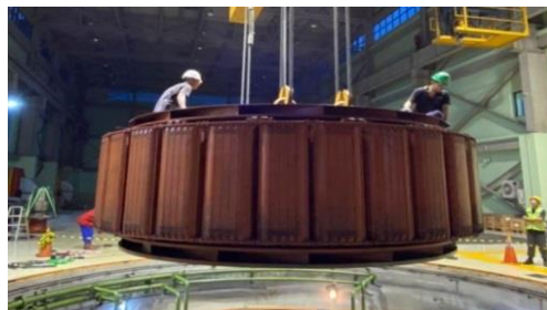
Gambar 3.6 Rotor ULPLTA Koto Panjang
