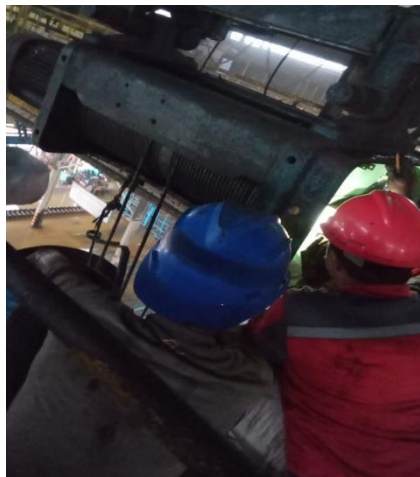
Gambar 2.7 Mengganti Seling Hoisting Crane no. 2 (sumber : dokumentasi penulis 2023)
