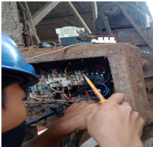
Gambar 2.5 Pembuatan Rangkaian Conveyor Cangkang (sumber : dokumentasi penulis 2023)
