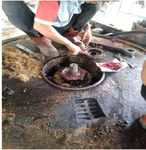
Gambar 2.2 Penambahan Grease pada Bearing Vibrating Screen
