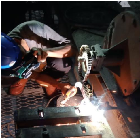
Gambar 2.6 Pembuatan Dudukan Gearbox (sumber : dokumentasi penulis 2023)
