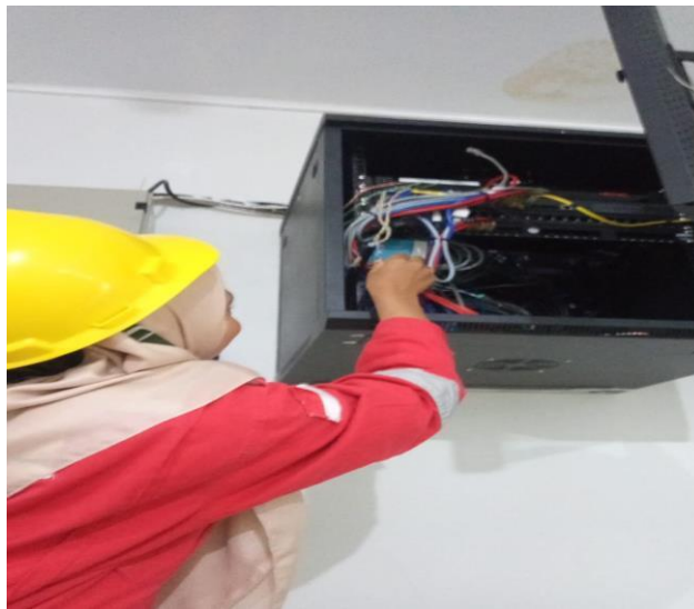
Gambar 3. 1 Pengecekan Jarigan di Gudang Procurement (Sumber: Dokumne Pribadi 2023)
