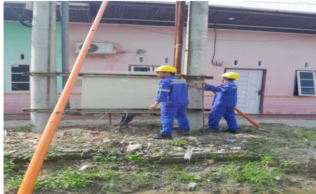
Gambar 14 - Pemasangan Grounding Sumber: Dokumentasi di PT PLN Dumai
