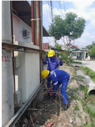
Gambar 17 - Pemasangan Grounding Sumber: Dokumentasi di PT PLN Dumai
