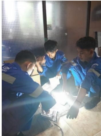
Gambar 25 - Aktivasi KWH Meter 1 Phase Sumber: Dokumentasi di PT PLN Dumai
