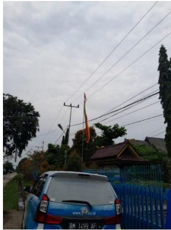
Gambar 34 - Survei Lapangan Sumber: Dokumentasi di PT PLN Dumai
