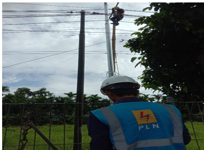
Gambar 39 - Survei Lapangan Sumber: Dokumentasi di PT PLN Dumai
