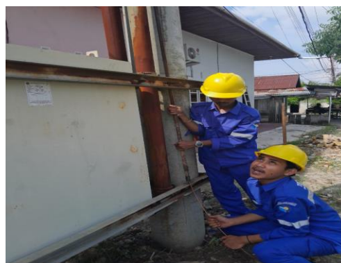
Gambar 12 - Pemasangan Grounding
