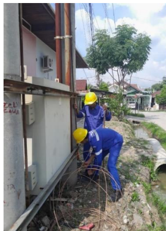
Gambar 54 - Pemasangan Kawat Tembaga Sumber: Dokumentasi di PT PLN Dumai
