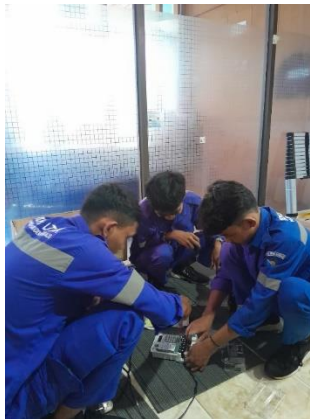
Gambar 20 - Aktivasi KWH Meter 1 Phase Sumber: Dokumentasi di PT PLN Dumai
