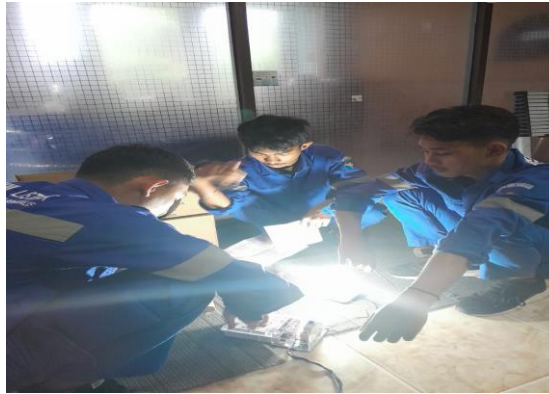
Gambar 6 - Aktivasi KWH Meter 1 Phase Sumber: Dokumentasi di PT PLN Dumai
