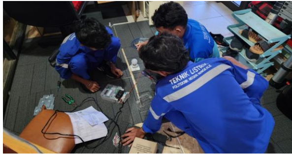
Gambar 9 - Aktivasi KWH Meter 1 Phase Sumber: Dokumentasi di PT PLN Dumai
