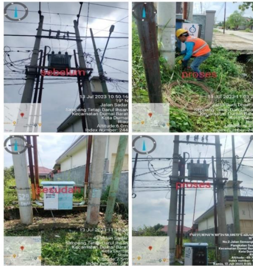
Gambar 53 - Keadaan Lapangan Sebelum dan Sesudah Pengerjaan Sumber: Dokumentasi di PT PLN Dumai
