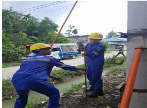
Gambar 13 - Pemasangan Grounding Sumber: Dokumentasi di PT PLN Dumai
