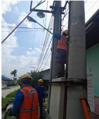
Gambar 18 - Pemasangan Grounding Sumber: Dokumentasi di PT PLN Dumai
