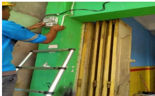
Gambar 40 - Perbaikan KWH Meter 1 Phase Sumber: Dokumentasi di PT PLN Dumai
