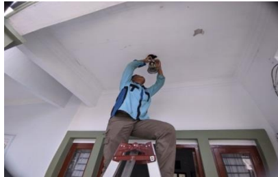
Gambar 2.9 Pemasangan instalasi (Sumber : dokumentasi 2023)
