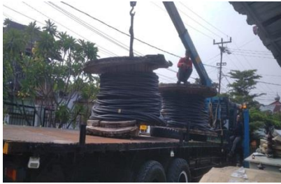
Gambar 2.62 Penggantian kabel (Sumber : dokumentasi 2023)
