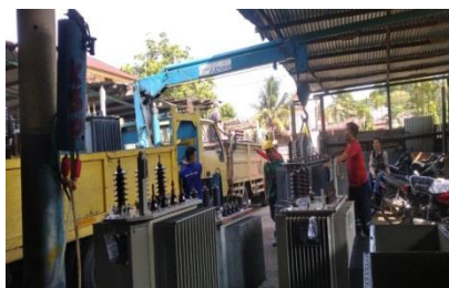
Gambar 2.32 Pemindahan trafo (Sumber : dokumentasi 2023)
