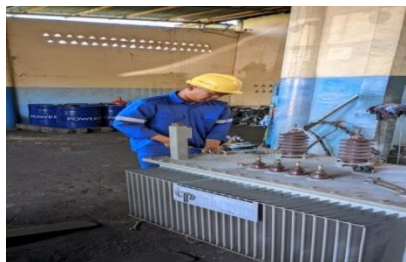
Gambar 2.11 Penguncian baut body trafo (Sumber : dokumentasi 2023)
