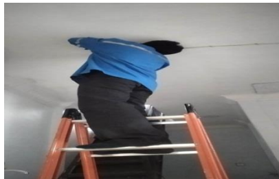
Gambar 2.5 Pemasangan instalasi rumah (Sumber : dokumentasi 2023)
