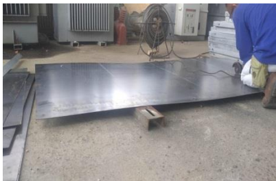
Gambar 2.63 Pemotongan besi plat (Sumber : dokumentasi 2023)
