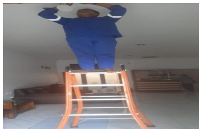
Gambar 2.2 Pemasangan instalasi rumah (Sumber : dokumentasi 2023)
