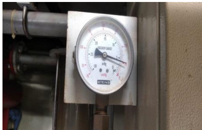
Gambar 4.5 Indikator permukaan minyak (sumber : dokumentasi 2023)
