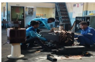
Gambar 2.26 Pemasangan kor (Sumber : dokumentasi 2023)
