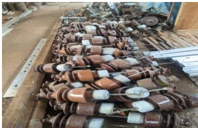
Gambar 2.50 Pembongkaran pin isolator (Sumber : dokumentasi 2023)
