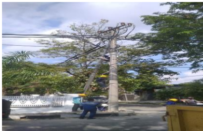
Gambar 2.48 Penarikan kabel TS (Sumber : dokumentasi 2023)
