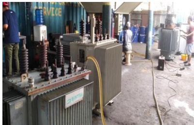
Gambar 2.53 Flushing minyak (Sumber : dokumentasi 2023)
