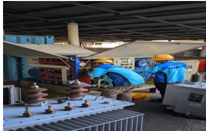
Gambar 2.24 Pembersihan alat oil flushing (Sumber : dokumentasi 2023)
