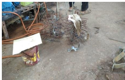
Gambar 2.56 Rangka besi blok (Sumber : dokumentasi 2023)
