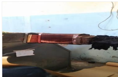
Gambar 2.12 Penggulangan kawat trafo (Sumber : dokumentasi 2023)
