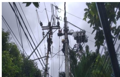
Gambar 2.46 Pemasangan LBS (Sumber : dokumentasi 2023)
