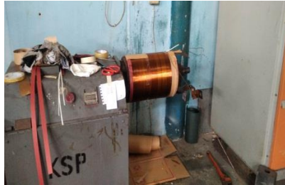
Gambar 2.65 Penggulangan kawat (Sumber : dokumentasi 2023)
