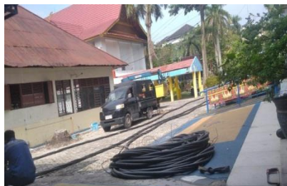
Gambar 2.58 Pemasangan kabel (Sumber : dokumentasi 2023)
