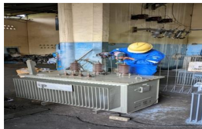
Gambar 2.22 Pembersihan bulshing (Sumber : dokumentasi 2023)
