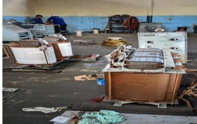
Gambar 2.38 Pembongkaran komponen trafo (Sumber : dokumentasi 2023)
