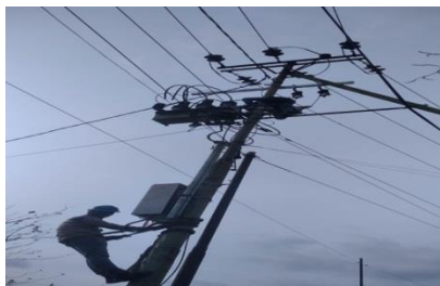
Gambar 2.7 Pemindahan LBS dan panelnya (Sumber : dokumentasi 2023)
