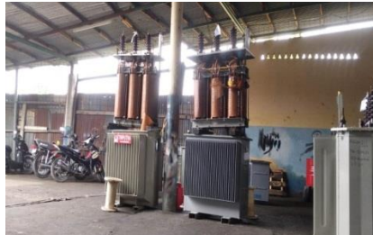
Gambar 2.33 Pembongkaran baut trafo (Sumber : dokumentasi 2023)
