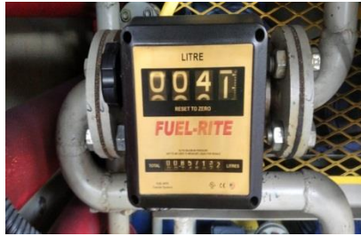
Gambar 4.6 Indikator liter minyak (sumber : dokumentasi 2023)
