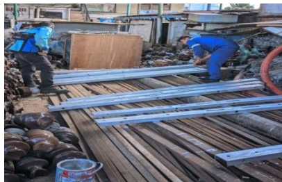
Gambar 2.45 Pengecatan traves (Sumber : dokumentasi 2023)
