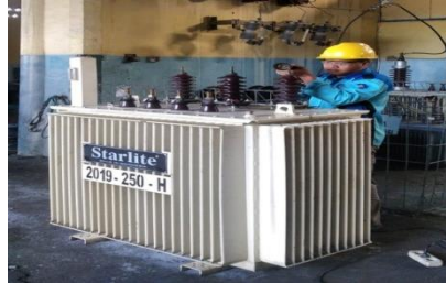
Gambar 2.30 Pembersihan bulshing (Sumber : dokumentasi 2023)
