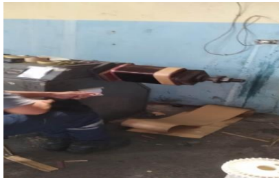
Gambar 2.13 Penggulangan kawat trafo (Sumber : dokumentasi 2023)
