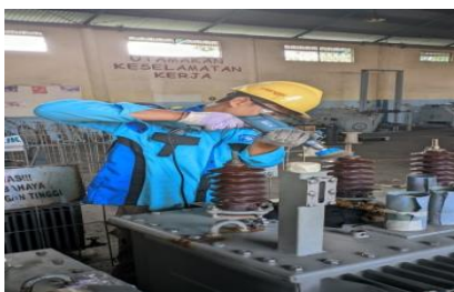
Gambar 2.16 Pembersihan bulshing (Sumber : dokumentasi 2023)
