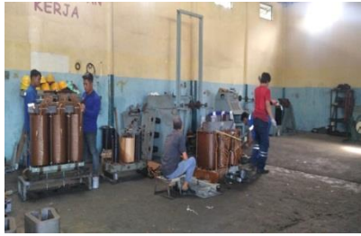
Gambar 2.35 Pembongkaran trafo (Sumber : dokumentasi 2023)
