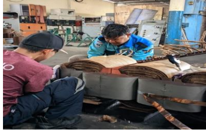
Gambar 2.27 Pemasangan kor (Sumber : dokumentasi 2023)
