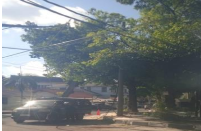
Gambar 2.47 Penarikan kabel TR (Sumber : dokumentasi 2023)
