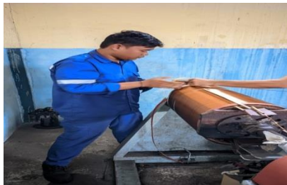
Gambar 2.18 Penggulungan kawat trafo (Sumber : dokumentasi 2023)
