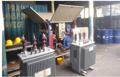
Gambar 2.21 Flushing minyak trafo (Sumber : dokumentasi 2023)
