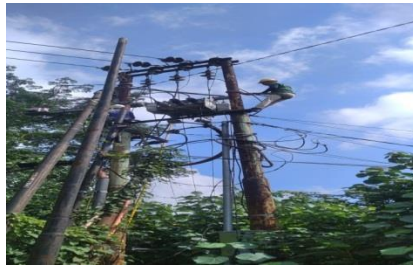
Gambar 2.4 Pemasangan LBS (Sumber : dokumentasi 2023)
