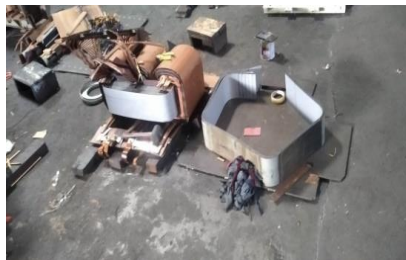
Gambar 2.25 Pembongkaran kor (Sumber : dokumentasi 2023)
