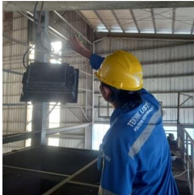
Gambar 2.60 Ganti Lampu 100 W Sumber: (Dokumentasi, 2023)
