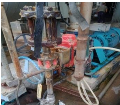
Gambar 2.57 Memberi Grease pada Aktuator. Sumber: (Dokumentasi, 2023)
