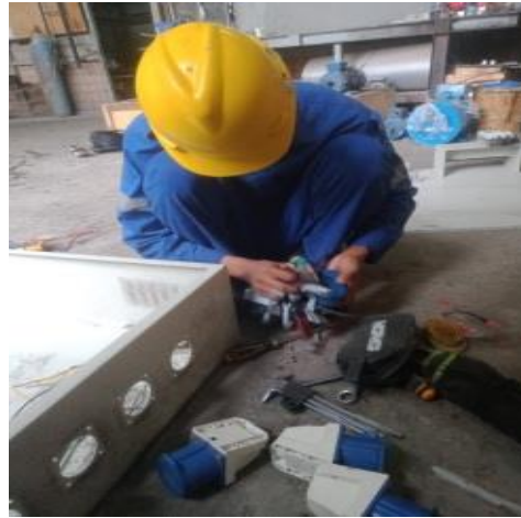
Gambar 2.5 Bongkar Panel Area Boiler Sumber: (Dokumentasi, 2023)
