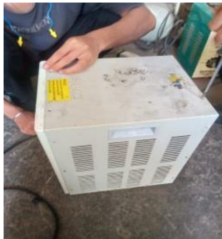
Gambar 2.11 Pengecekan Stabilizer Sumber: (Dokumentasi, 2023)
