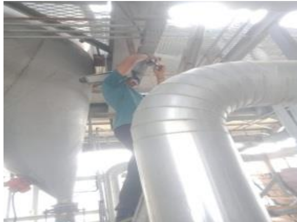
Gambar 2.21 Pemasangan Lampu Sumber: (Dokumentasi, 2023)
