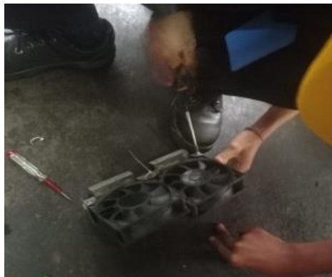
Gambar 2.54 Ganti Fan Inverter di Tempat Compresor Sumber: (Dokumentasi, 2023)
