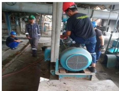
Gambar 2.64 Bongkar Motor 3 Phase di Boiler Sumber: (Dokumentasi, 2023)
