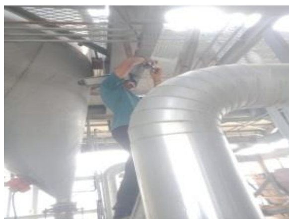
Gambar 2.6 Penggantian Lampu 50 watt di Refinery Sumber: (Dokumentasi, 2023)
