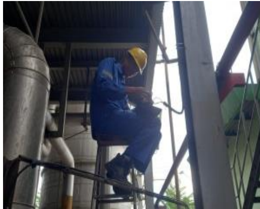
Gambar 2.16 Ganti Lampu di Refinery Sumber: (Dokumentasi, 2023)
