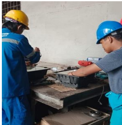
Gambar 2.3 Penggantian Lampu 100 watt Area Boiler Sumber: (Dokumentasi, 2023)
