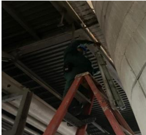
Gambar 2.55 Menganti Lampu di Refinery Sumber: (Dokumentasi, 2023)
