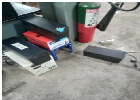
Gambar 2.18 Ganti UPS di Ruang Control Sumber: (Dokumentasi, 2023)
