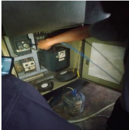
Gambar 2.33 Pemasangan Blower di Panel Chiler Sumber: (Dokumentasi, 2023)
