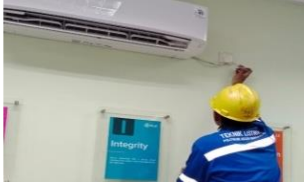
Gambar 2.36 Mengganti Fuse AC Office Sumber: (Dokumentasi, 2023)
