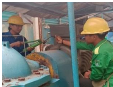
Gambar 2.1 Pemberian Grease pada Motor Sumber: (Dokumentasi, 2023)
