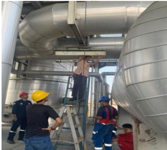
Gambar 2.46 Ganti Lampu di Refinery Atas Sumber: (Dokumentasi, 2023)
