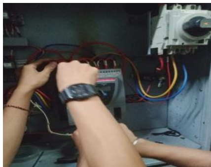
Gambar 2.34 Bongkar Inverter di Panel MCC Sumber: (Dokumentasi, 2023)
