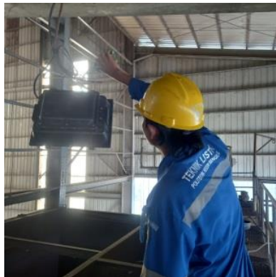
Gambar 2.61 Ganti Lampu 400 W di Boiler. Sumber: (Dokumentasi, 2023)
