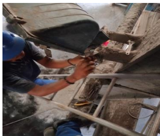
Gambar 2.35 Ganti Lampu Led 400 W di Turbin Sumber: (Dokumentasi, 2023)
