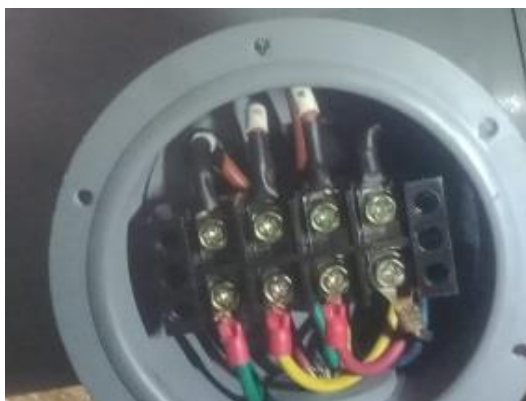
Gambar 2.42 Connect Kabel Motor Chiler Sumber: (Dokumentasi, 2023)
