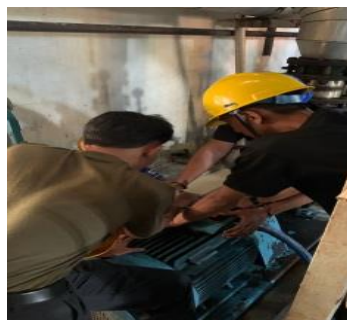
Gambar 2.30 Ganti Skun Kabel Motor di Refinery Sumber: (Dokumentasi, 2023)
