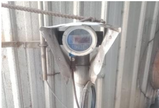
Gambar 2.47 Perbaikan Transmitter Area Boiler Sumber: (Dokumentasi, 2023)
