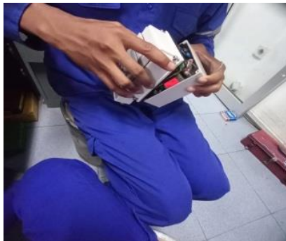
Gambar 2.8 Ganti Modul Servo Motor Boiler Advant Sumber: (Dokumentasi, 2023)
