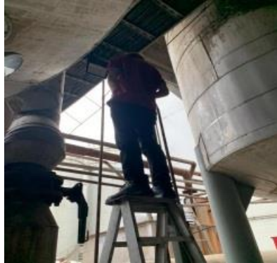
Gambar 2.65 Mengganti Lampu di Refinery Sumber: (Dokumentasi, 2023)
