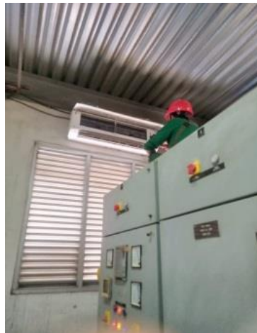
Gambar 2.51 Connect Kabel AC di Ruangn MCC Sumber: (Dokumentasi, 2023)
