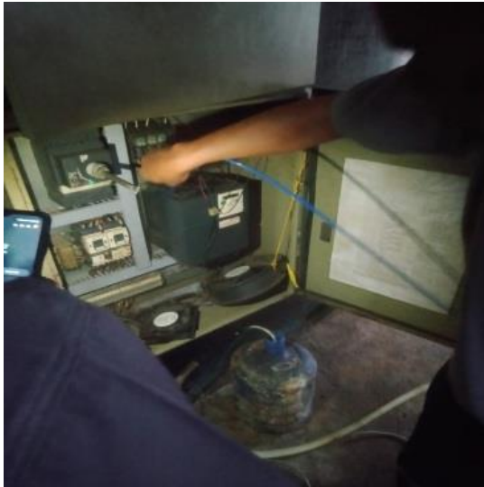
Gambar 2.14 Ganti Kipas Blower di Panel Chiler Sumber: (Dokumentasi, 2023)
