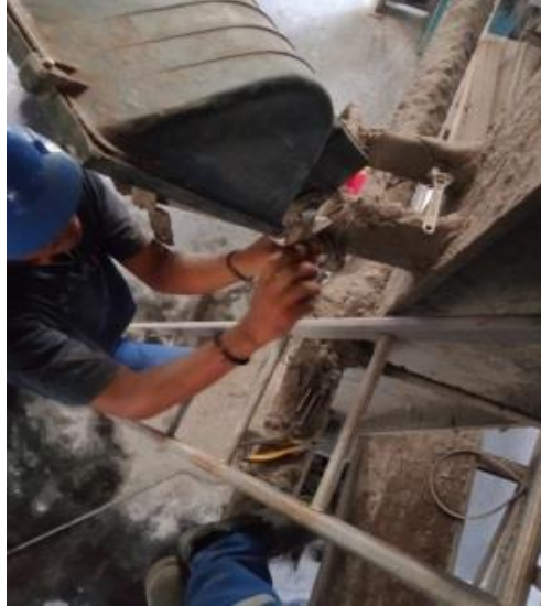
Gambar 2.19 Pemasangan Lampu Led 400 W di Boiler Sumber: (Dokumentasi, 2023)
