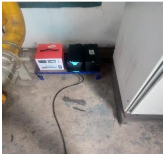
Gambar 2.20 Pemasangan UPS dan Stabilizer di Boiler Advant Sumber: (Dokumentasi, 2023)
