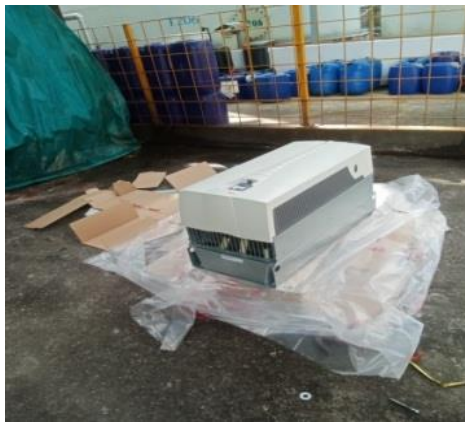
Gambar 2.53 Ganti Inverter di MCC Sumber: (Dokumentasi, 2023)
