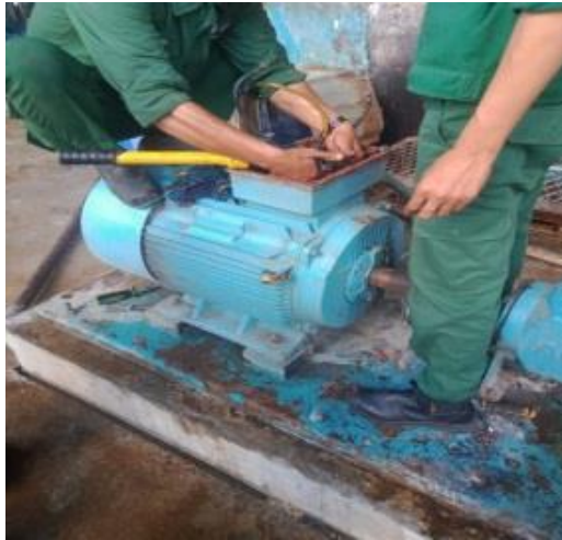
Gambar 2.12 Ganti Skun Kabel Motor 3 Phase Sumber: (Dokumentasi, 2023)
