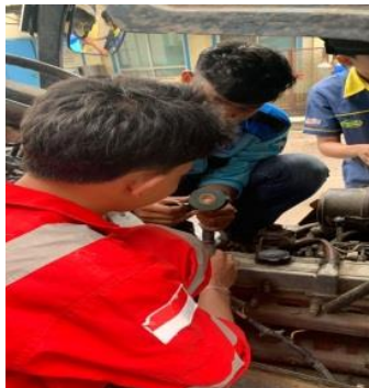
Gambar 2.52 Ganti Skun Kabel Forklift Sumber: (Dokumentasi, 2023)
