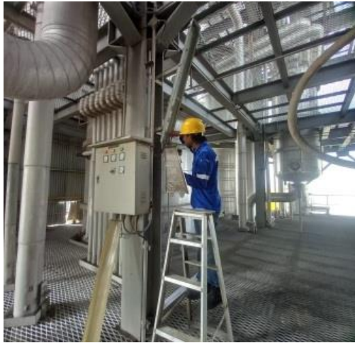
Gambar 2.23 Pemasangan Lampu 50 W di Refinery Sumber: (Dokumentasi, 2023)
