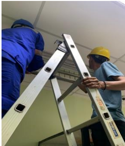
Gambar 2.66 Pemasangan Lampu di Office Sumber: (Dokumentasi, 2023)
