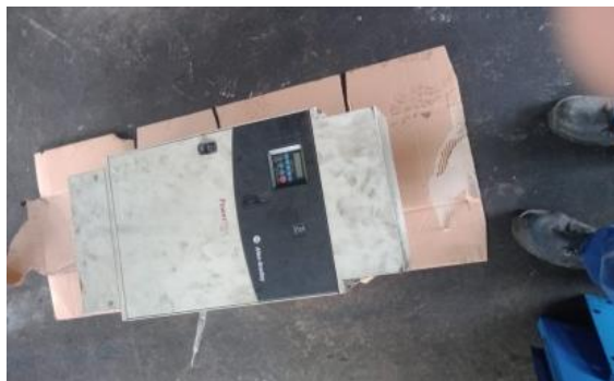
Gambar 2.56 Bongkar Inverter di Compresor Sumber: (Dokumentasi, 2023)
