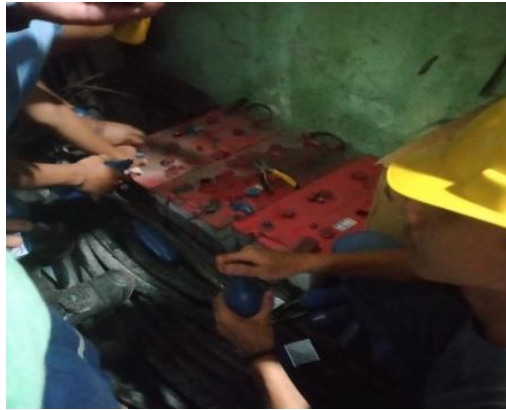
Gambar 2.63 Mengisi Air Batre Genset Sumber: (Dokumentasi, 2023)
