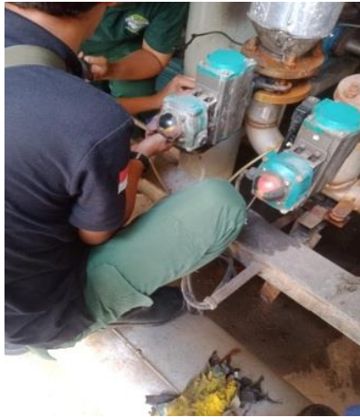
Gambar 2.50 Ganti Solenoid Aktuator Sumber: (Dokumentasi, 2023)
