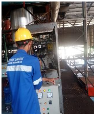
Gambar 2. 14 Pembersihan panel
