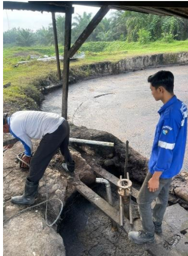
Gambar 2. 58 pemasangan elmots 1,5 kw pada stasiun ETP
