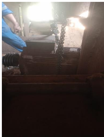
Gambar 2. 51 Memasang elmots 55 kw devertaper
