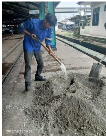
Gambar 2. 57 pengecoran pada loading ramp
