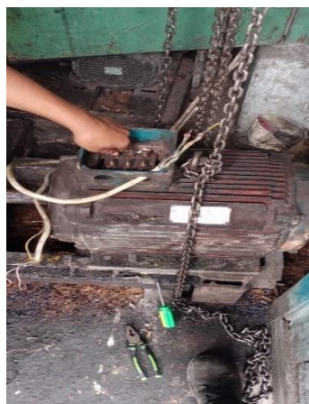
Gambar 2. 61 pemasanga elmots 22 kw pada stasiun cpo
