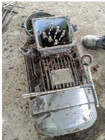
Gambar 2. 71 Pemasangan elmots 22 kw
