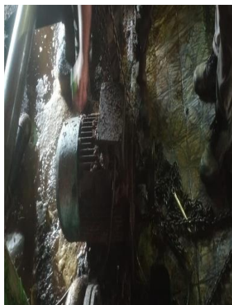
Gambar 2. 43 Penggantian elmots 15 kw
