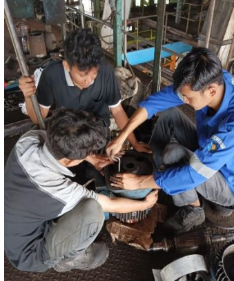
Gambar 2. 62 Pemasangan elmots crean dengan daya 7,5 kw
