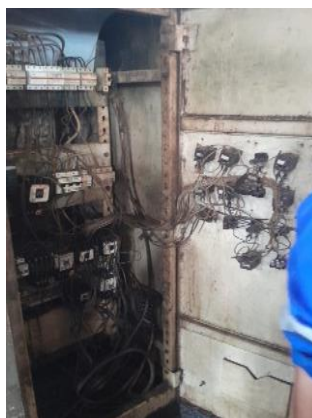
Gambar 2. 8 Penggantian push button
