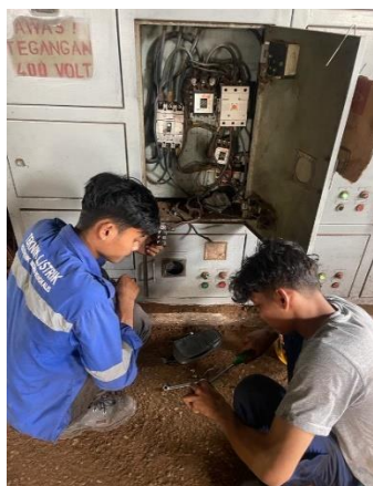
Gambar 2. 53 Pemasangan over load
