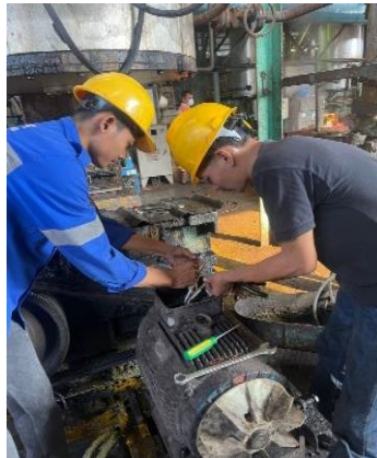
Gambar 2. 31 Pemasangan elmots 45 kw
