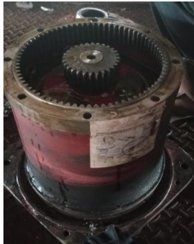
Gambar 2. 70 Perbaikan gear box
