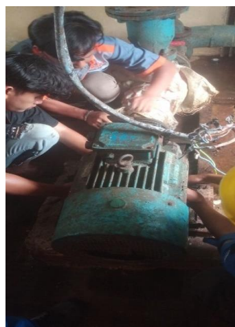
Gambar 2. 47 Pemasangan elmots 22 kw pada wtp
