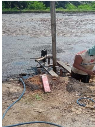
Gambar 2. 15 Pemasangan pompa pada waduk
