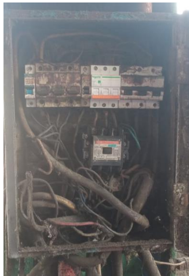
Gambar 2. 67 Pemasngan mcb pada stasiun loding ramp
