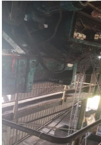
Gambar 2. 44 Pemasangan elmots 7,5 kw
