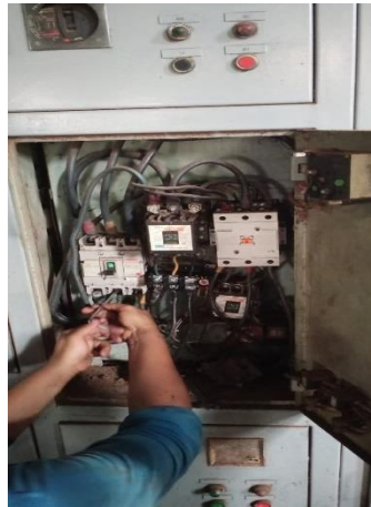
Gambar 2. 52 Pengecekan breaker
