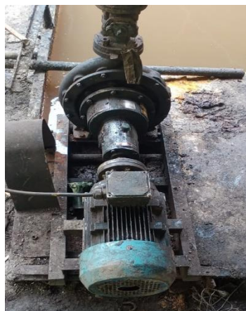
Gambar 2. 63 Pemasangan elmots conveyer dengan daya 7,5 kw
