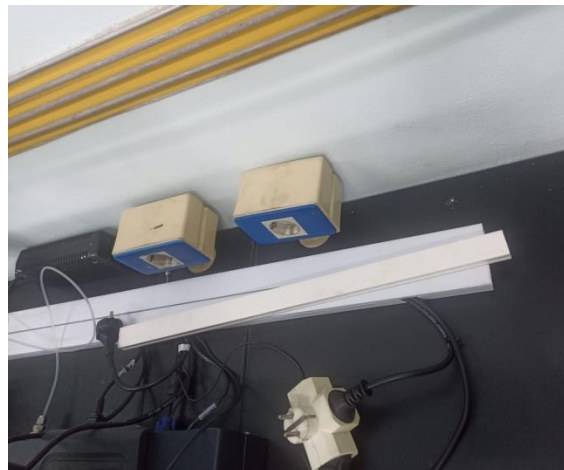
Gambar 2. 10 pemasangan cable tray
