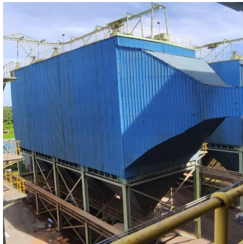
Gambar 3.1 Electrostatic Precipitator (ESP) (Sumber : Dokumentasi di PT Sari Dumai Sejati)
