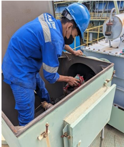
Gambar 4.6 Preventive Maintenance Isolator ESP (Sumber : Dokumentasi PT Sari Dumai Sejati)
