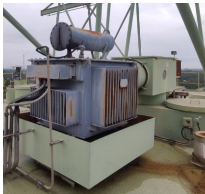
Gambar 3.9 Rectifier Transformer
