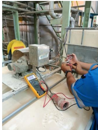
Gambar 2.40 Pengecekan dan Perbaikan Kabel Motor Agitator
