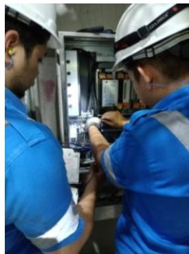
Gambar 2.12Perbaikan Power Suply Jet Drive 24 v
