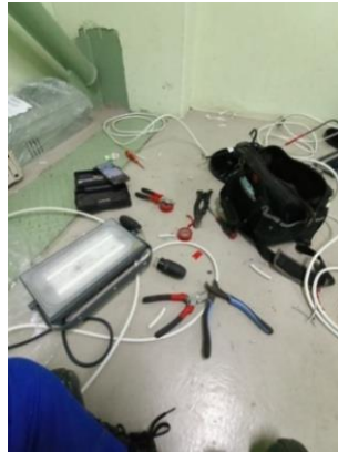
Gambar 2.19 Prepare Portable Lightning Untuk Shut Down
