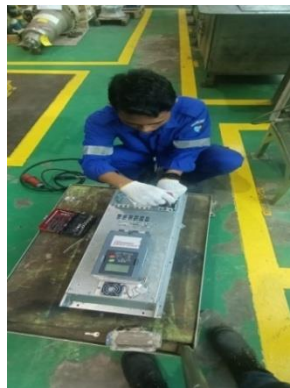
Gambar 2.16 Pengujian Variable Speed Drive Menggunakan Motor (Sumber: Dokumentasi PT. Riau Andalan Pulp and Paper Pangkalan Kerinci, 2023)
