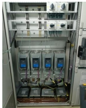
Gambar 2.26 Penggantian Kabel ProFibus
