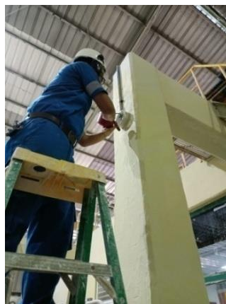
Gambar 2.7 Pemasangan Horn atau Alarm Indikasi Pompa Motor
