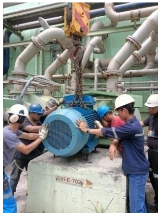
Gambar 2.42 Penggantian Motor Vaccum Pump 531 E 702
