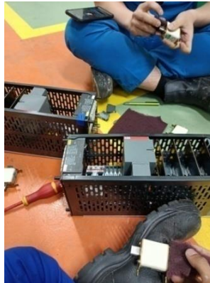
Gambar 2.22 Pengecekan Dan Pembersihan Modul Stater
