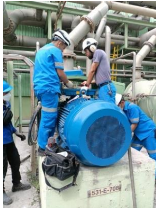
Gambar 2.43 Penggantian Motor Vaccum Pump 531 E 708
