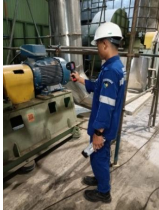
Gambar 2.15 Pengukuran dan Pengecekan Temperature Motor 3 Phasa (Sumber: Dokumentasi PT. Riau Andalan Pulp and Paper Pangkalan Kerinci, 2023)
