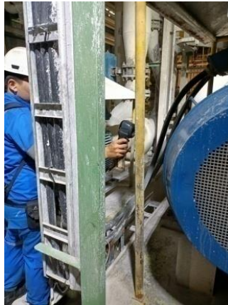
Gambar 2.33 Pengukuran Temperature Motor Listrik
