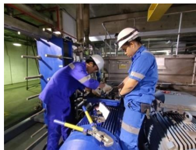
Gambar 2.55 Terminasi Kabel Pada MotorHydraulic
