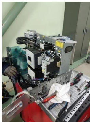
Gambar 2.52 Perbaikan Modul Stater (Sumber: Dokumentasi PT. Riau Andalan Pulp and Paper Pangkalan Kerinci, 2023)
