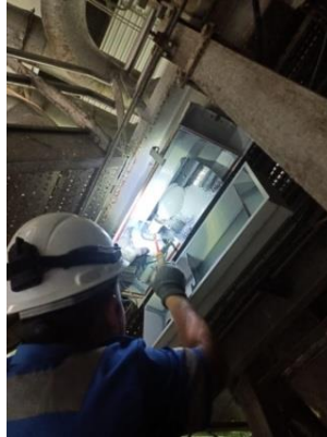
Gambar 2.13 Perbaikan Dan Penggantian Lampu Penerangan
