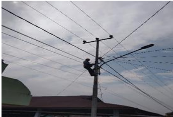
Gambar 2. 40 Penyeimbangan Beban Trafo (Sumber: Dokumentasi Pribadi 2023)
