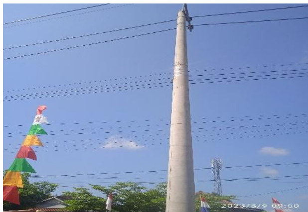
Gambar 3. 5 Tiang Beton (Sumber: Dokumentasi Pribadi 2023)
