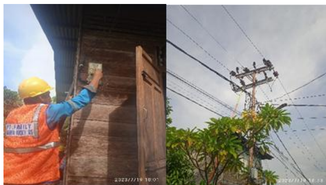
Gambar 2. 30 Penggantian KWH Meter dan FCO (Sumber: Dokumentasi Pribadi 2023)
