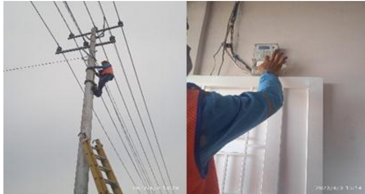
Gambar 2. 37 Mengatasi Gangguan Listrik (Sumber: Dokumentasi Pribadi 2023)
