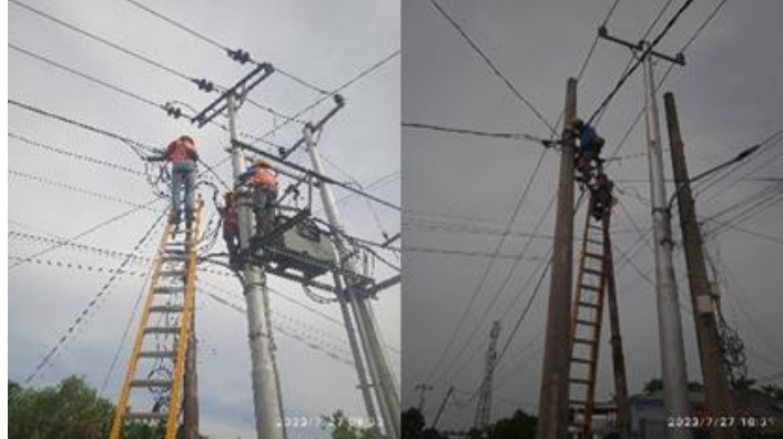
Gambar 2. 34 Pemeliharaan JTR (Sumber: Dokumentasi Pribadi 2023)
