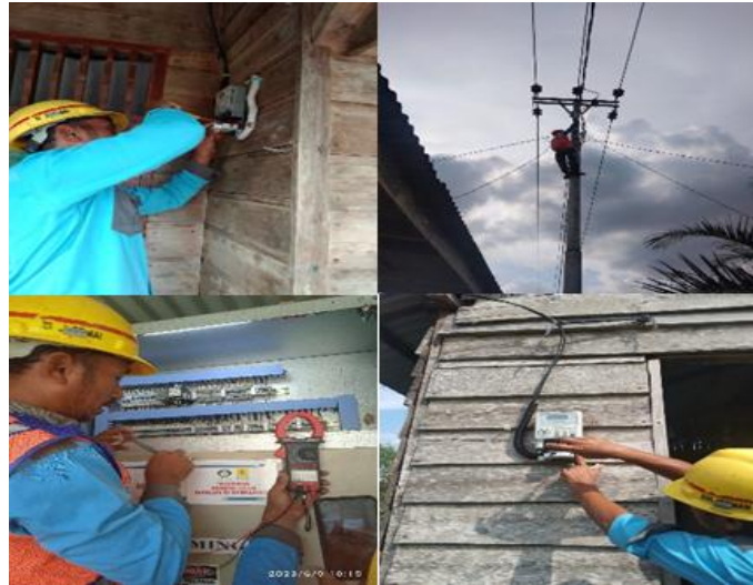
Gambar 2. 4 Memperbaiki KWH Meter (Sumber: Dokumentasi Pribadi 2023)
