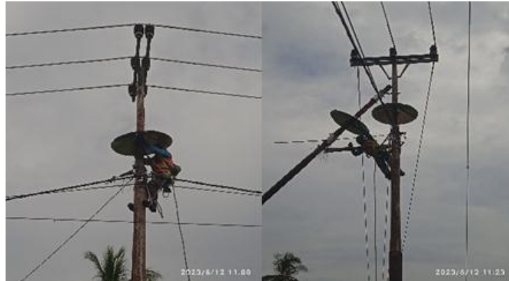
Gambar 2. 5 Pemeliharaan JTM (Sumber: Dokumentasi Pribadi 2023)
