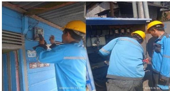
Gambar 2. 11 Mengatasi Gangguan Listrik (Sumber: Dokumentasi Pribadi 2023)
