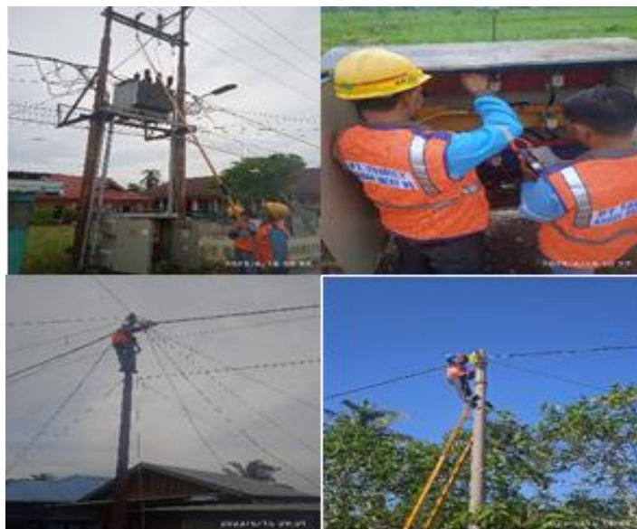
Gambar 2. 8 Pemeliharaan JTR dan Gardu Portal (Sumber: Dokumentasi Pribadi 2023)
