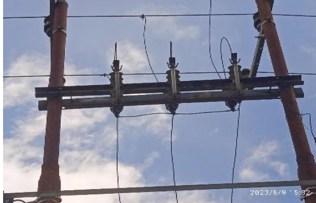
Gambar 3. 12 Fuse Cut Out (FCO) (Sumber: Dokumentasi Pribadi 2023)
