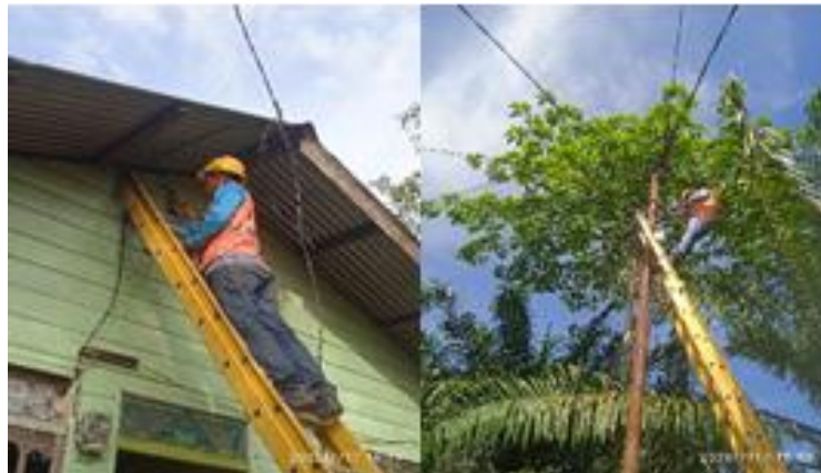
Gambar 2. 28 Memperbaiki Kabel SR (Sumber: Dokumentasi Pribadi 2023)
