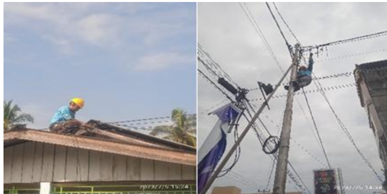
Gambar 2. 20 Mengatasi Gangguan Listrik (Sumber: Dokumentasi Pribadi 2023)
