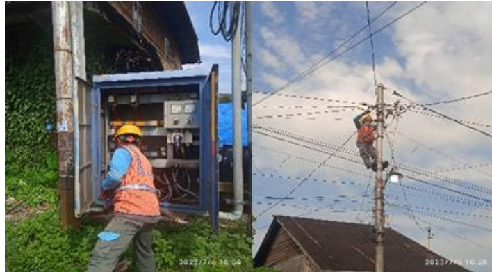
Gambar 2. 21 Penyeimbangan Beban Trafo (Sumber: Dokumentasi Pribadi 2023)
