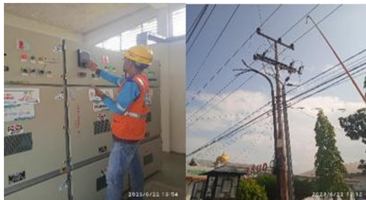
Gambar 2. 13 Mengatasi Gangguan Listrik (Sumber: Dokumentasi Pribadi 2023)
