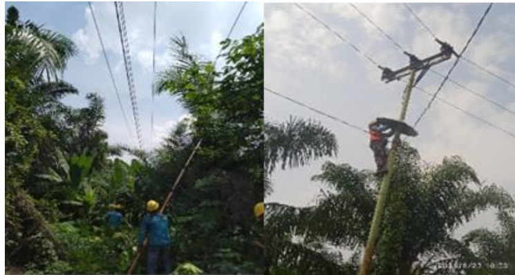
Gambar 2. 50 Pemeliharaan JTM (Sumber: Dokumentasi Pribadi 2023)
