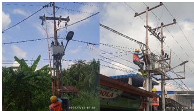
Gambar 2. 25 Perbaikan Kabel SR dan FCO (Sumber: Dokumentasi Pribadi 2023)
