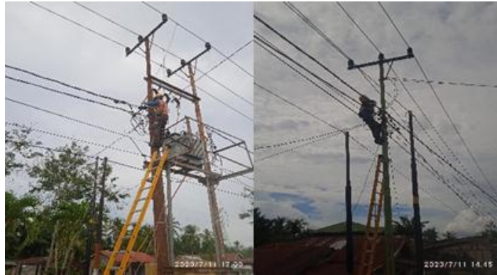
Gambar 2. 24 Pemeliharaan JTR (Sumber: Dokumentasi Pribadi 2023)
