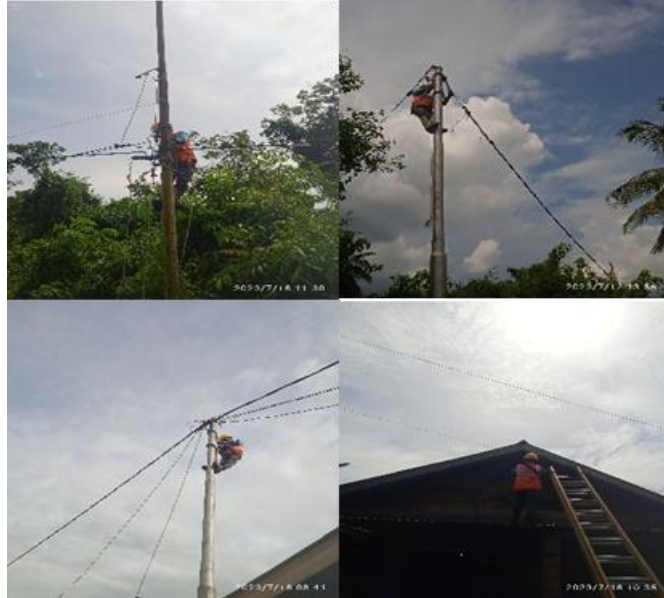
Gambar 2. 29 Mengatasi Gangguan Listrik (Sumber: Dokumentasi Pribadi 2023)
