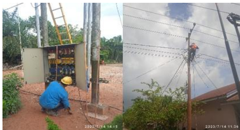
Gambar 2. 27 Pemeliharaan PHBTR (Sumber: Dokumentasi Pribadi 2023)
