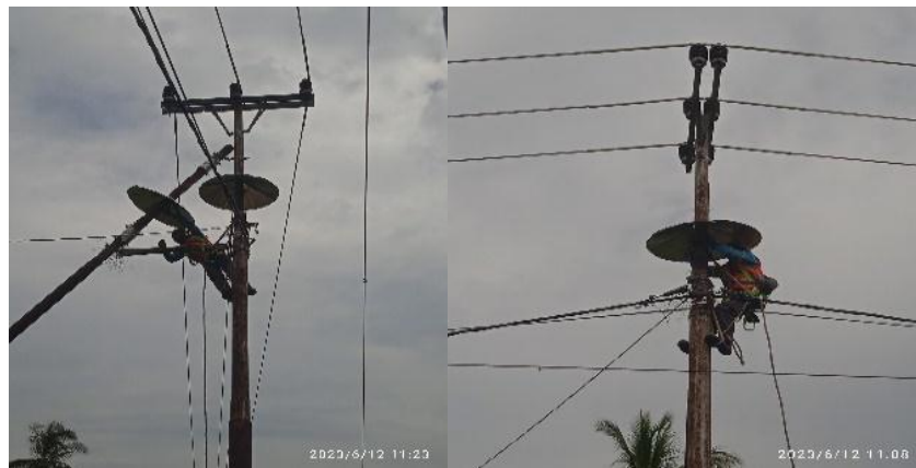
Gambar 3. 3 Pemasangan Tandu Seng (Sumber: Dokumentasi Pribadi 2023)
