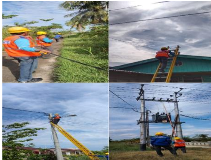
Gambar 2. 3 Mengatasi Gangguan Listrik (Sumber: Dokumentasi Pribadi 2023)
