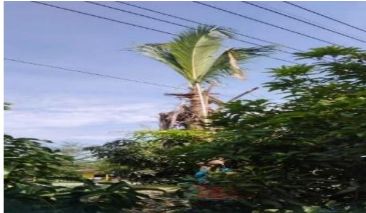
Gambar 3. 2 Pemangkasan Pohon Yang Mengenai JTM (Sumber: Dokumentasi Pribadi 2023)
