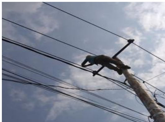
Gambar 2. 39 Mengatasi Gangguan Listrik (Sumber: Dokumentasi Pribadi 2023)
