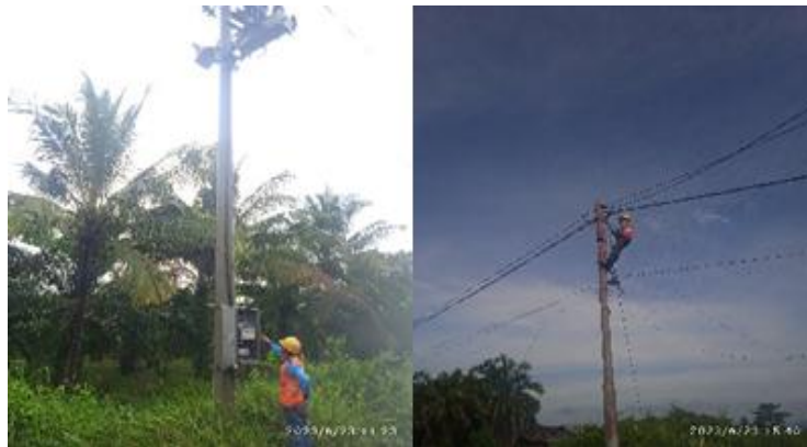
Gambar 2. 14 Mengatasi Gangguan Listrik (Sumber: Dokumentasi Pribadi 2023)
