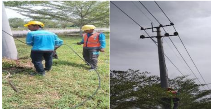
Gambar 2. 1 Pemasangan Grounding Errester (Sumber: Dokumentasi Pribadi 2023)
