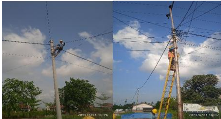
Gambar 2. 12 Pemeliharaan JTR (Sumber: Dokumentasi Pribadi 2023)
