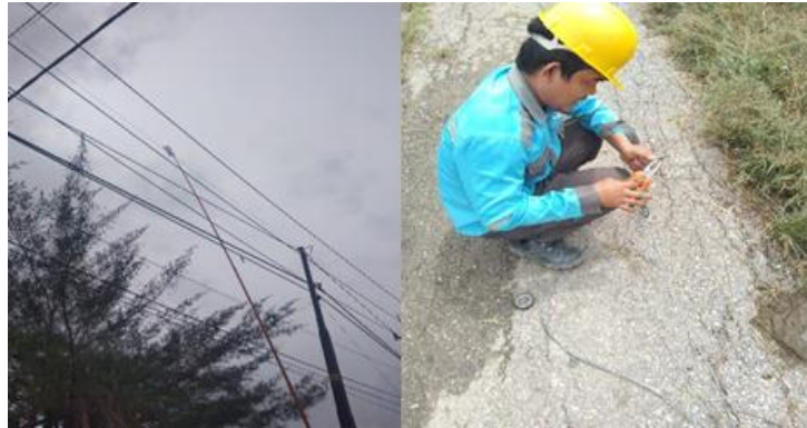
Gambar 2. 17 Mengatasi Gangguan Listrik (Sumber: Dokumentasi Pribadi 2023)
