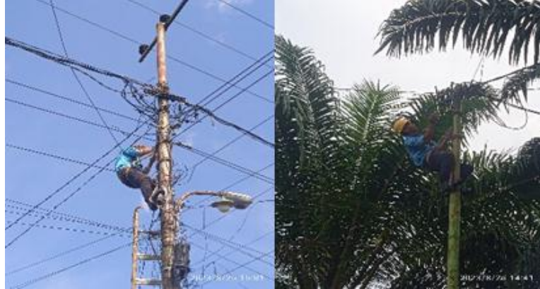
Gambar 2. 52 Mengatasi Gangguan Listrik (Sumber: Dokumentasi Pribadi 2023)
