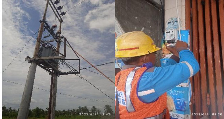
Gambar 2. 7 Mengatasi Gangguan Listrik (Sumber: Dokumentasi Pribadi 2023)
