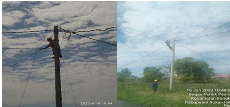
Gambar 2. 9 Pemeliharaan JTR (Sumber: Dokumentasi Pribadi 2023)
