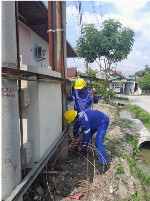
Gambar 2.15 pemasangan gronding
