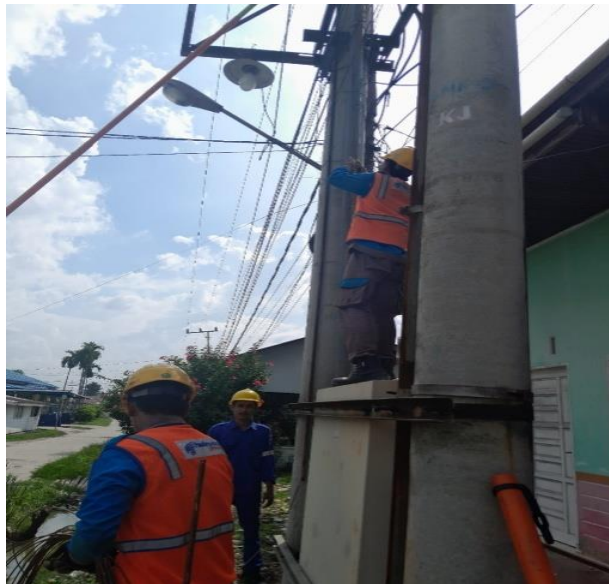
Gambar 2.16 pemasangan gronding
