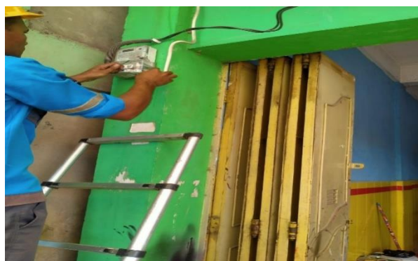
Gambar 2.37 perbaikan kwh 1 phase.
