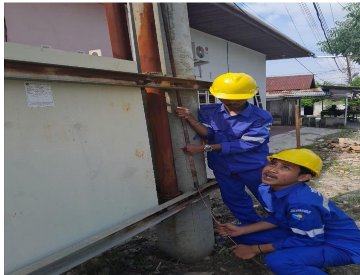
Gambar 2.10 pemasangan gronding
