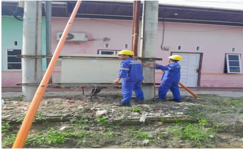
Gambar 2.12 pemasangan gronding
