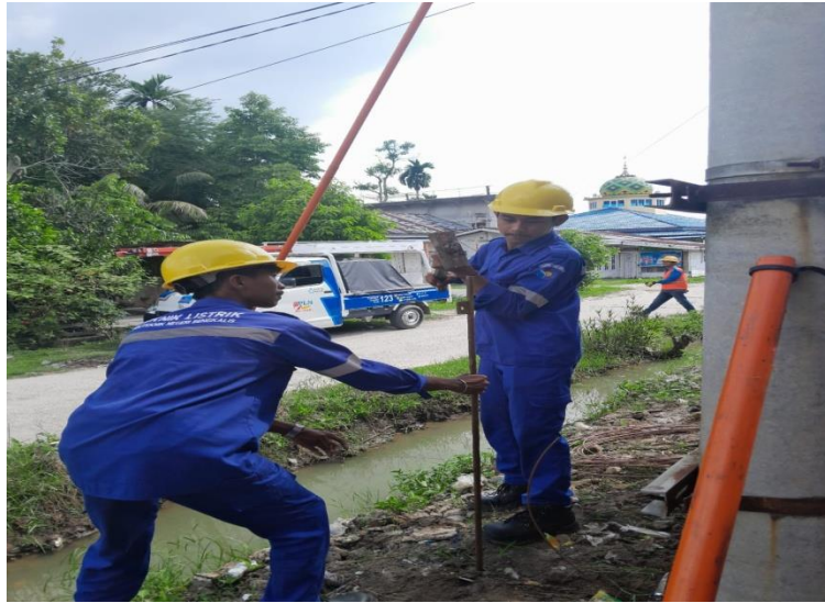
Gambar 2.11 pemasangan gronding.
