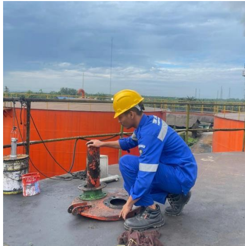
Gambar 2. 9 Perbaikan Pada Tanki Minyak (Sumber: Dokumentasi di PT. Perkebunan Nusantara V)
