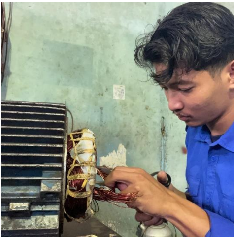
Gambar 2. 64 Membongkar Motor Induksi (Sumber: Dokumentasi di PT. Perkebunan Nusantara V)
