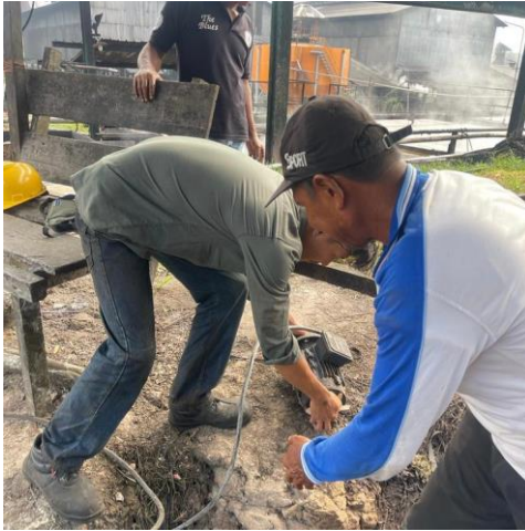
Gambar 2. 57 Memasang Motor Induksi (Sumber: Dokumentasi di PT. Perkebunan Nusantara V)
