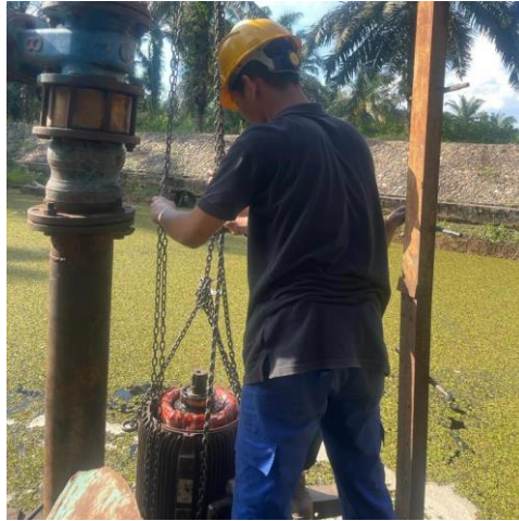
Gambar 2. 19 Mengganti Motor Induksi 3 Phasa (Sumber: Dokumentasi di PT. Perkebunan Nusantara V)
