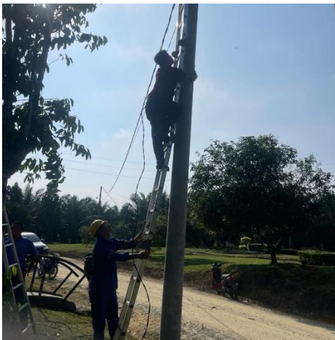
Gambar 2. 66 Memasang Instalasi Penerangan (Sumber: Dokumentasi di PT. Perkebunan Nusantara V)
