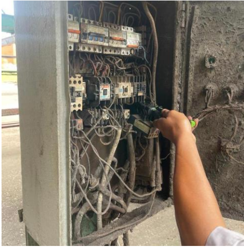
Gambar 2. 69 Mengganti Kontaktor (Sumber: Dokumentasi di PT. Perkebunan Nusantara V)
