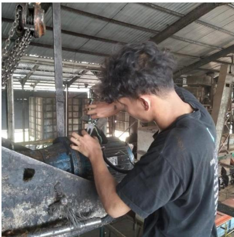
Gambar 2. 52 Memasang Motor Induksi (Sumber: Dokumentasi di PT. Perkebunan Nusantara V)
