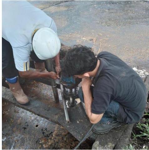
Gambar 2. 31 Mengganti Motor Induksi 3 Phasa (Sumber: Dokumentasi di PT. Perkebunan Nusantara V)
