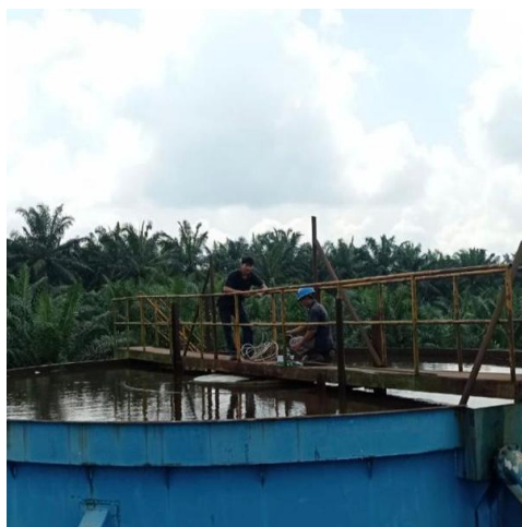
Gambar 2. 32 Memasang Lampu (Sumber: Dokumentasi di PT. Perkebunan Nusantara V)
