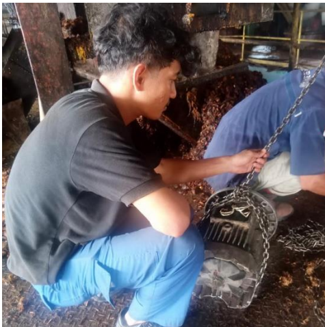
Gambar 2. 42 Memasang Motor Induksi (Sumber: Dokumentasi di PT. Perkebunan Nusantara V)
