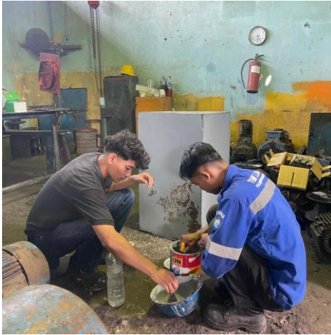
Gambar 2. 37 Perbaikan Panel (Sumber: Dokumentasi di PT. Perkebunan Nusantara V)
