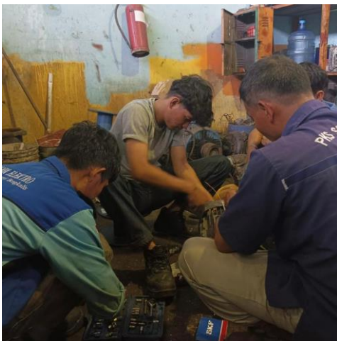
Gambar 2. 40 Mengetes Motor Induksi (Sumber: Dokumentasi di PT. Perkebunan Nusantara V)
