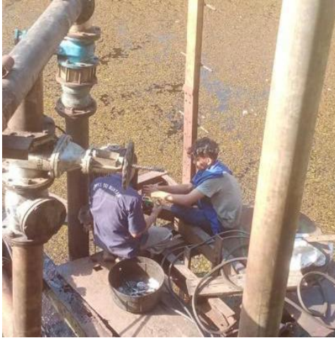
Gambar 2. 49 Memasang Motor Induksi (Sumber: Dokumentasi di PT. Perkebunan Nusantara V)
