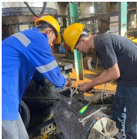
Gambar 2. 30 Memasang Motor Induksi 3 Phasa (Sumber: Dokumentasi di PT. Perkebunan Nusantara V)
