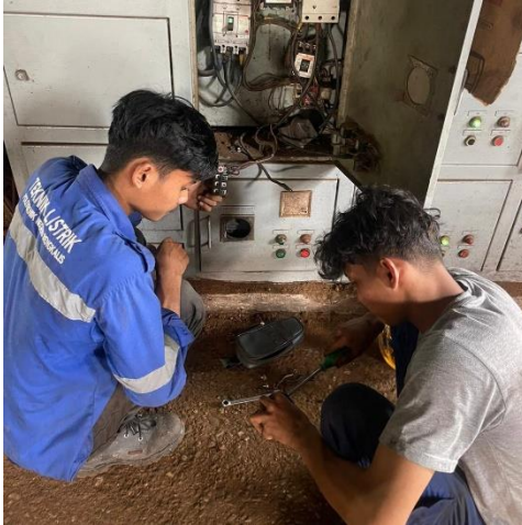
Gambar 2. 51 Memasang Overload (Sumber: Dokumentasi di PT. Perkebunan Nusantara V)
