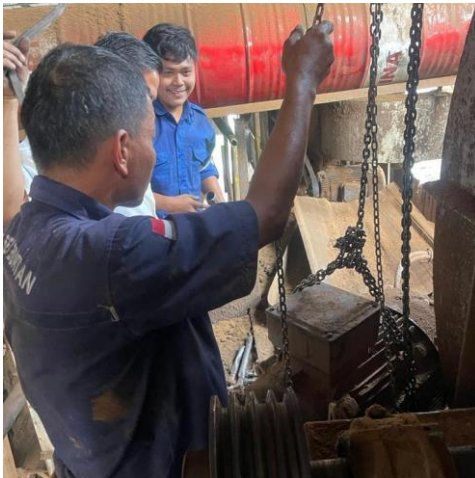
Gambar 2. 50 Memasang Motor Induksi (Sumber: Dokumentasi di PT. Perkebunan Nusantara V)
