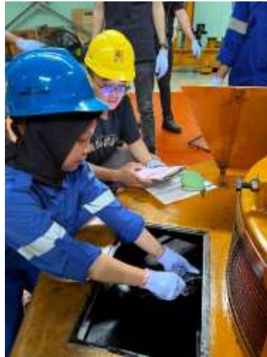
Gambar 2.38 Pengukuran Carbon Brush
