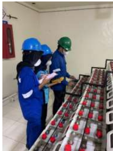
Gambar 4.14 Pengukuran tegangan baterai
