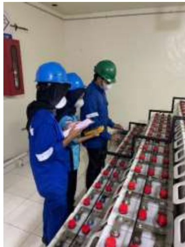
Gambar 2.9 Pengukuran pada Baterai Basah
