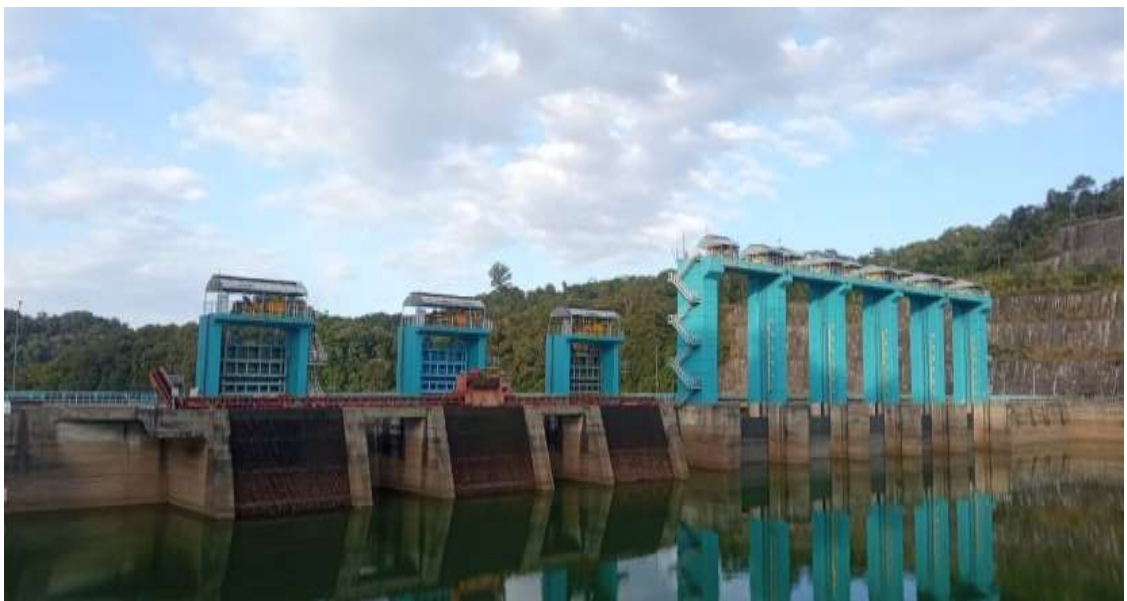
Gambar 3.2 Bendungan ULPLTA Koto Panjang
