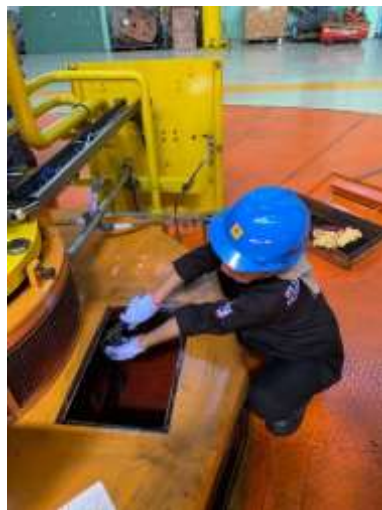
Gambar 2.24 Pengukuran carbon brush
