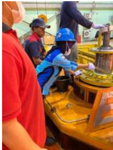
Gambar 2.13 Perbaikan pada generator
