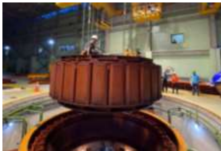
Gambar 3.8 Rotor pada ULPLTA Koto Panjang (Sumber : Arsip Perusahaan)
