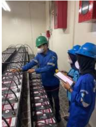
Gambar 2.6 Pengukuran Pada Baterai Kering
