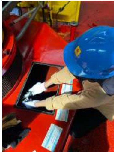
Gambar 2.36 Pengukuran Carbon Brush
