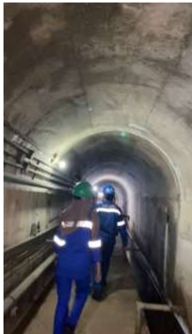
Gambar 2.5 Pengecekan Dam Galeri
