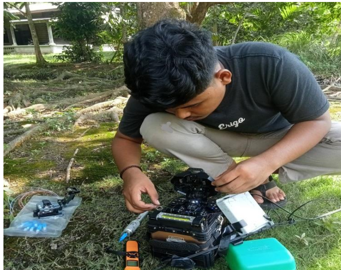
Gambar 3.2 Pemasangan kabel Fiber Optic
