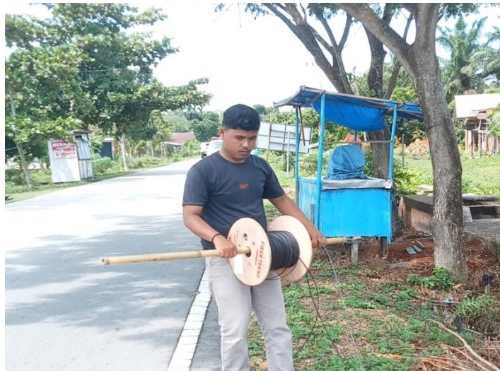
Gambar 3.1 Penarikan Kabel Fiber optic
