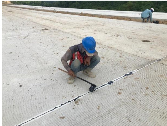
Gambar 4.17 Pengisian Sambungan (Joint Sealant) (sumber: dokumentasi kerja praktek 2023)
