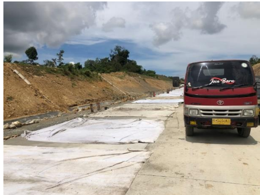
Gambar 4.18 Perawatan Beton (curing) (sumber: dokumentasi kerja praktek 2023)
