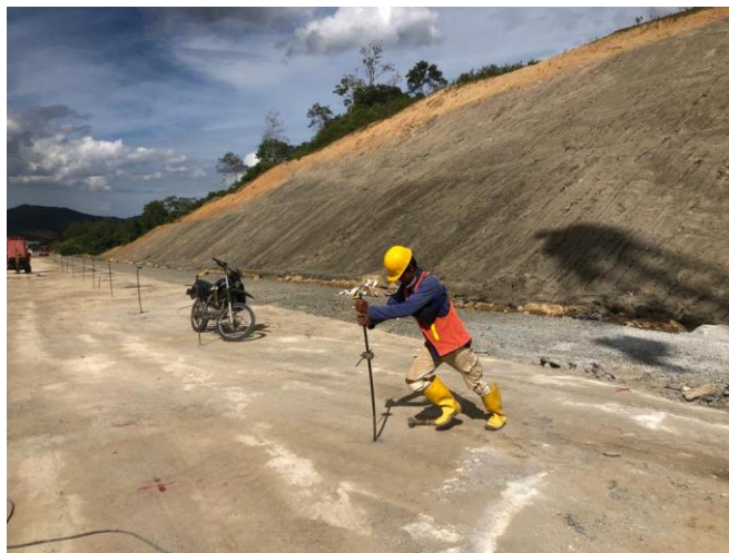
Gambar 4.2 Persiapan String line (sumber: dokumentasi kerja praktek 2023)
