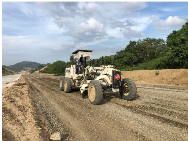
Gambar 3.8 Pekerjaan Penghamparan Base A (sumber: dokumentasi kerja praktek 2023)
