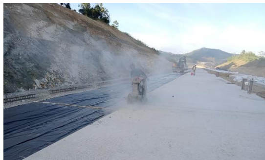
Gambar 4.16 Pekerjaan Cutting Beton (sumber: dokumentasi kerja praktek 2023)
