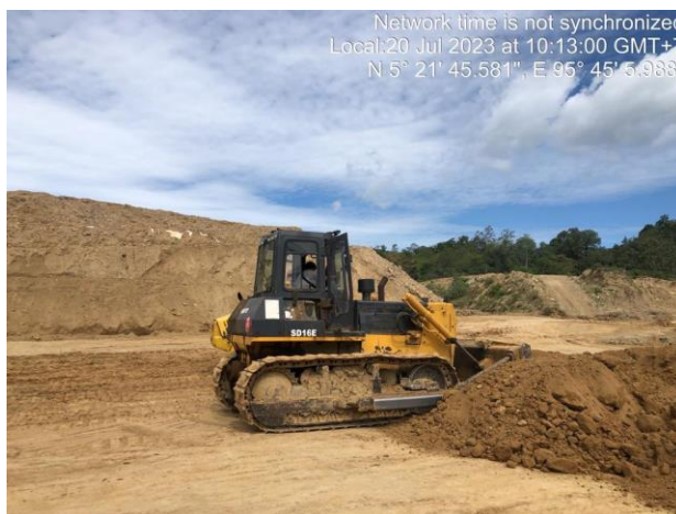
Gambar 3.2 Pekerjaan Perataan Tanah Dengan Bulldozer (sumber: dokumentasi kerja praktek 2023)
