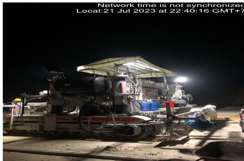
Gambar 4.5 Persiapan Concrete Paver (sumber: dokumentasi kerja praktek 2023)
