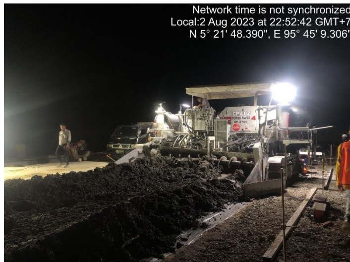
Gambar 3.10 Pekerjaan Rigid Pavement (sumber: dokumentasi kerja praktek 2023)
