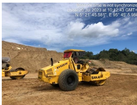
Gambar 3.3 Pekerjaan Pemadatan Tanah Dengan Sheeps Foot Roller (sumber: dokumentasi kerja praktek 2023)
