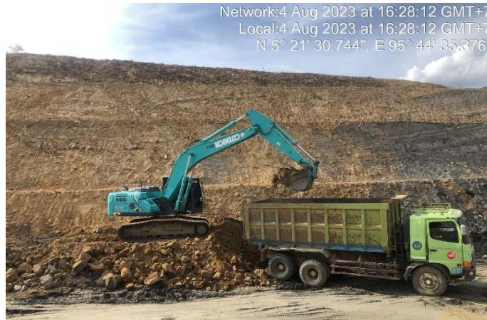
Gambar 3.1 Pekerjaan Galian (sumber: dokumentasi kerja praktek 2023)
