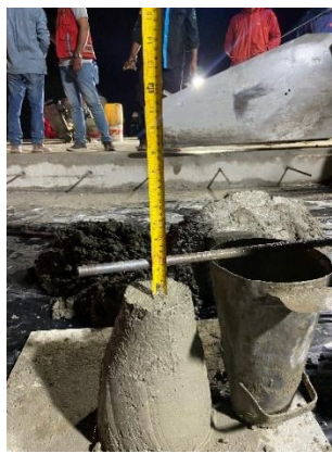
Gambar 4.7 Pengujian Slump (sumber: dokumentasi kerja praktek 2023)
