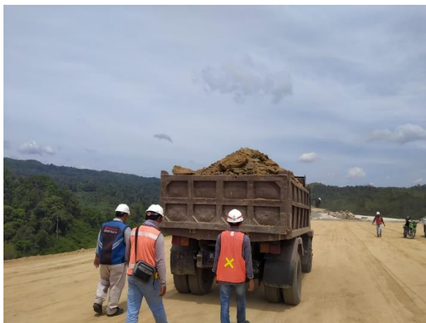
Gambar 3.6 Pengujian ProofRolling Top Subgrade (sumber: dokumentasi kerja praktek 2023)
