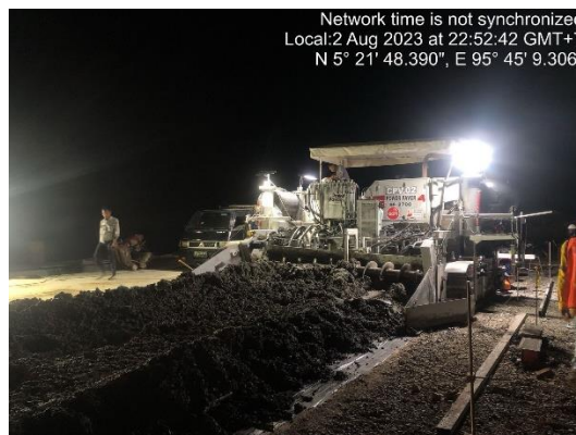
Gambar 4.11 Penghamparan Beton (sumber: dokumentasi kerja praktek 2023)
