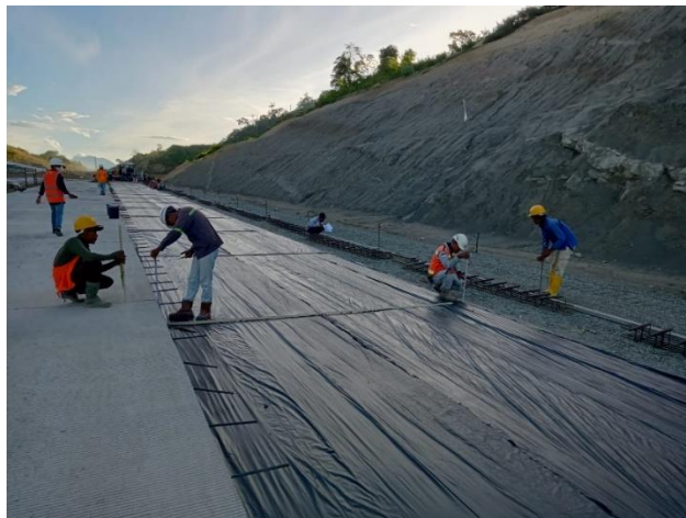
Gambar 4.4 Pemasangan Plastik Beton (sumber: dokumentasi kerja praktek 2023)
