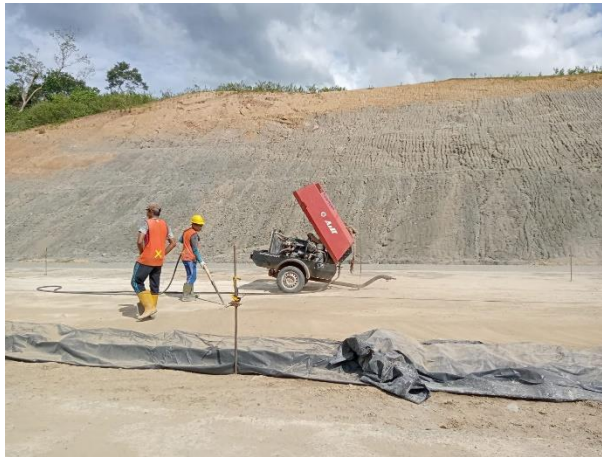
Gambar 4.3 Pekerjaan Pembersihan (sumber: dokumentasi kerja praktek 2023)
