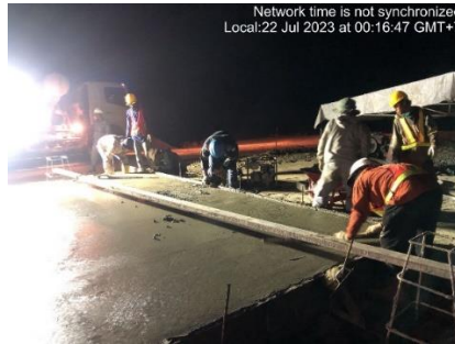
Gambar 4.12 Pekerjaan Finishing (sumber: dokumentasi kerja praktek 2023)
