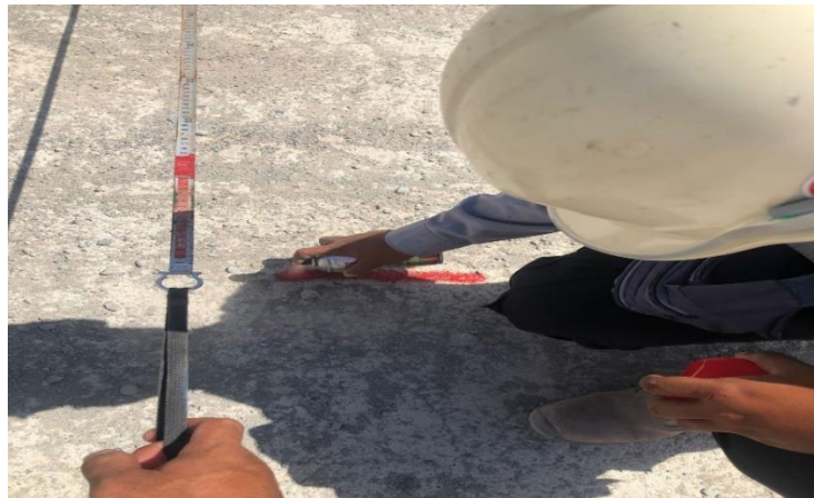
Gambar 4.1 Staking Out (sumber: dokumentasi kerja praktek 2023)
