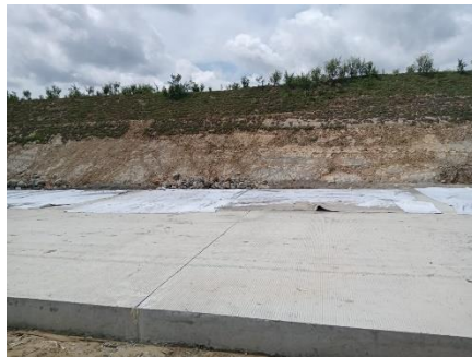
Gambar 4.15 Pemasangan Geotex (sumber: dokumentasi kerja praktek 2023)
