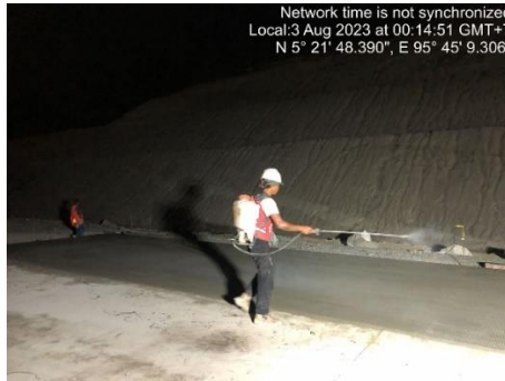
Gambar 4.14 Curing Beton Dengan Curing Compound (sumber: dokumentasi kerja praktek 2023)
