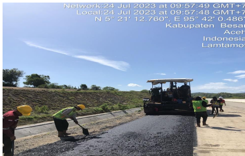
Gambar 3.11 Pekerjaan Aspal (sumber: dokumentasi kerja praktek 2023)
