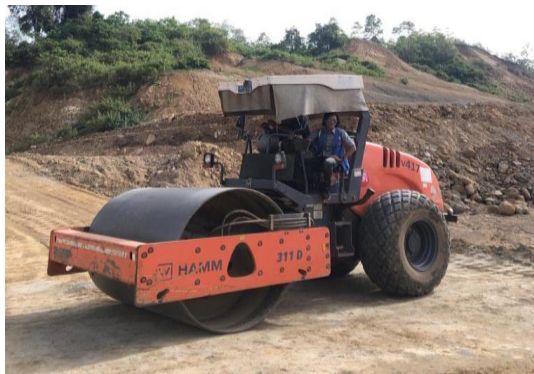
Gambar 3.4 Pekerjaan Pemadatan Tanah Dengan Smooth Roller (sumber: dokumentasi kerja praktek 2023)
