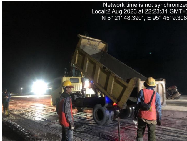
Gambar 4.6 Mobilisasi Beton (sumber: dokumentasi kerja praktek 2023)
