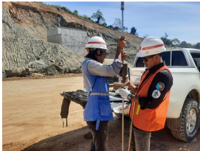
Gambar 3.7 Pengujian Dynamic Cone Penetrometer (sumber: dokumentasi kerja praktek 2023)
