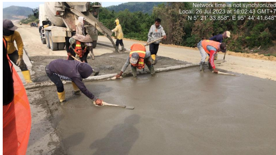
Gambar 3.9 Pekerjaan Lean Concrete (sumber: dokumentasi kerja praktek 2023)
