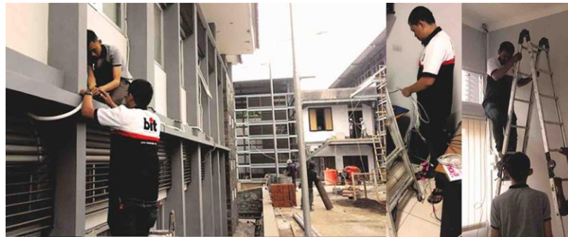
Gambar 3.8 Memasang Acces Point dan Kabel UTP
