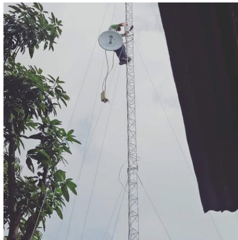
Gambar 3.13 Memasang Antena LDF
