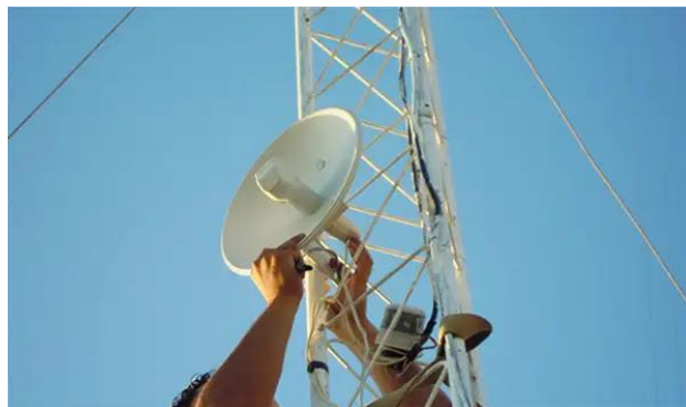
Gambar 3.3 Memasang Antena LHG
