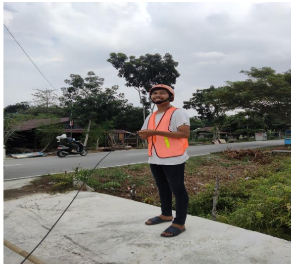
Gambar 3. 1 Penarikan Kabel Fiber optic
