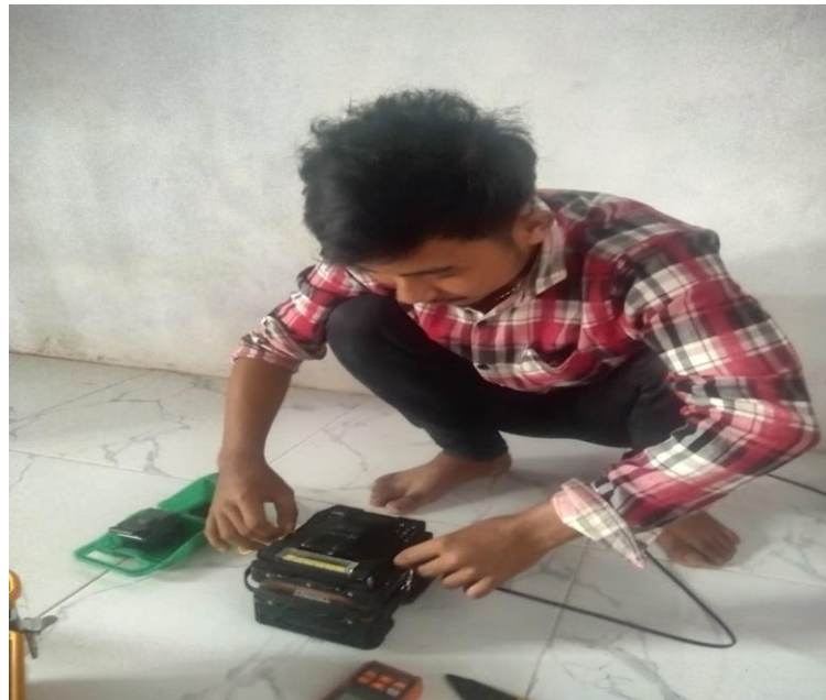
Gambar 3. 2 Pemasangan kabel Fiber Optic
