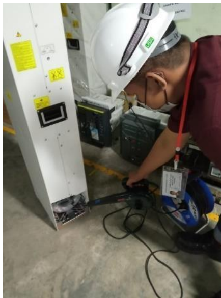
Gambar 3.18 Kegiatan Cleaning Sebagai Preventive Maintenance
