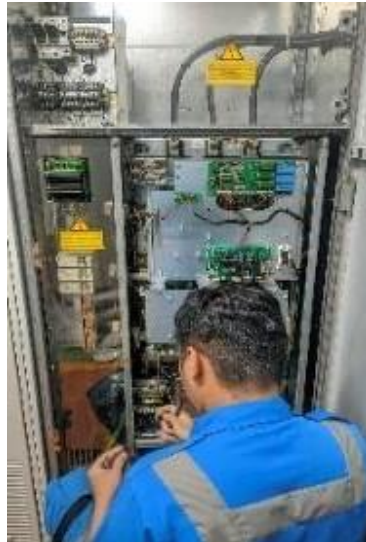
Gambar 2.10 Pengantian igbt
