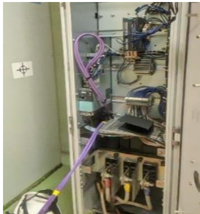
Gambar 2.6 Pengantian Kabel ProfiBus
