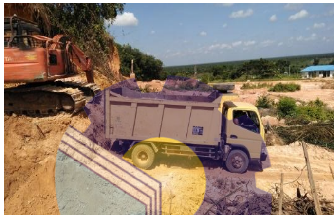
Gambar 4.1 Pengambilan Tanah Timbunan
