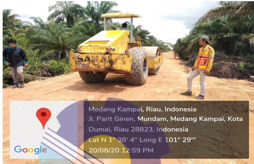
Gambar 4.8 Pemadatan tanah timbunan
