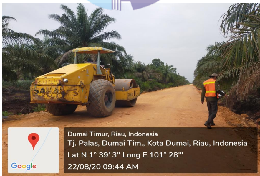
Gambar 4.4 Vibro Roller
