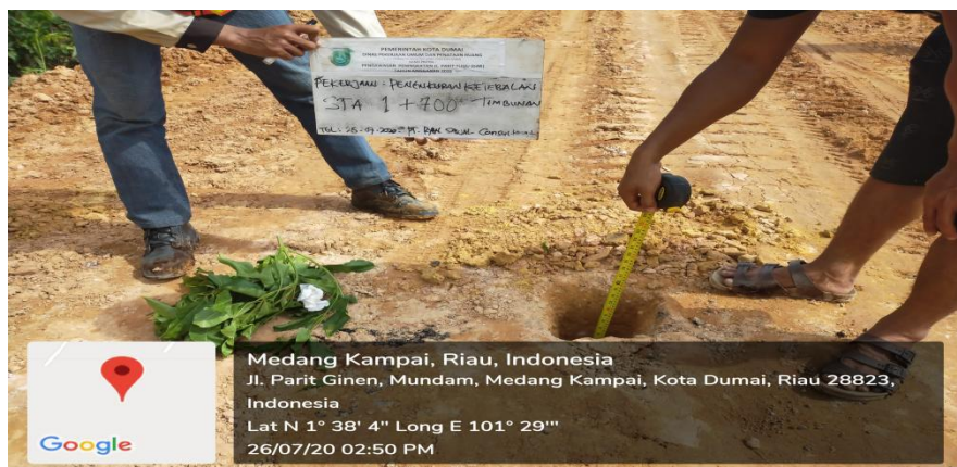
Gambar 4.11 Pengukuran kedalaman
