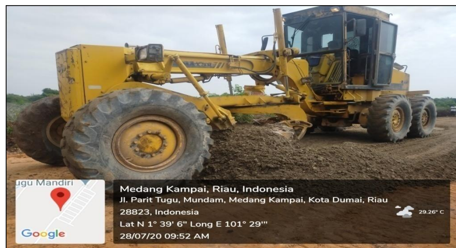
Gambar 3.3 Penghamparan Base Kelas A Menggunakan Motor Grader
