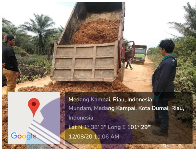
Gambar 4.6 Penghamparan tanah timbunan
