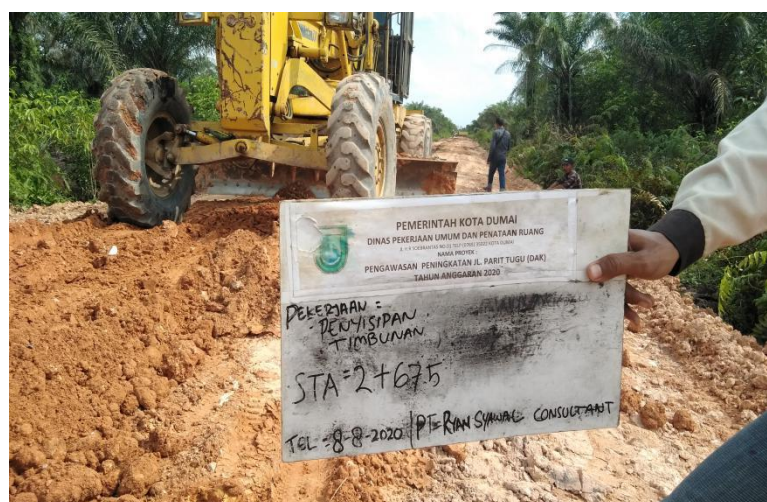
Gambar 4.7 Meratakan tanah timbunan
