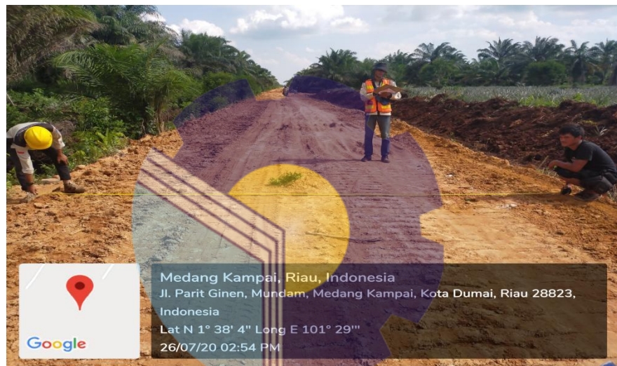
Gambar 4.10 Pengukuran lebar
