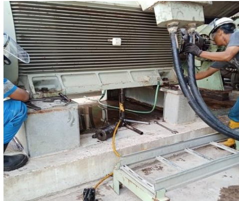
Gambar 4.38 Setting shim plate Sumber : Como RPL. Office, PT. RAPP
