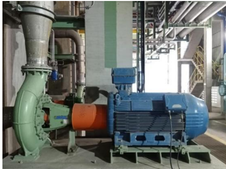
Gambar 4.28 Mesin Off Sumber : Como RPL. Office, PT. RAPP
