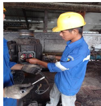
Gambar2. 26 mengatrol motor pres dan motor digester dan memasang pada motor digester
