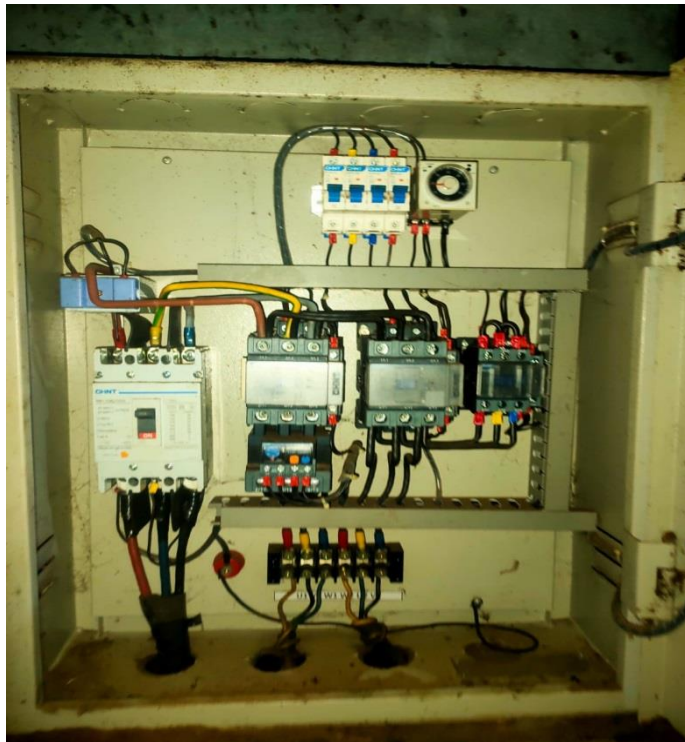
Gambar 4. 10 Rangkaian panel star dan delta
