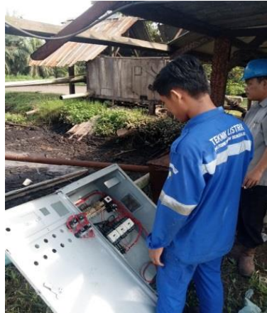
Gambar2. 66 mengganti panel pada pengutipan limbah
