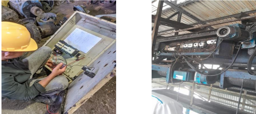
Gambar2. 4 Merangkai panel secara star dan delta, Pemasangan crane
