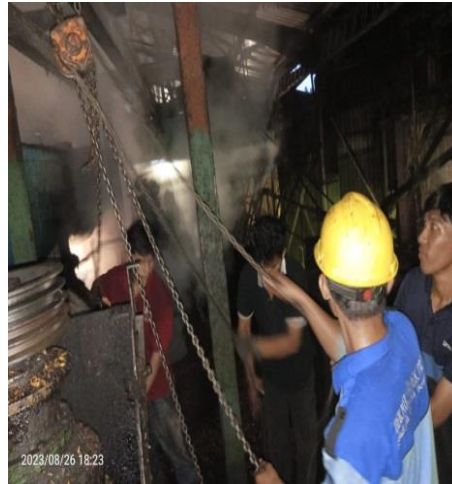
Gambar2. 65 Memasang motor Digester
