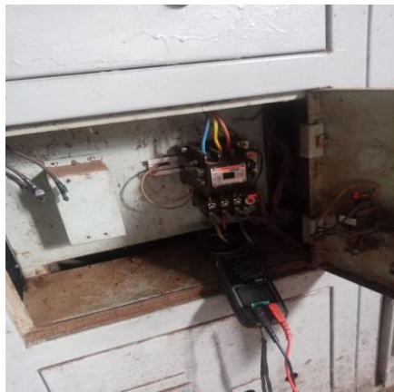
Gambar2. 46 Pergantian overload pada panel untuk rippel mill
