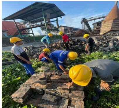
Gambar2. 10 Menyusun batu bata sisa pembakaran boiler
