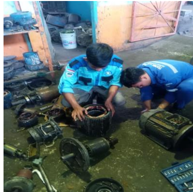
Gambar2. 6 Pembongkaran motor 3 phasa 7,5kw
