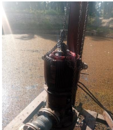
Gambar2. 44 mengganti motor raw water
