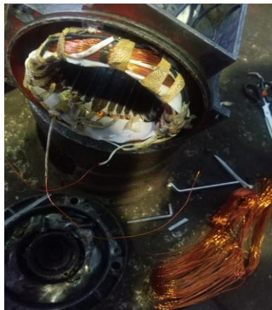
Gambar2. 24 pembongkaran motor pompa 3 phasa
