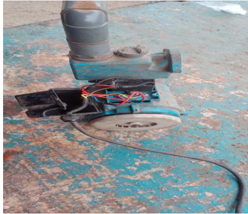
Gambar2. 32 Perbaikan pompa air
