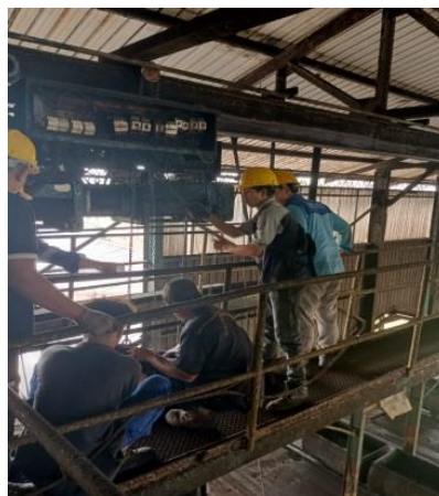
Gambar2. 42 Penggantian motor pada crane
