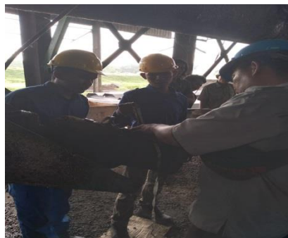
Gambar2. 7 mengganti motor 3 phasa pada convayer
