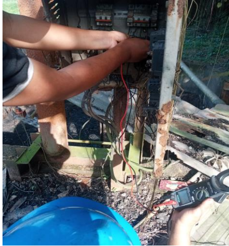
Gambar2. 34 Perbaikan pada panel pada pompa pembuangan limbah
