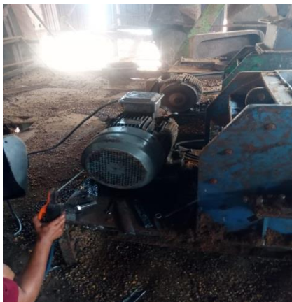
Gambar2. 48 Memasang motor ripple mill 3 phasa
