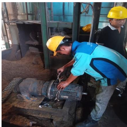
Gambar2. 38 Penggantian motor conveyor
