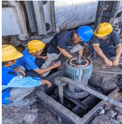
Gambar2. 37 Penggantian motor Pompa kondensat untuk rebusan
