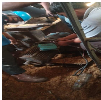
Gambar2. 17 mengganti motor
