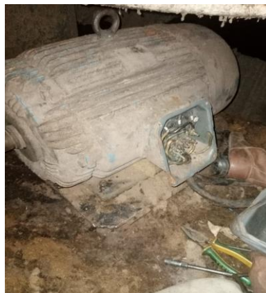
Gambar2. 2 menggantian motor 3phasa
