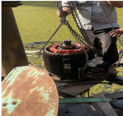
Gambar2. 18 mengganti motor raw water
