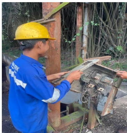
Gambar2. 67 mengganti tempat panel dan panel untuk pembuangan limbah
