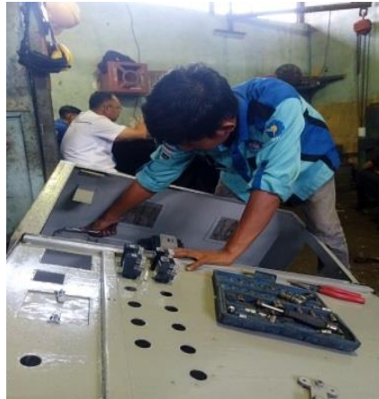
Gambar2. 36 persiapan tempat panel Star delta untuk motor pompa limbah
