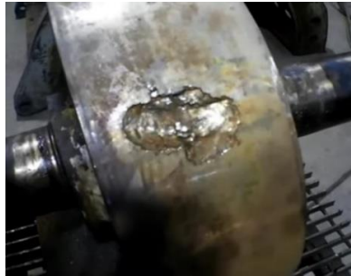
Gambar 2.7 Kerusakan Pada Trunnion Wheels (Sumber: https://youtu.be/nzNucTBOXRA )
