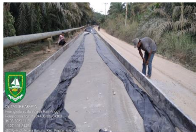
Gambar 3. 14 Pemasangan Bekisting Rigid Sumber : Dokumentasi KP,2023
