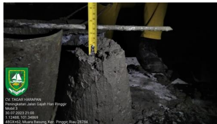
Gambar 3. 17 Uji Slump Rigit Sumber : Dokumentasi KP,2023
