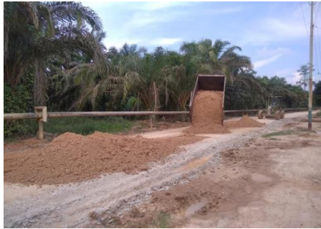
Gambar 3. 7 Pekerjaan Penghamparan Urpil Sumber : Dokumentasi KP,2023
