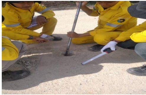
Gambar 3. 9 Pengujian Test Pit Sumber : Dokumentasi KP,2023
