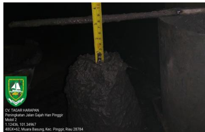
Gambar 3. 13 Uji Slump Lc Sumber : Dokumentasi KP,2023
