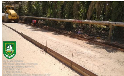
Gambar 3. 11 Pemasangan bekisting Sumber : Dokumentasi KP,2023
