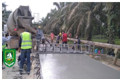
Gambar 3. 16 Pengecoran Rigid Sumber : Dokumentasi KP,2023
