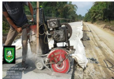
Gambar 3. 19 Cutting Beton Sumber : Dokumentasi KP,2023
