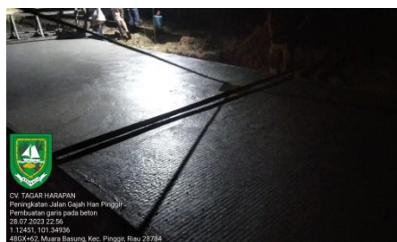
Gambar 3. 18 Grooving Beton Sumber : Dokumentasi KP,2023
