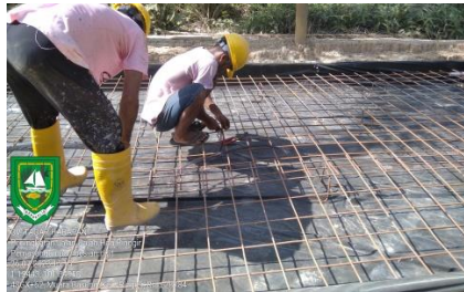
Gambar 3. 15 Pemasangan Tulangan Sumber : Dokumentasi KP,2023
