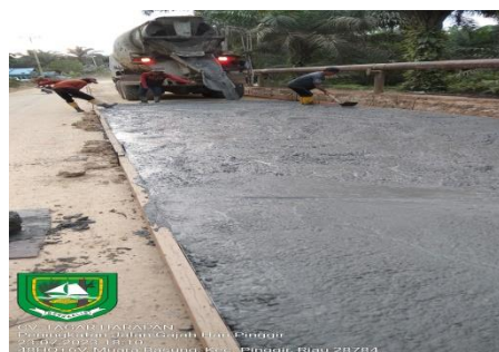
Gambar 3. 12 Pengecoran Lc Sumber : Dokumentasi KP,2023
