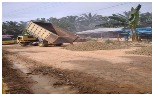
Gambar 3. 8 Pekerjaan Penghamparan Base B Sumber : Dokumentasi KP,2023
