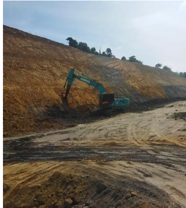
Gambar 3.13 Melakukan Galian (Sumber : Dokumentasi Kerja Praktek,2023)
