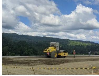
Gambar 3.32 Pemadatan (Sumber : Dokumentasi Kerja Praktek,2023)
