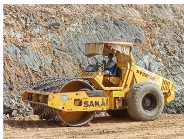
Gambar 3.22 Memadatkan Tanah (Sumber : Dokumentasi Kerja Praktek,2023)
