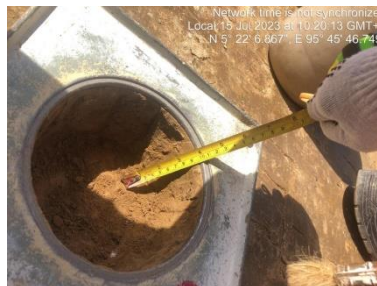
Gambar 3.25 Mengukur Kedalaman (Sumber : Dokumentasi Kerja Praktek,2023)
