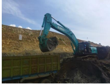
Gambar 4.4 Swing Excavator (Sumber : Dokumentasi Kerja Praktek,2023)
