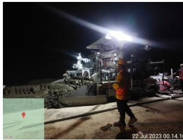
Gambar 3.45 Proses Pengecoran (Sumber : Dokumentasi Kerja Praktek,2023)
