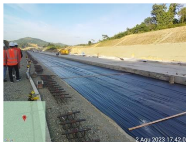
Gambar 3.40 Memasang Plastik (Sumber : Dokumentasi Kerja Praktek,2023)
