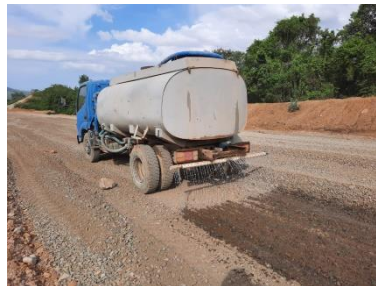
Gambar 3.30 Penyiraman Anggegat (Sumber : Dokumentasi Kerja Praktek,2023)
