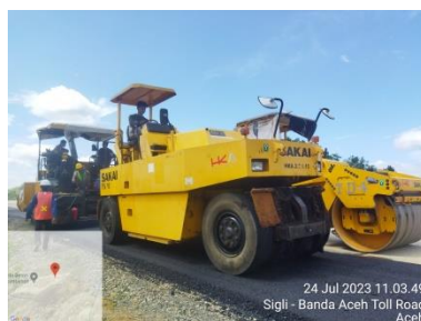
Gambar 3.55 Pemadatan Kedua (Sumber : Dokumentasi Kerja Praktek,2023)
