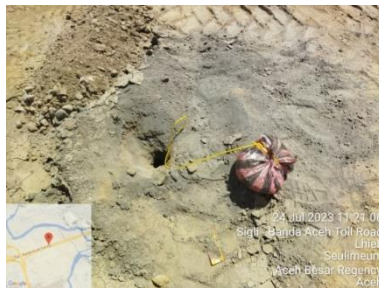
Gambar 3.16 Charging (Sumber : Dokumentasi Kerja Praktek,2023)
