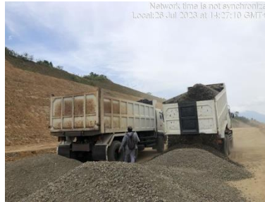
Gambar 3.29 Meletakkan Anggegat (Sumber : Dokumentasi Kerja Praktek,2023)
