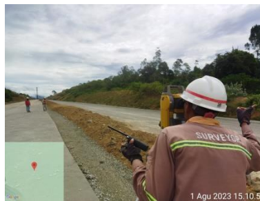
Gambar 3.39 Membuat Titik Patok (Sumber : Dokumentasi Kerja Praktek,2023)
