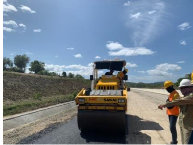
Gambar 3.56 Pemadatan Terakhir (Sumber : Dokumentasi Kerja Praktek,2023)
