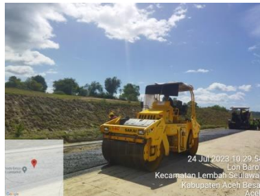
Gambar 3.54 Pemadatan Pertama (Sumber : Dokumentasi Kerja Praktek,2023)
