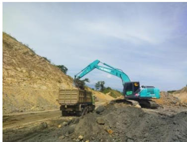
Gambar 4.5 Unload Excavator (Sumber : Dokumentasi Kerja Praktek,2023)
