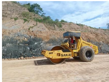
Gambar 3.21 Memadatkan Tanah (Sumber : Dokumentasi Kerja Praktek,2023)
