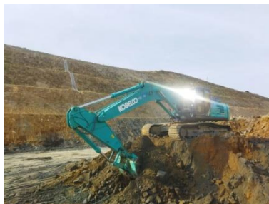
Gambar 4.3 Loading Excavator (Sumber : Dokumentasi Kerja Praktek,2023)
