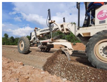
Gambar 3.31 Meratakan Agregat (Sumber : Dokumentasi Kerja Praktek,2023)
