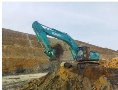
Gambar 3.19 Melakukan Galian (Sumber : Dokumentasi Kerja Praktek,2023)
