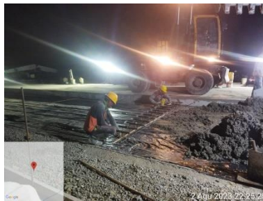
Gambar 3.46 Perletakan Dowel (Sumber : Dokumentasi Kerja Praktek,2023)
