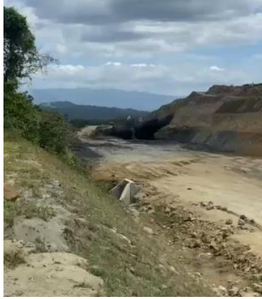
Gambar 3.18 Peledakan (Sumber : Dokumentasi Kerja Praktek,2023)
