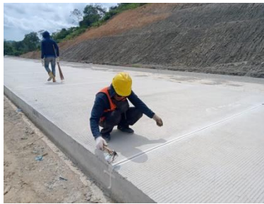
Gambar 3.51 Pengisian Sealent (Sumber : Dokumentasi Kerja Praktek,2023)
