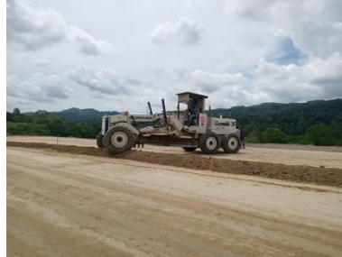
Gambar 3.20 Meratakan Tanah (Sumber : Dokumentasi Kerja Praktek,2023)
