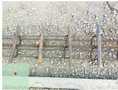
Gambar 3.42 Perisapan Dowel (Sumber : Dokumentasi Kerja Praktek,2023)
