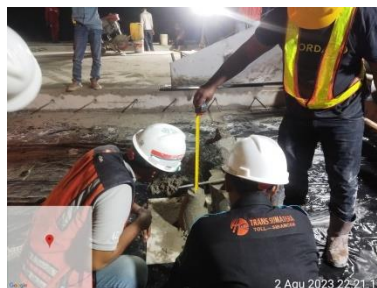
Gambar 3.43 Uji Slump (Sumber : Dokumentasi Kerja Praktek,2023)
