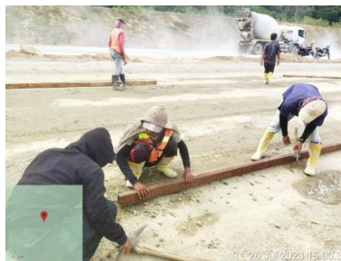
Gambar 3.36 Pemasangan Bekisting (Sumber : Dokumentasi Kerja Praktek,2023)
