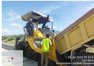
Gambar 3.53 Menuangkan Aspal (Sumber : Dokumentasi Kerja Praktek,2023)
