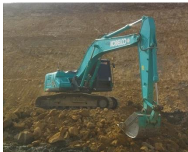
Gambar 3.2 Excavator SK200 (Sumber : Dokumentasi Kerja Praktek,2023)
