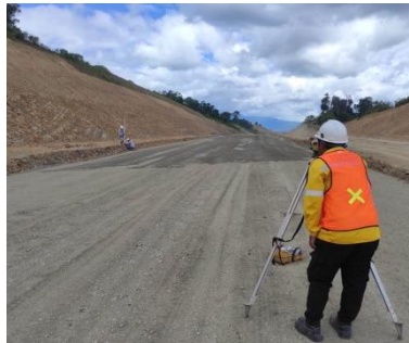
Gambar 3.35 Pembuatan Titik Patok (Sumber : Dokumentasi Kerja Praktek,2023)
