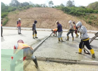
Gambar 3.38 Melakukan Pengecoran (Sumber : Dokumentasi Kerja Praktek,2023)
