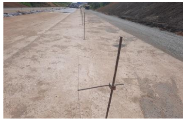
Gambar 3.41 Memasang String Line (Sumber : Dokumentasi Kerja Praktek,2023)
