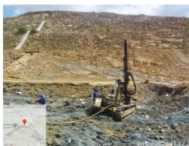
Gambar 3.14 Pengeboran Lobang (Sumber : Dokumentasi Kerja Praktek,2023)
