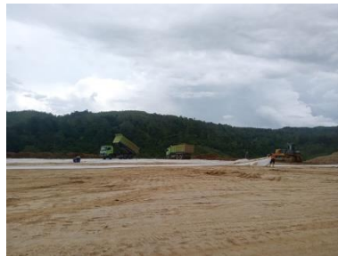
Gambar 3.23 Pemasangan Geotek (Sumber : Dokumentasi Kerja Praktek,2023)
