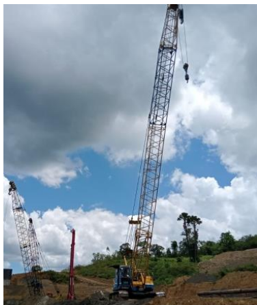
Gambar 3.11 Mobile Crane (Sumber : Dokumentasi Kerja Praktek,2023)
