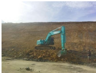
Gambar 4.2 Perisapan Excavator (Sumber : Dokumentasi Kerja Praktek,2023)
