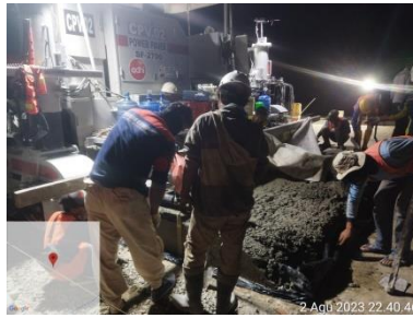
Gambar 3.47 Perataan Secara Manual (Sumber : Dokumentasi Kerja Praktek,2023)
