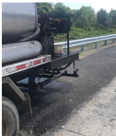
Gambar 3.52 Penyiraman Prime Coat (Sumber : Dokumentasi Kerja Praktek,2023)
