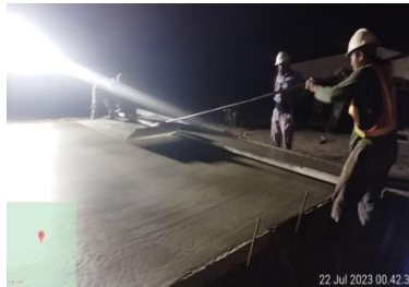
Gambar 3.48 Pekerjaan Growping (Sumber : Dokumentasi Kerja Praktek,2023)
