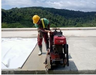
Gambar 3.50 Pekerjaan Cutting (Sumber : Dokumentasi Kerja Praktek,2023)
