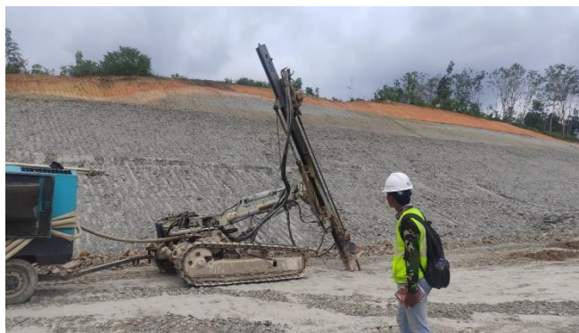
Gambar 3. 18 Meninjau Pekerjaan Persiapan Blasting Sumber: Dokumentasi Kerja Praktek, 2023
