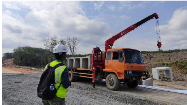
Gambar 3. 11 Meninjau Pekerjaan Mobilisasi Drainase Pracetak Sumber: Dokumentasi Kerja Praktek, 2023
