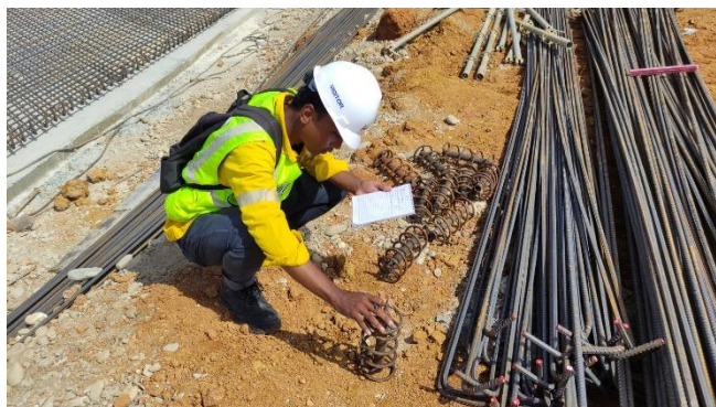
Gambar 3. 16 Meninjau Pekerjaan Pembesian Box Traffic Sumber: Dokumentasi Kerja Praktek, 2023
