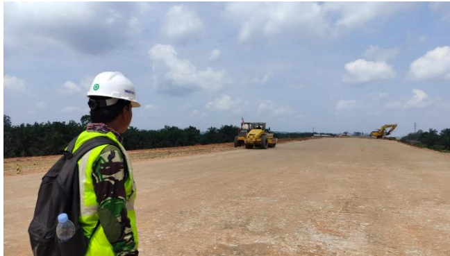
Gambar 3. 10 Meninjau Pekerjaan Pemasangan Tanah Sumber: Dokumentasi Kerja Praktek, 2023
