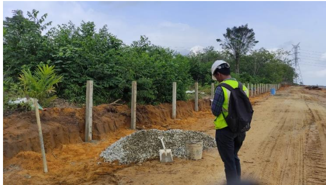
Gambar 3. 15 Meninjau Pekerjaan Pemasangan Pagar ROW Sumber: Dokumentasi Kerja Praktek, 2023
