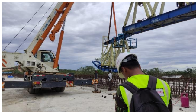
Gambar 3. 9 Meninjau Pembongkaran Bridge Girder Launcher Sumber: Dokumentasi Kerja Praktek, 2023
