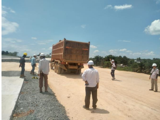
Gambar 3. 6 Pengujian Proof Rolling Sumber: Dokumentasi Kerja Praktek, 2023
