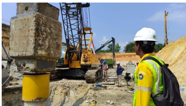
Gambar 3. 8 Pengujian PDA Sumber: Dokumentasi Kerja Praktek, 2023
