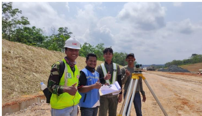
Gambar 3. 17 Meninjau Pekerjaan Survei Sumber: Dokumentasi Kerja Praktek, 2023
