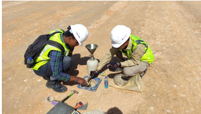
Gambar 3. 3 Pengujian Sand Cone Sumber: Dokumentasi Kerja Praktek, 2023
