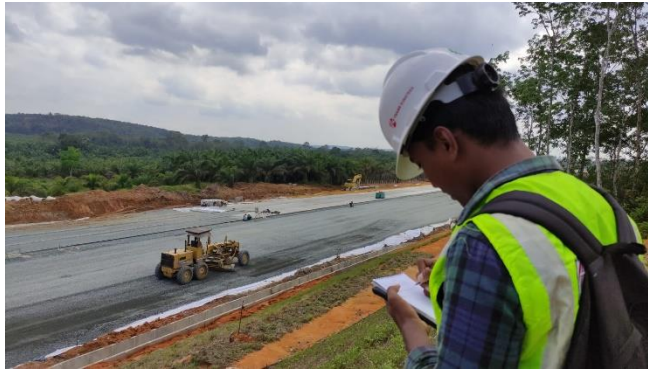
Gambar 3. 12 Meninjau Pekerjaan Perataan LD Sumber: Dokumentasi Kerja Praktek, 2023
