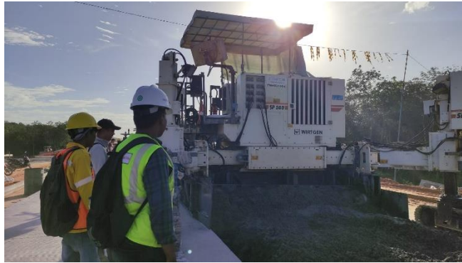
Gambar 3. 14 Meninjau Pengecoran Menggunakan Wirtgen Sumber: Dokumentasi Kerja Praktek, 2023
