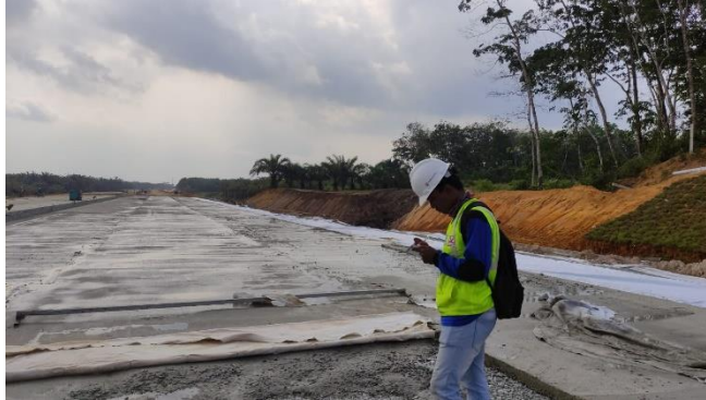
Gambar 3. 13 Meninjau Pekerjaan Perawatan LC Sumber: Dokumentasi Kerja Praktek, 2023
