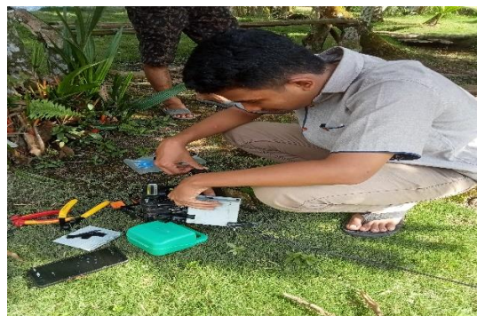
Gambar 3. 2 Proses penyambungan kabel fiber optic
