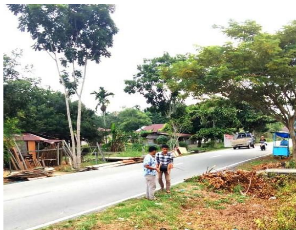
Gambar 3. 1 Penarikan kabel fiber optic
