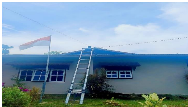
Gambar 3. 5 Instalasi Jaringan WIFI
