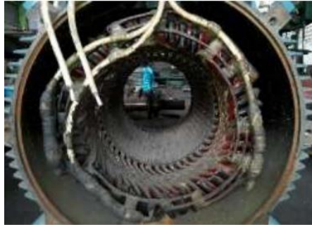
Gambar 3.10 Kondisi Stator sebelum overhaul (Sumber: Dokumentasi 2023)
