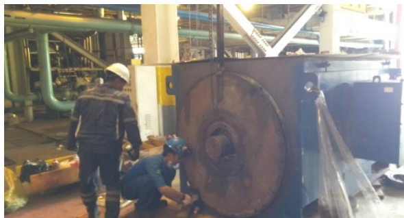
Gambar 2.30 Pemasangan Host Bearing (Sumber: Dokumentasi 2023)
