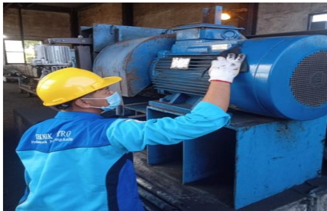
Gambar 2.26 Preventive Maintenance PLTU CONVEYOR C05 EL-14D. (Sumber: Dokumentasi 2023)
