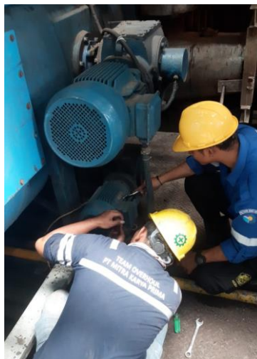
Gambar 2.18 perbaikan pada motor fan clearing (Sumber : Dokumentasi 2023)
