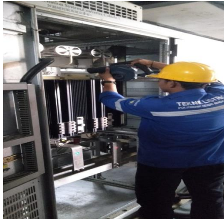
Gambar 2.39 Cleaning panel AVR (Sumber: Dokumentasi 2023)
