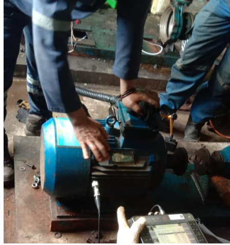
Gambar 2.24 pemasangan Motor Intermediate Pump (Sumber : Dokumentasi 2023)
