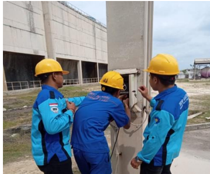
Gambar 2.2 Penambahan power 1 fasa (Sumber : Dokumentasi 2023)
