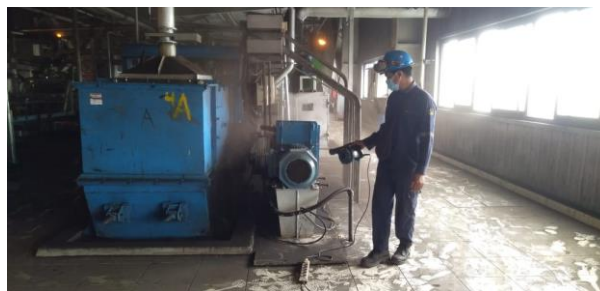
Gambar 2.42 Preventive Maintenance PLTU CONVEYOR C05 EL-14D . (Sumber: Dokumentasi 2023)
