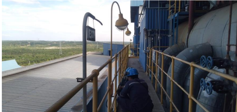
Gambar 2.31 Pemasangan Ballast Lampu Diarea Boiler (Sumber: Dokumentasi 2023)
