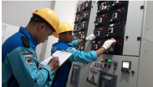
Gambar 2.13 Pembersihan panel motor BAC (Sumber : Dokumentasi 2023)
