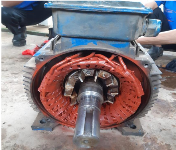
Gambar 3.14 Kondisi Stator setelah overhaul (Sumber: Dokumentasi 2023)
