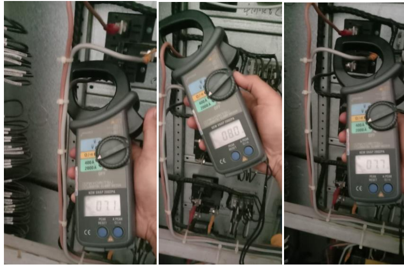
R S T Gambar 3.18 Pengukuran tegangan di breker (Sumber: Dokumentasi 2023)
