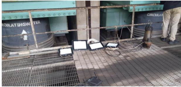
Gambar 2.34 Support power lampu (Sumber: Dokumentasi 2023)
