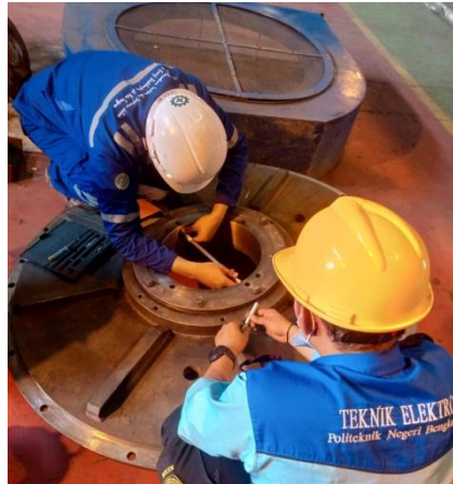
Gambar 2.19 Pengukuran house bearing (Sumber : Dokumentasi 2023)
