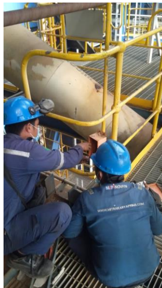
Gambar 2.45 Pemasangan lampu ballas
