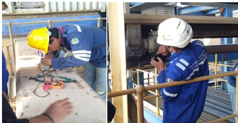
Gambar 2.40 Cleaning dan pengecekan pada motor shoot blowing (Sumber: Dokumentasi 2023)
