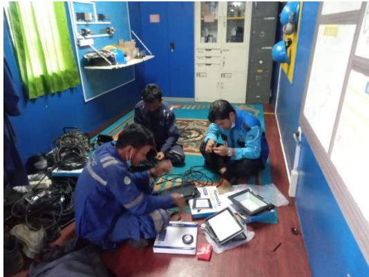
Gambar 2.21 Perangkaian Kable Lampu (Sumber : Dokumentasi 2023)
