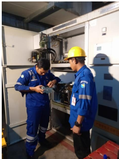
Gambar 2.22 Perbaikan Panel Bass 6000 V (Sumber : Dokumentasi 2023)
