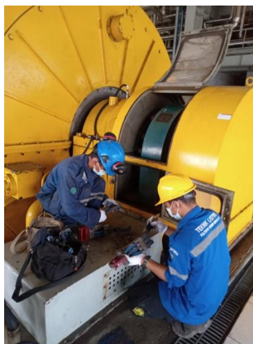
Gambar 2.20 penggantian carbon Brush Exither (Sumber : Dokumentasi 2023)
