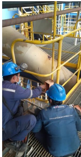
Gambar 2.32 Pemasangan Ballast Lampu Diarea Boiler (Sumber: Dokumentasi 2023)
