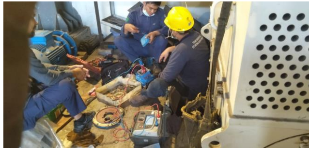
Gambar 2.46 motor induksi 3 fasa menggunakan alat ukur insulation tester (Sumber: Dokumentasi 2023)
