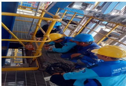
Gambar 2.14 Support power dan Penerangan lampu (Sumber : Dokumentasi 2023)
