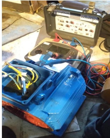
Gambar 3.16 Pengukuran Hasil PI menggunakan Megger ( Sumber : Dokumentasi 2023 )
