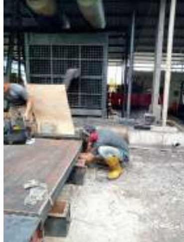
Gambar 2.8 Kegiatan pemindahan radiator unit 7 ke unit 6 (Sumber: PT. Megapower Makmur Tbk, 2023)
