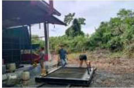
Gambar 2.36 Kegiatan penggantian radiator unit 8 (Sumber: PT. Megapower Makmur Tbk, 2023)
