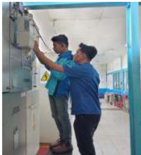
Gambar 2.16 Kegiatan monitoring KWH setiap jamnya (Sumber: PT. Megapower Makmur Tbk, 2023)
