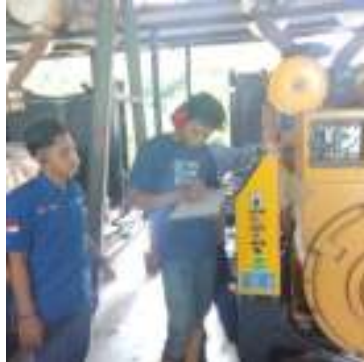
Gambar 2.28 Kegiatan monitoring KWH setiap jamnya (Sumber: PT. Megapower Makmur Tbk, 2023)
