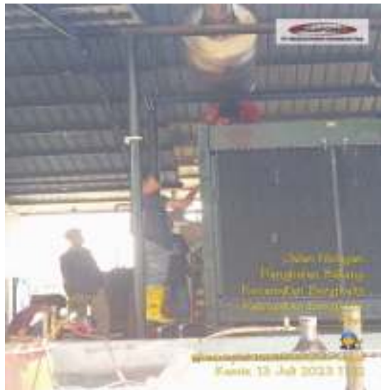
Gambar 2.32 Kegiatan Pemindahan Radiator (Sumber: PT. Megapower Makmur Tbk, 2023)
