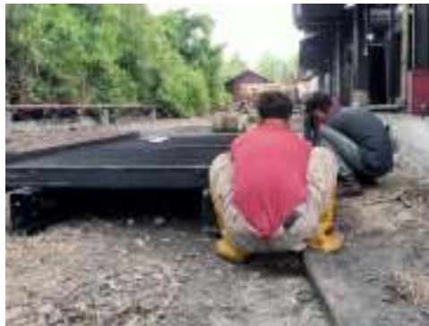
Gambar 2.43 Kegiatan penggantian radiator (Sumber: PT. Megapower Makmur Tbk, 2023)
