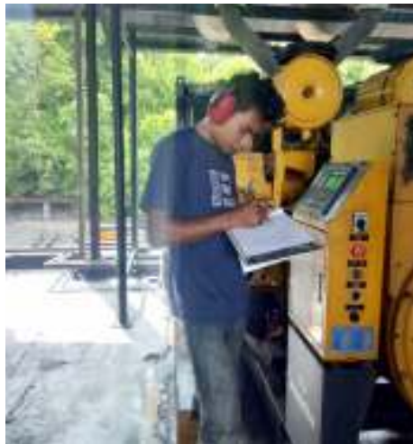
Gambar 2.5 Kegiatan monitoring KWH setiap jamnya (Sumber: PT. Megapower Makmur Tbk, 2023)
