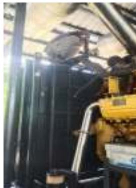
Gambar 2.27 Kegiatan penggantian radiator unit 3 (Sumber: PT. Megapower Makmur Tbk, 2023)
