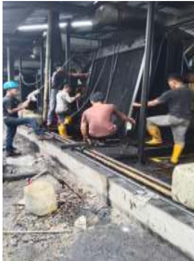
Gambar 2.6 Kegiatan penggantian radiator unit 7 (Sumber: PT. Megapower Makmur Tbk, 2023)
