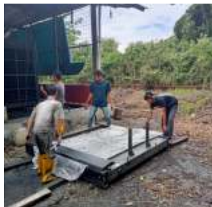
Gambar 2.37 Kegiatan pembersihan radiator (Sumber: PT. Megapower Makmur Tbk, 2023)
