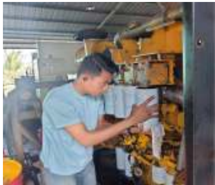
Gambar 2.7 Kegiatan penggantian oli mesin (Sumber: PT. Megapower Makmur Tbk, 2023)
