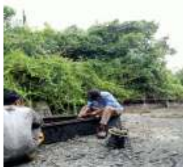
Gambar 2.44 Kegiatan pembersihan radiator (Sumber: PT. Megapower Makmur Tbk, 2023)
