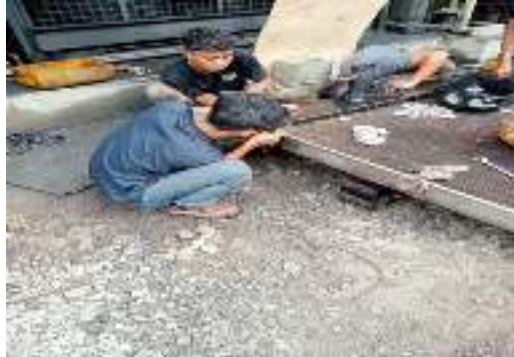
Gambar 2.32 Kegiatan monitoring KWH setiap jamnya (Sumber: PT. Megapower Makmur Tbk, 2023)
