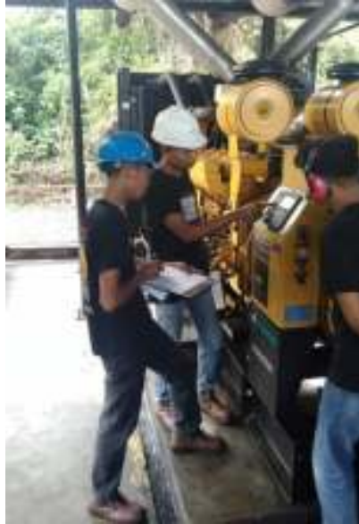
Gambar 2.38 Kegiatan monitoring KWH setiap jamnya (Sumber: PT. Megapower Makmur Tbk, 2023)
