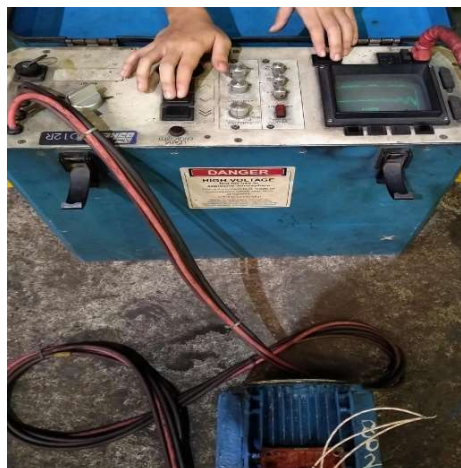
Gambar 2.31 Surge test (Sumber : Dokumentasi )
