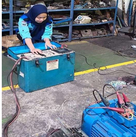
Gambar 2.30 Surge Test (Sumber : Dokumentasi )
