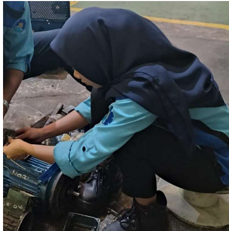
Gambar 2.9 Pemasangan Skun Pada Kabel Motor (Sumber : Dokumentasi )
