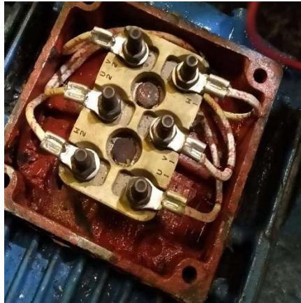
Gambar 2.14 Pemasangan Skund Kabel Motor (Sumber : Dokumentasi )
