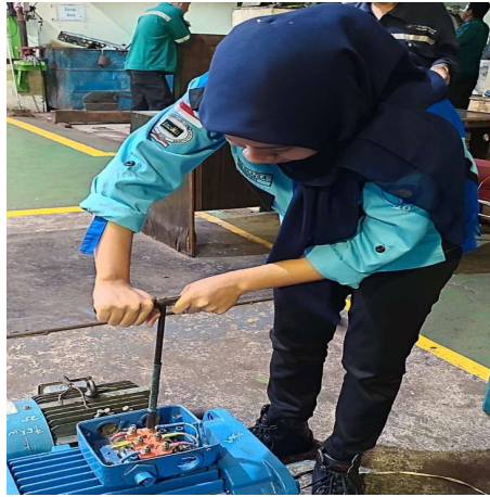
Gambar 2.7 Terminating Motor (Sumber : Dokumentasi )
