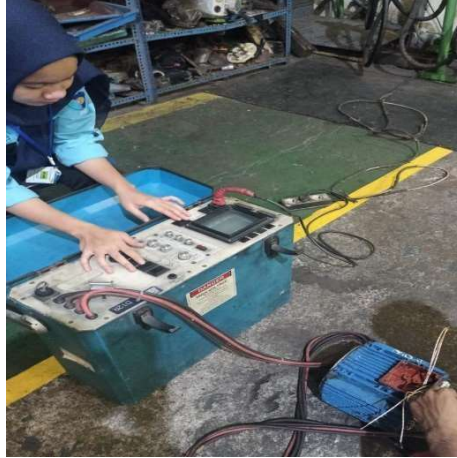
Gambar 4.29 Surge Test (Sumber : Dokumentasi )
