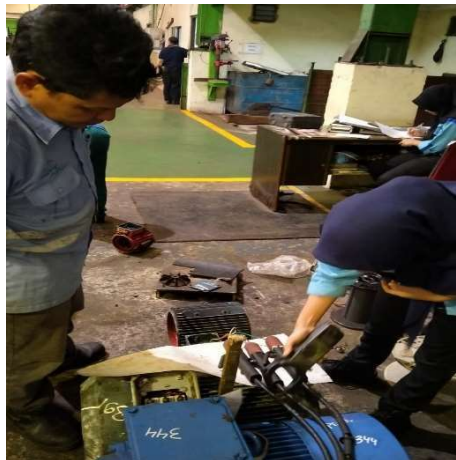
Gambar 2.4 Uji Coba Motor 3 Fasa (Sumber : Dokumentasi )
