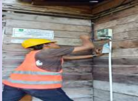
Gambar 2.21 Penggantian mcb yang sudah rusak ( Sumber :PLN. Rayon bengkalis PT. Adra gemilang.2020)
