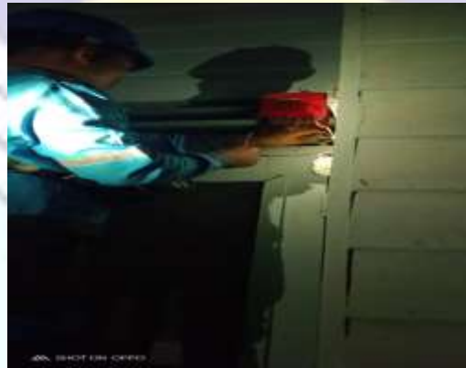
Gambar 2.20 pemasangan KWH meter dumi sementara
