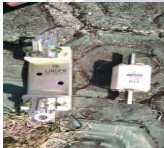
Gambar 2.26 Penggantian NH fuse dan ground plat
