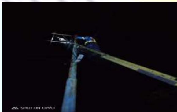
Gambar 2.5 gangguan lost kontak ( Sumber :PLN. Rayon bengkalis PT. Adra gemilang.2020)
