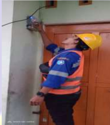
Gambar 2.27 Kwh meter periksa ( Sumber :PLN. Rayon bengkalis PT. Adra gemilang,2020)
