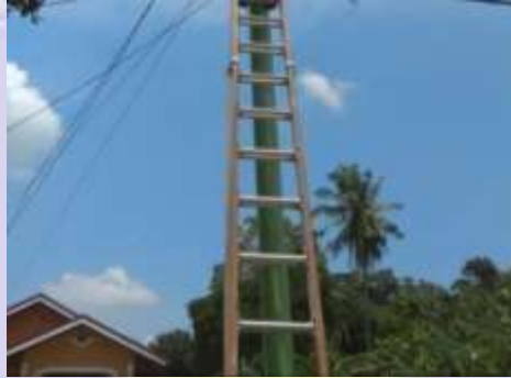
Gambar 2.40 Tangga (Sumber: PT. Adra Gemilang)
