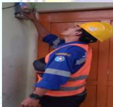
Gambar 2.32 Kwh meter periksa
