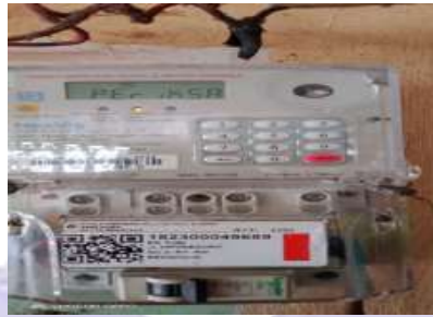
Gambar 2.6 Kwh Tertera Periksa dirumah Pelanggan ( Sumber :PLN. Rayon bengkalis PT. Adra gemilang.2020)
