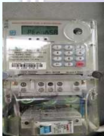
Gambar 2.19 kwh meter periksa ( Sumber :PLN. Rayon bengkalis PT. Adra gemilang.2020)
