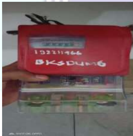
Gambar 2.13 Penggantian kwh dumi di rumah pelanggan
