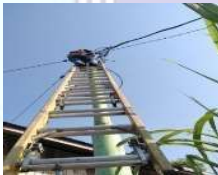
Gambar 2.28 Los kotak ( Sumber :PLN. Rayon bengkalis PT. Adra gemilang,2020)
