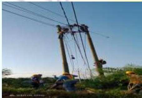
Gambar 2.36 Mengeksekusi tiang yang tumbang ( Sumber :PLN. Rayon bengkalis PT. Adra gemilang.2020)
