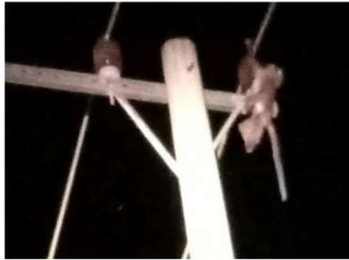
Gambar 3.3 gangguan JTM dari binatang liar
