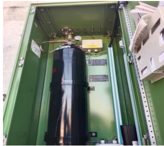
Gambar 2.14 Pengecekan Sergi TP Pada Gardu Induk WINA 150 kv (sumber:dokumentasi penulis,2023)
