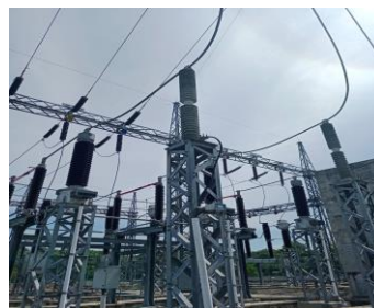
Gambar 2.5 Lightning Arrester (sumber:dokumentasi penulis,2023)
