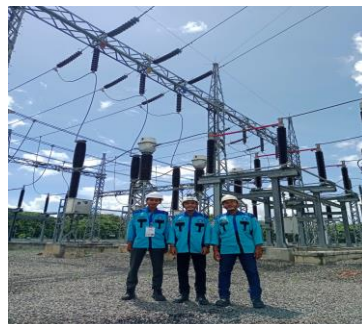
Gambar 2.3 Pengenalan Apparatus 150 KV WINA (sumber:dokumentasi penulis,2023)
