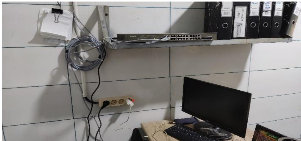
Gambar 3. 3 Pemasangan Switch Dan Merapikan Kabel UTP Sumber : Dokumen Pribadi
