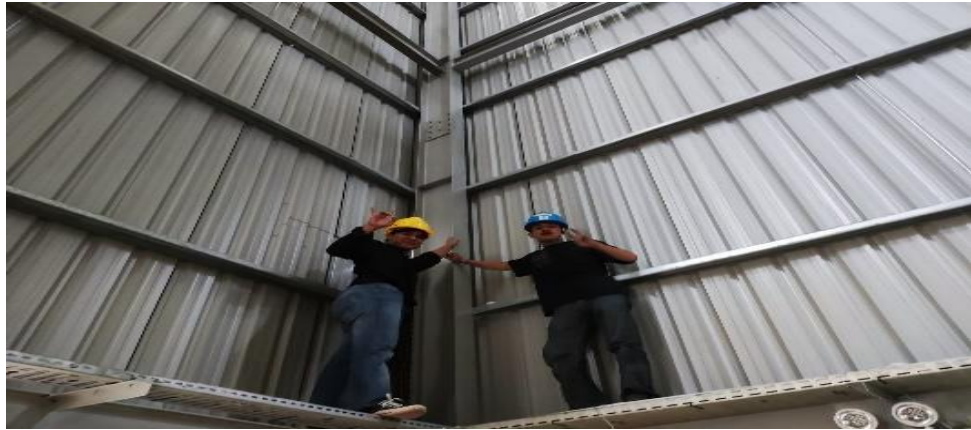
Gambar 3. 2 Installasi Kabel UTP Sumber : Dokumen Pribadi
