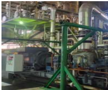
Gambar 2. 8 Stasiun Kamar Mesin Sumber : Dokumentasi 2023
