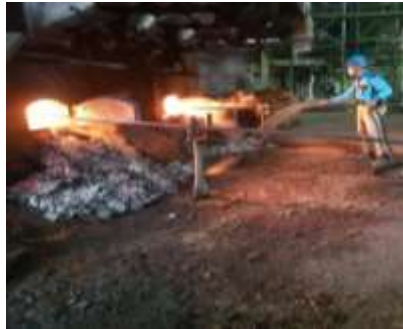
Gambar 2. 30 Membantu mengorek abu bakar Boiler Sumber : Dokumentasi 2023
