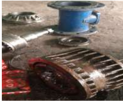
Gambar 2. 41 Pembongkaran elektromotor Sumber : Dokumentasi 2023
