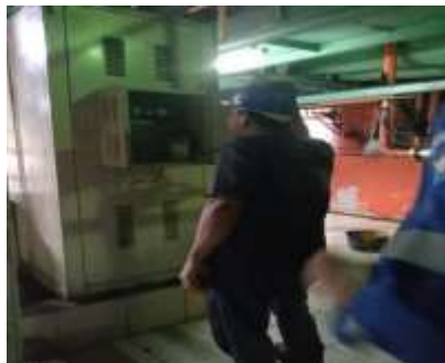
Gambar 2. 37 Membantu penggantian MCCB Sumber : Dokumentasi 2023
