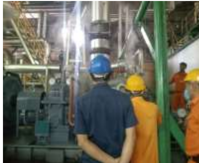
Gambar 2. 38 Proses pengoperasian awal turbin Multistage steam Sumber : Dokumentasi 2023
