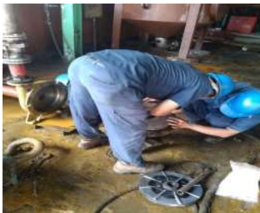
Gambar 2. 34 Membantu Perbaikan Pompa Transfer Sumber : Dokumentasi 2023
