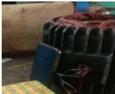
Gambar 2. 46 Membantu Maintenance perbaikan Elektromotor Sumber : Dokumentasi 2023
