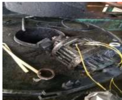
Gambar 2. 18 Menyambung Kabel Elektromotor di sweco vibrating screen Sumber : Dokumentasi 2023
