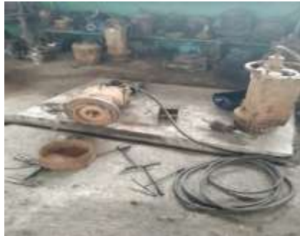
Gambar 2. 13 Pembongkaran Pompa Transfer Sumber : Dokumentasi 2023
