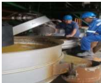
Gambar 2. 11 Pemasangan plat di mesin vibrating screen Sumber : Dokumentasi 2023
