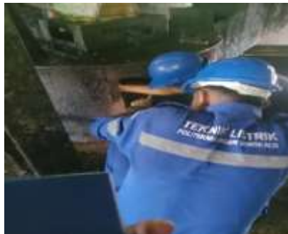
Gambar 2. 15 Penggantian elektromotor digester Sumber : Dokumentasi 2023
