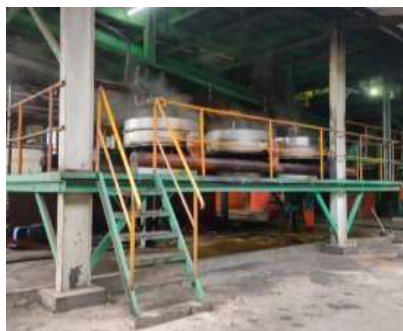
Gambar 2. 6 Stasiun Klarifikasi Sumber : Dokumentasi 2023
