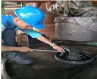
Gambar 2. 16 Pembongkaran saringan atau filter Vibrating screen Sumber : Dokumentasi 2023
