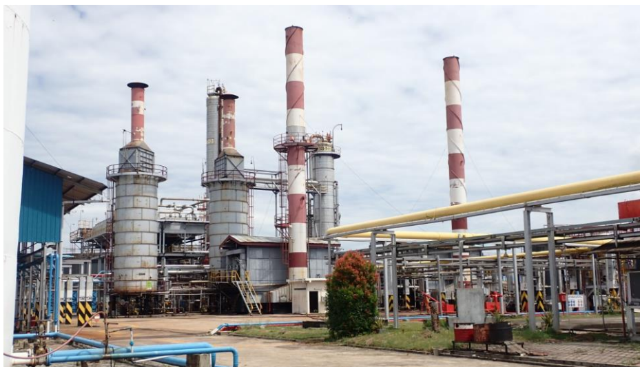
Gambar 2.1 Kilang Minyak PT.Pertamina RU-II Sungai Pakning
