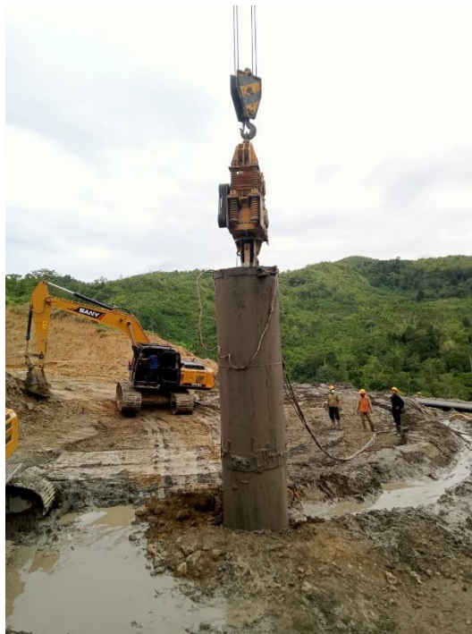
Gambar 4. 31 Pengangkatan Casing Sumber : Dokumentasi Kerja Praktek, 2023
