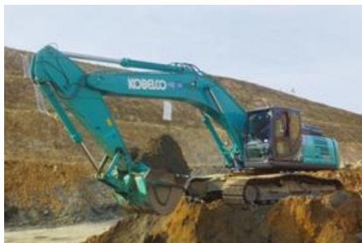
Gambar 3. 4 Excavator SK330 Sumber : Dokumentasi Kerja Praktek, 2023
