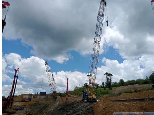
Gambar 3. 11 Crane Sumber : Dokumentasi Kerja Praktek, 2023
