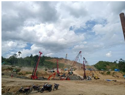
Gambar 4. 19 Penempatan Alat Bor Sumber : Dokumentasi Kerja Praktek, 2023
