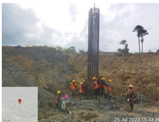
Gambar 4. 27 Pemasangan Tulangan di Lobang Bore Pile Sumber : Dokumentasi Kerja Praktek, 2023
