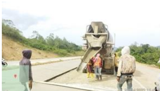
Gambar 3. 39 Mobilisasi Beton Sumber : Dokumentasi Kerja Praktek, 2023
