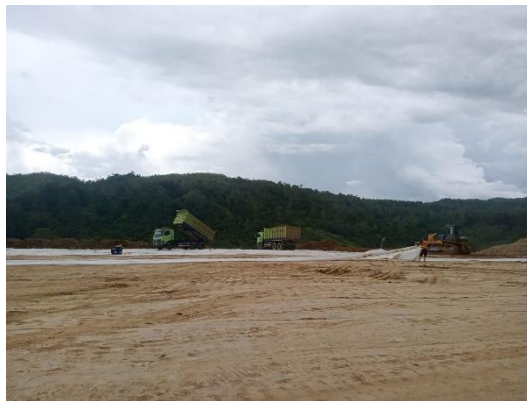
Gambar 3. 28 Pemasangan Geotek Sumber : Dokumentasi Kerja Praktek, 2023
