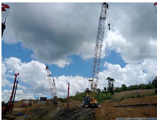
Gambar 4. 4 Crawler Crane Sumber: Dokumentasi Kerja Praktek, 2023
