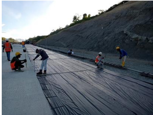
Gambar 3. 44 Pemasangan String Line Sumber : Dokumentasi Kerja Praktek, 2023
