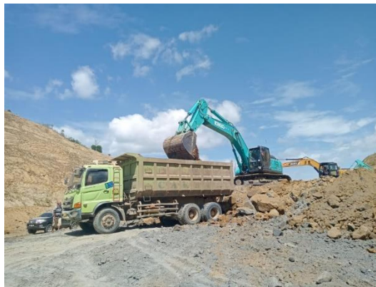
Gambar 3. 16 Loading Pengangkutan Tanah Sumber : Dokumentasi Kerja Praktek, 2023
