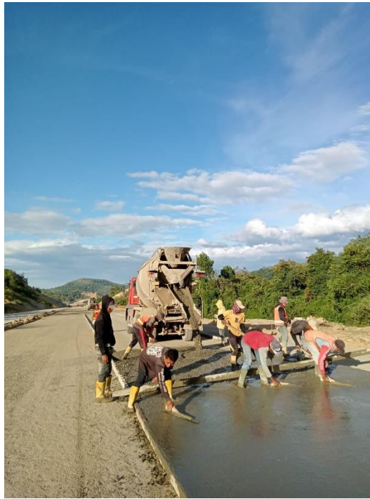
Gambar 3. 40 Proses Penghamparan Beton LC Sumber : Dokumentasi Kerja Praktek, 2023
