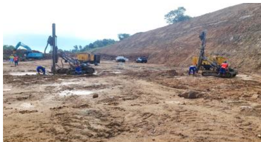
Gambar 3. 20 Pengeboran Titik Blasting Sumber : Dokumentasi Kerja Praktek, 2023
