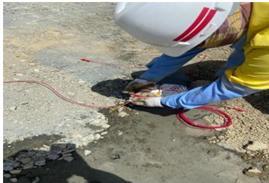
Gambar 3. 22 Perakitan Kabel Detonator Sumber : Dokumentasi Kerja Praktek, 2023
