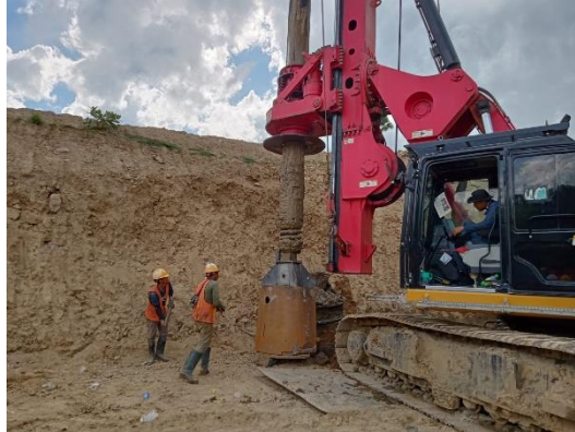
Gambar 4. 20 Pemasangan Mata Bor Sumber : Dokumentasi Kerja Praktek, 2023
