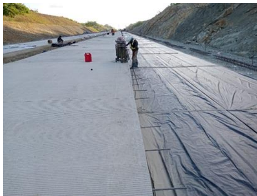
Gambar 3. 43 Pemasangan Plastik Beton Sumber : Dokumentasi Kerja Praktek, 2023
