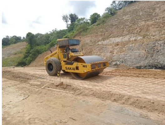
Gambar 3. 27 Pemasangan Dengan Vibrator Roller Sumber : Dokumentasi Kerja Praktek, 2023
