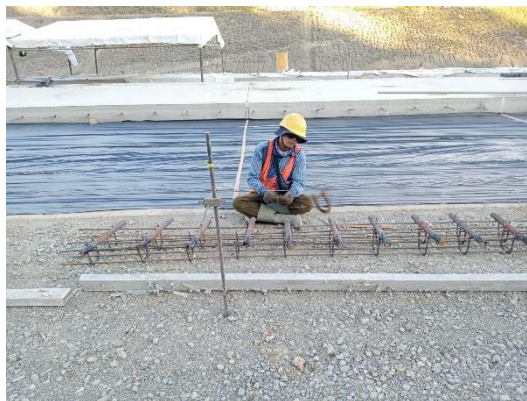
Gambar 3. 45 Persiapan Dowel Sumber : Dokumentasi Kerja Praktek, 2023
