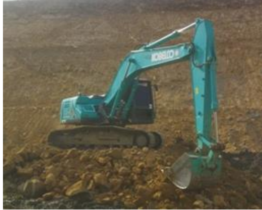
Gambar 3. 2 Excavator SK200 Sumber : Dokumentasi Kerja Praktek, 2023
