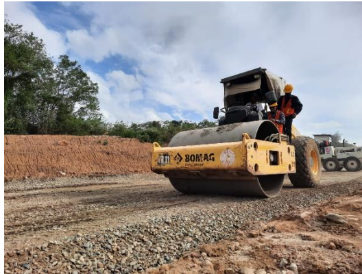
Gambar 3. 34 Pemasangan Dengan Compactor Sumber : Dokumentasi Kerja Praktek, 2023
