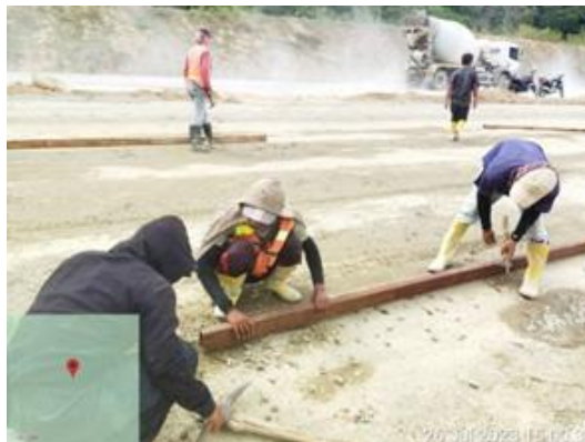
Gambar 3. 38 Pemasangan Bekisting Sumber : Dokumentasi Kerja Praktek, 2023
