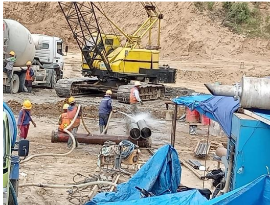
Gambar 4. 30 Pembersihan Pipa Tremie Sumber : Dokumentasi Kerja Praktek, 2023
