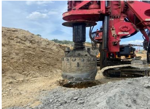
Gambar 4. 24 Pembuangan Material Galian Sumber : Dokumentasi Kerja Praktek, 2023
