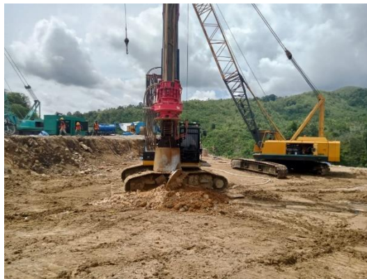
Gambar 4. 21 Pengeboran Titik Bore Pile Sumber : Dokumentasi Kerja Praktek, 2023
