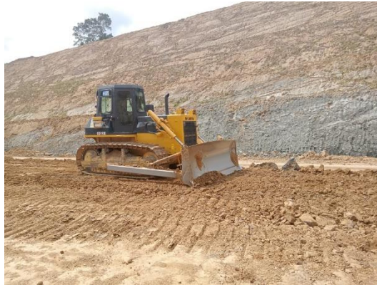
Gambar 3. 25 Penghamparan Material Timbunan Sumber : Dokumentasi Kerja Praktek, 2023
