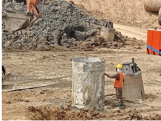
Gambar 4. 22 Pemasangan Casing Sumber : Dokumentasi Kerja Praktek, 2023
