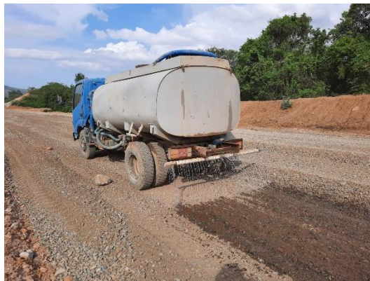
Gambar 3. 33 Penyiraman Material Base A Sumber : Dokumentasi Kerja Praktek, 2023
