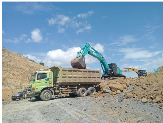
Gambar 3. 18 Loading Pengangkutan Tanah Sumber : Dokumentasi Kerja Praktek, 2023
