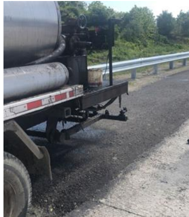
Gambar 3. 52 Pelaksanaan Pelapisan Prime Coat Sumber : Dokumentasi Kerja Praktek, 2023
