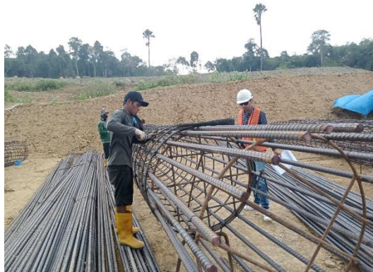
Gambar 4. 26 Perakitan Tulangan Sumber : Dokumentasi Kerja Praktek, 2023
