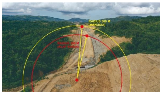
Gambar 3. 23 Jarak Lokasi Blasting Sumber : Dokumentasi Kerja Praktek, 2023
