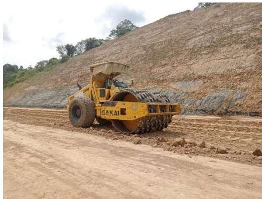
Gambar 3. 26 Pemadatan Dengan Sheep Foot Roller Sumber : Dokumentasi Kerja Praktek, 2023
