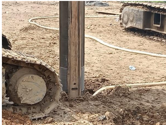
Gambar 4. 23 Pengisian Air Pada Lubang Bor Sumber : Dokumentasi Kerja Praktek, 2023
