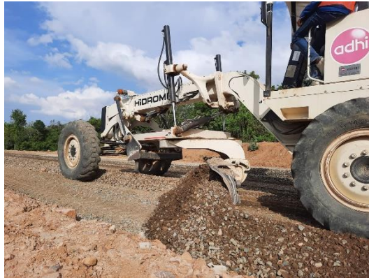
Gambar 3. 32 Penghamparan Material Base Sumber: Dokumentasi Kerja Praktek, 2023
