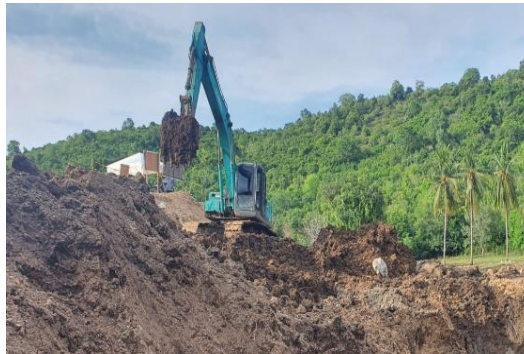
Gambar 4. 16 Pekerjaan Persiapan Sumber : Dokumentasi Kerja Praktek, 2023
