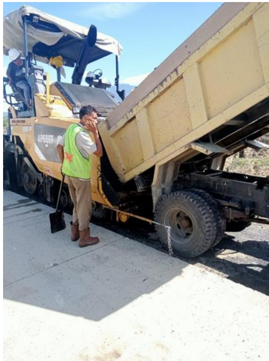
Gambar 3. 53 Penuangan Aspal ke Alat Asphalt Finisher Sumber : Dokumentasi Kerja Praktek, 2023
