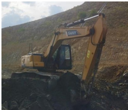
Gambar 3. 3 Excavator SK215c Sumber : Dokumentasi Kerja Praktek, 2023
