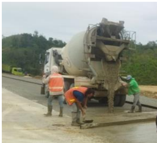
Gambar 3. 10 Truck Mixer Sumber : Dokumentasi Kerja Praktek, 2023
