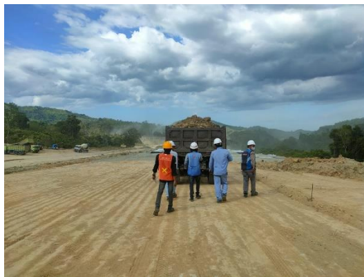
Gambar 3. 30 Pengujian Proff Rolling Sumber : Dokumentasi Kerja Praktek, 2023
