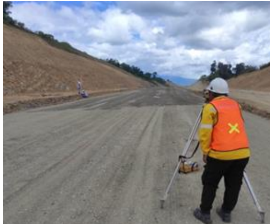
Gambar 3. 37 Penentuan Titik Pekerjaan Sumber : Dokumentasi Kerja Praktek, 2023
