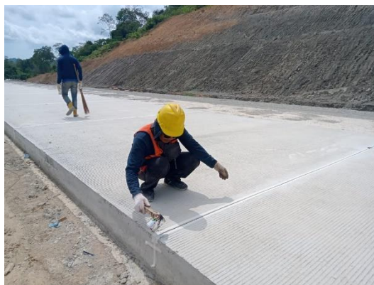
Gambar 3. 51 Pengisian Bahan Joint Sealant Sumber : Dokumentasi Kerja Praktek, 2023
