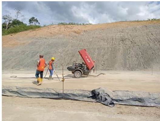
Gambar 3. 42 Pembersihan Lokasi Rigid Pavement Sumber : Dokumentasi Kerja Praktek, 2023
