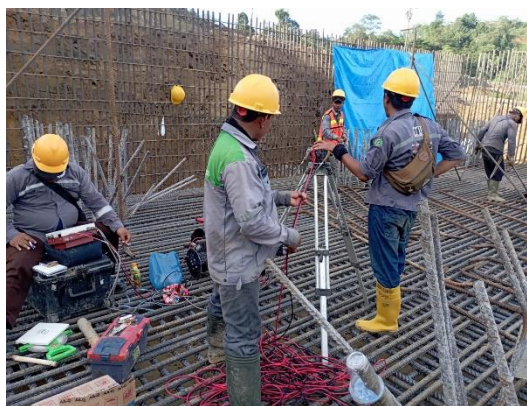
Gambar 4. 33 Setting Alat CSL Sumber : Dokumentasi Kerja Praktek, 2023
