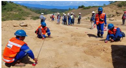
Gambar 3. 19 Penentuan Titik Blasting Sumber : Dokumentasi Kerja Praktek, 2023
