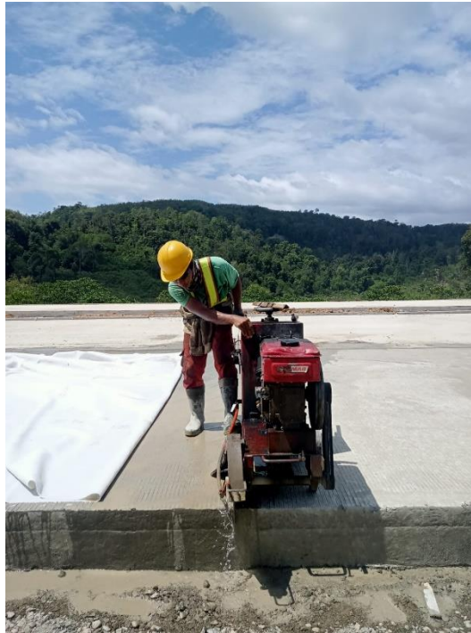
Gambar 3. 50 Pelaksanaan Cuting Sumber : Dokumentasi Kerja Praktek, 2023
