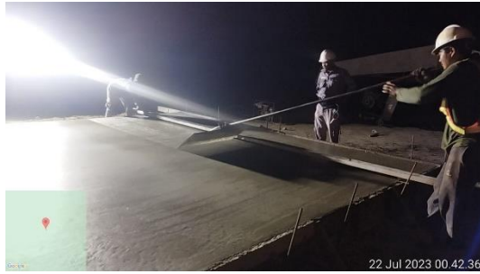
Gambar 3. 48 Pelaksanaan Grooving Sumber : Dokumentasi Kerja Praktek, 2023
