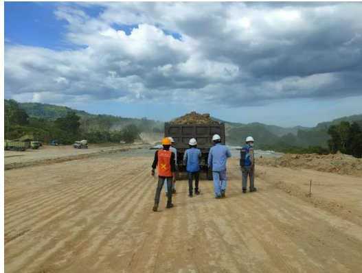
Gambar 3. 36 Pengujian Proof Rolling Sumber : Dokumentasi Kerja Praktek, 2023
