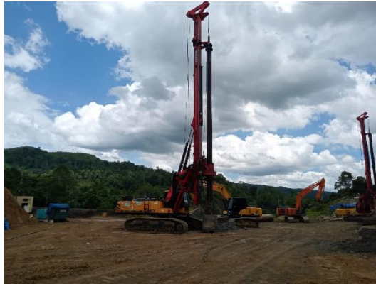
Gambar 3. 13 Driling Rig Sumber : Dokumentasi Kerja Praktek, 2023
