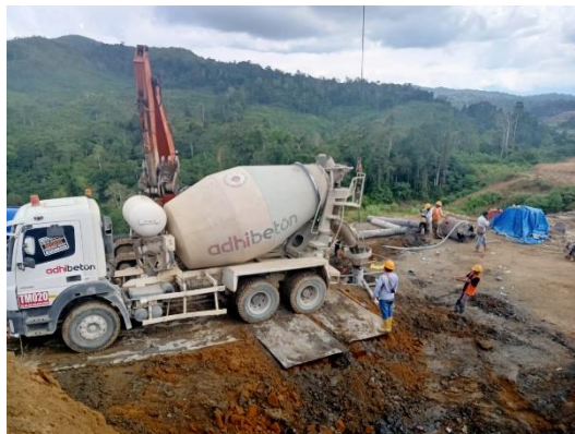
Gambar 4. 29 Proses Pengecoran Sumber : Dokumentasi Kerja Praktek, 2023
