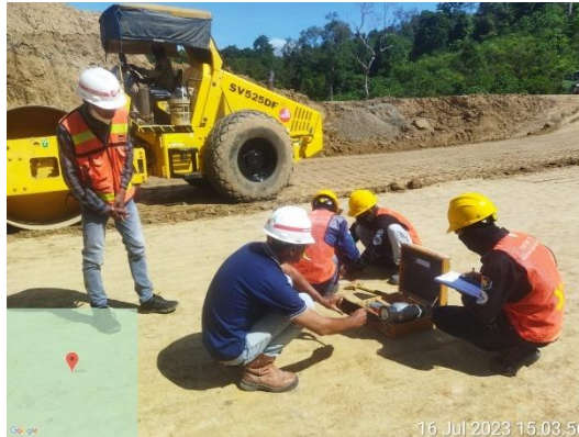
Gambar 3. 29 Sand Cone Test Sumber : Dokumentasi Kerja Praktek, 2023
