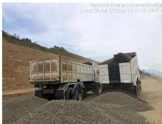
Gambar 3. 31 Mobilisasi Material Base A Sumber : Dokumentasi Kerja Praktek, 2023
