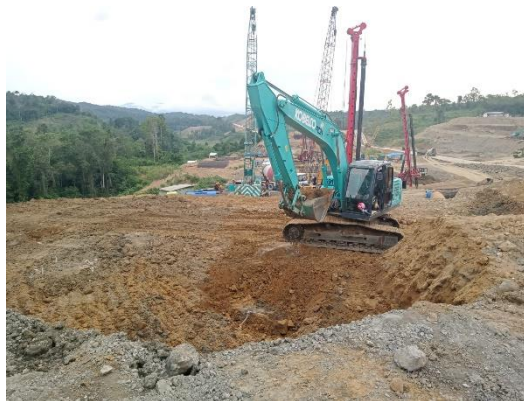
Gambar 4. 17 Proses Galian Platform Sumber : Dokumentasi Kerja Praktek, 2023
