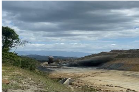
Gambar 3. 24 Proses Ledakan Sumber : Dokumentasi Kerja Praktek, 2023
