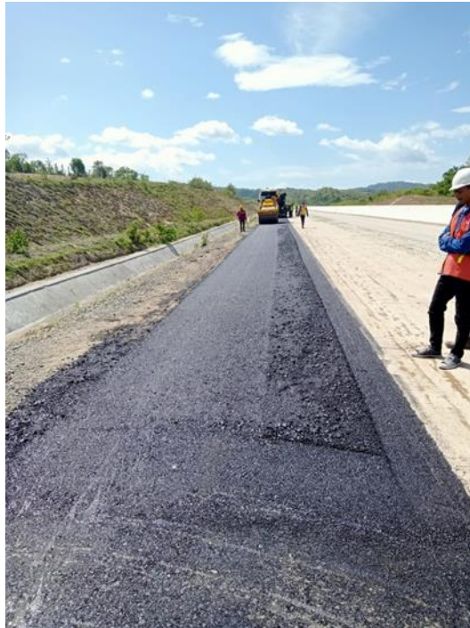
Gambar 3. 54 Pemadatan Awal Sumber : Dokumentasi Kerja Praktek, 2023
