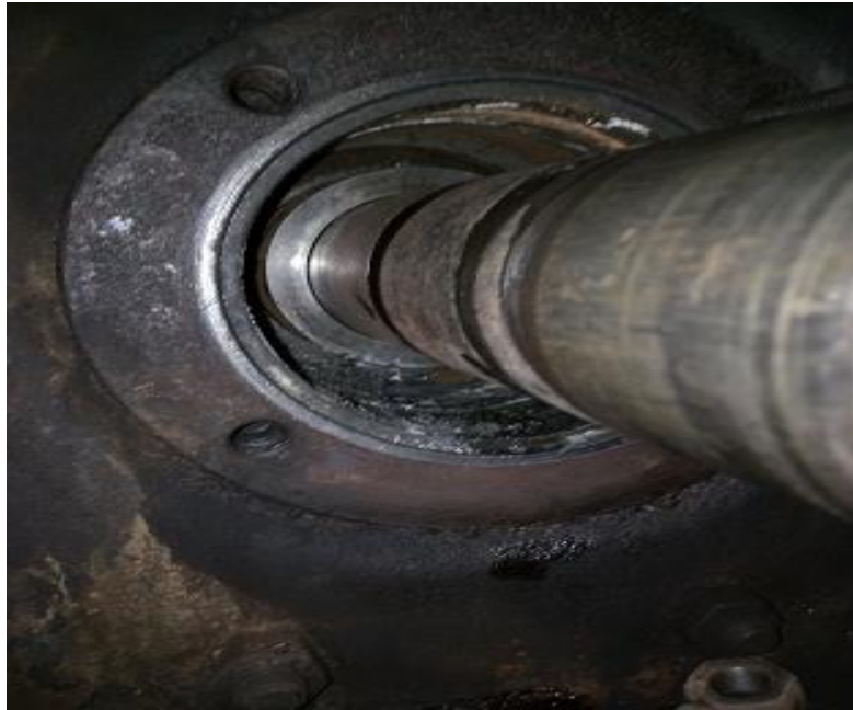
Gambar 4.10 Debris yang Terperangkap (Sumber: Dokumentasi Pribadi)
