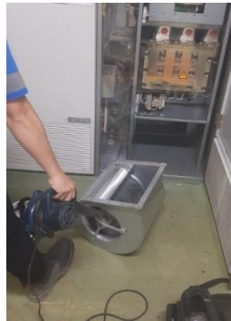
Gambar 3.8 Kegiatan Cleaning Sebagai Preventive Maintenance (Sumber: Dokumentasi PT. Riau Andalan Pulp and Paper Pangkalan Kerinci, 2023)
