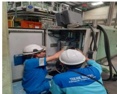
Gambar 2.21 mengganti Power Supply
