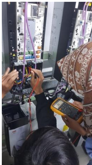
Gambar 2.7 Pengecekan komponen disaat shutdown
