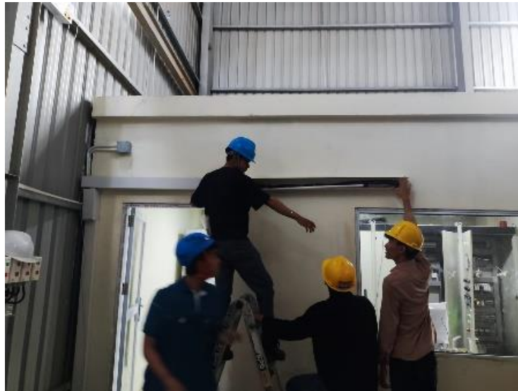
1 Gambar 3.2 Penarikan Kabel
