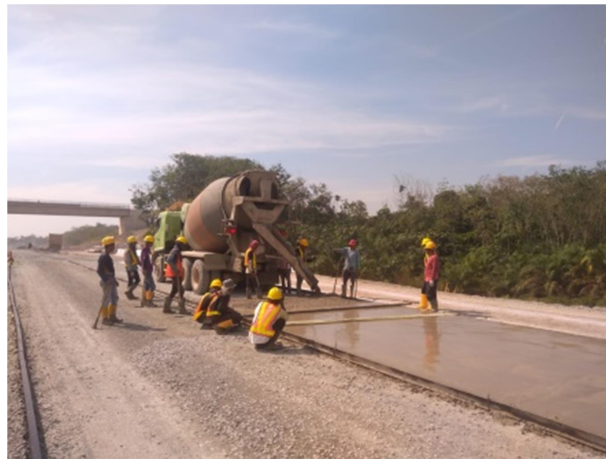
Gambar 3. 30 Pekerjaan pengecoran LC (Sumber : Dokumentasi Lapangan 2023)
