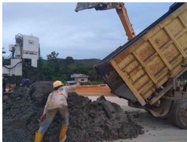
Gambar 3. 55 Penghamparan Beton (Sumber : Dokumentasi Lapangan 2023)
