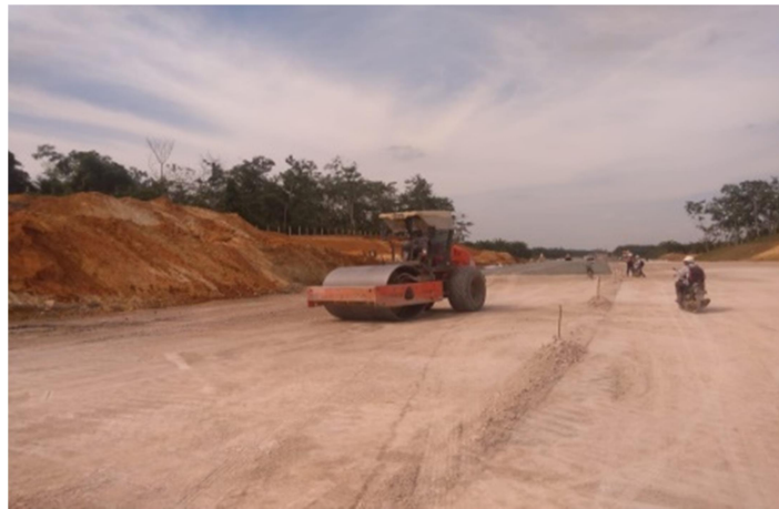
Gambar 3. 17 Pekerjaam Pemadatan (Capping Layer) (Sumber : Dokumentasi Lapangan 2023)
