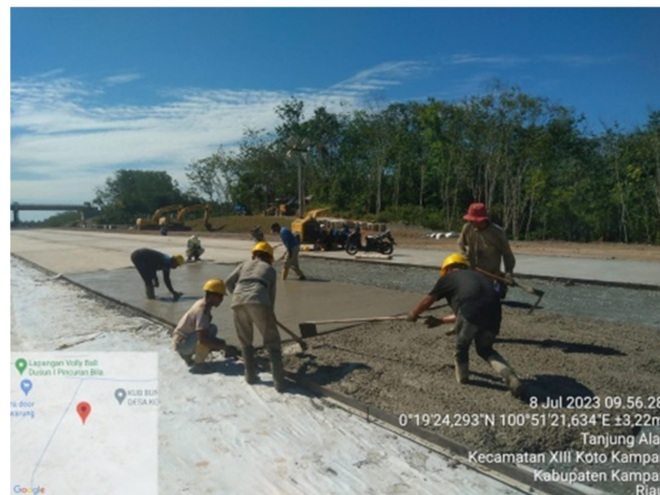
Gambar 3. 25 Pekerjaan Pengecoran LC di STA 60 + 600
