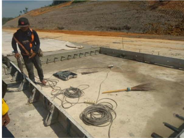
Gambar 3. 31 Pekerjaan pemasangan bekisting rigid
