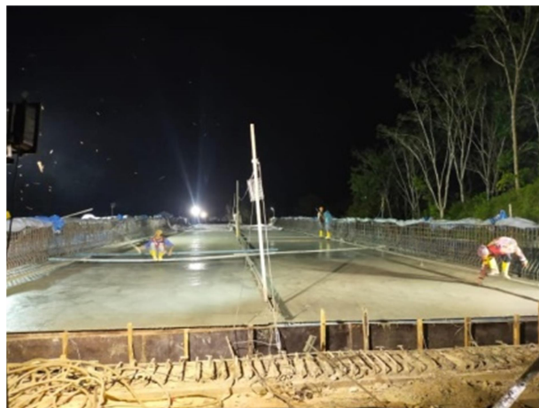
Gambar 4. 18 Pekerjaan Penghalusan Permukaan Beton
