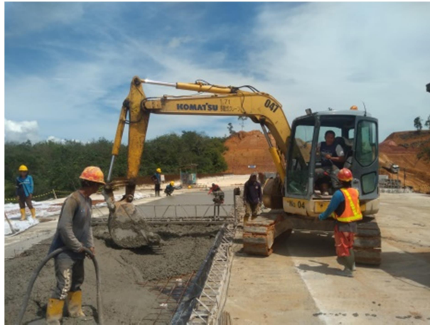
Gambar 3. 40 Pekerjaan penunggan beton dibantu dengan alat excavator (Sumber : Dokumentasi Lapangan 2023)
