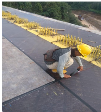
Gambar 3. 5 Pemasangan Labban Dan Sterofom
