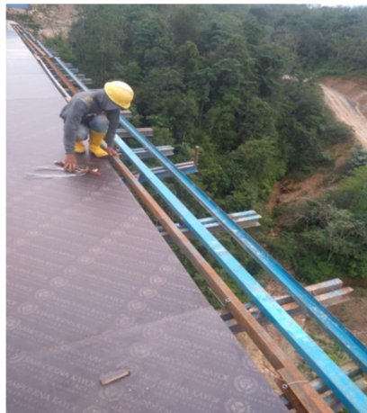
Gambar 4. 8 Pemasangan Ump (Sumber : Dokumentasi Kerja Praktek 2023)
