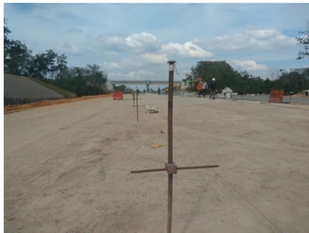
Gambar 3. 49 Pekerjaan Pemasangan Stringline (Sumber : Dokumentasi Lapangan 2023)
