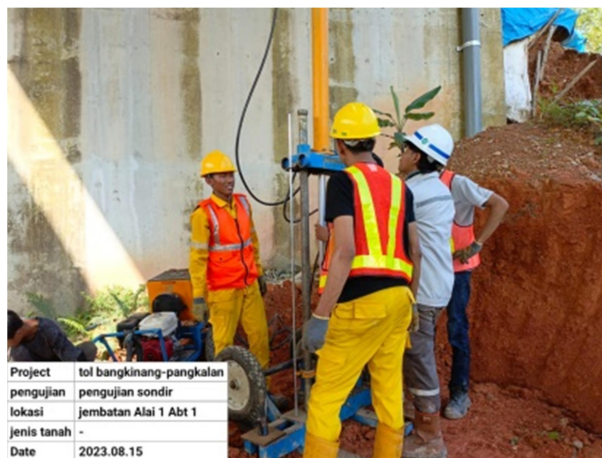
Gambar 3. 68 Pengujian Sondir (Sumber : Dokumentasi Lapangan 2023)
