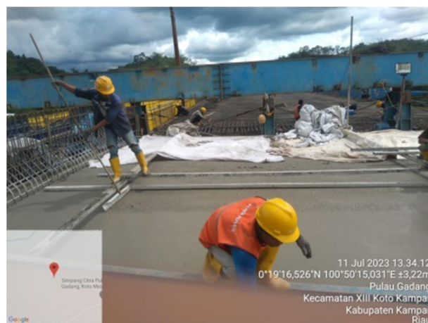
Gambar 4. 19 Pembuatan Alur Grouving
