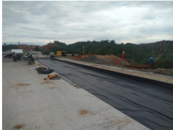
Gambar 3. 29 Pekerjaan pemasangan plastik cor (Sumber : Dokumentasi Lapangan 2023)
