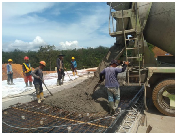
Gambar 3. 39 Pekerjaan penuangan beton
