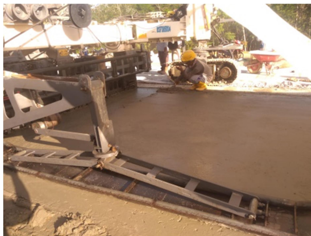
Gambar 3. 60 Proses pemasangan Tie Bar (Sumber : Dokumentasi Lapangan 2023)
