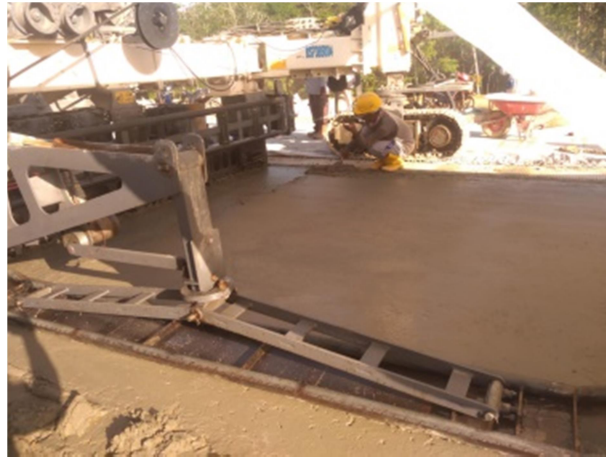
Gambar 3. 58 Hasil proses pemadatan (Sumber : Dokumentasi Lapangan 2023)
