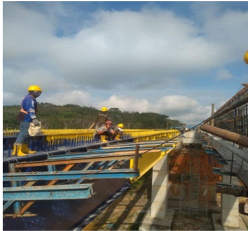
Gambar 3. 2 Pemasangan Kantilever Sayap
