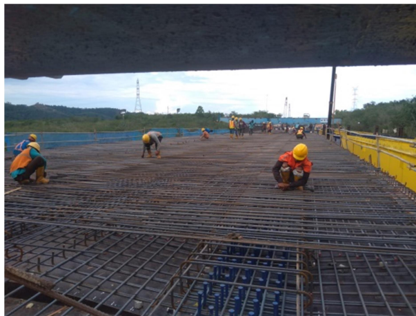
Gambar 4. 11 Pekerjaan pembesian slab
