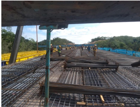
Gambar 3. 6 Pekerjaan Pembesiaan
