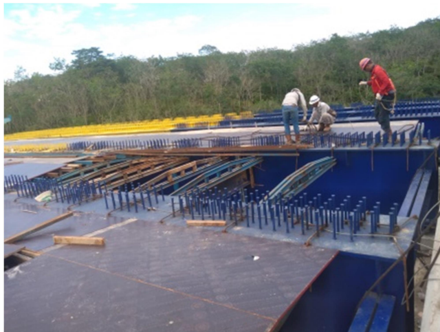
Gambar 3. 3 Pemasangan Tras Bar dan Ump (penahan phicnolip)
