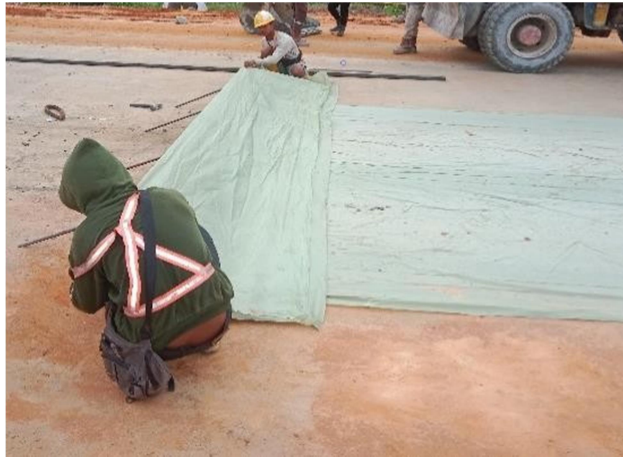
Gambar 3. 50 Pekerjaan Plastik Cor (Sumber : Dokumentasi Lapangan 2023)
