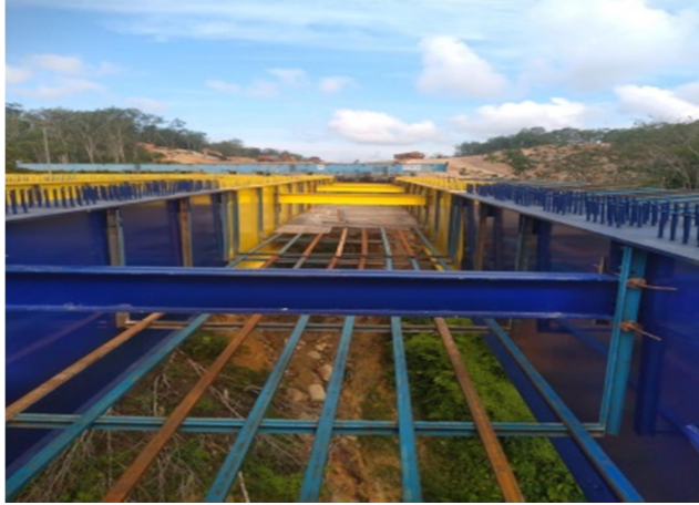
Gambar 4. 5 Pemasangan trasbar struktur bawah (gantungan lantai kerja) (Sumber : Dokumentasi Kerja Praktek 2023)
