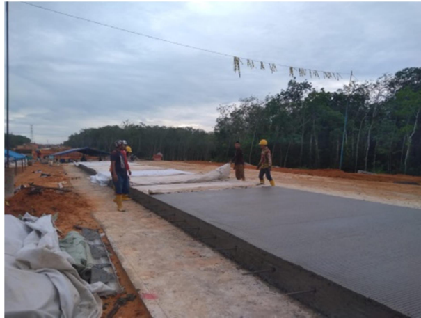
Gambar 3. 45 Penutupan beton menggunakan geotekstil
