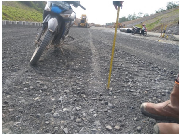
Gambar 3. 23 Pekerjaan Pengukuran Elevasi Top Lc (Cut & Fill LD) (Sumber : Dokumentasi Lapangan 2023)
