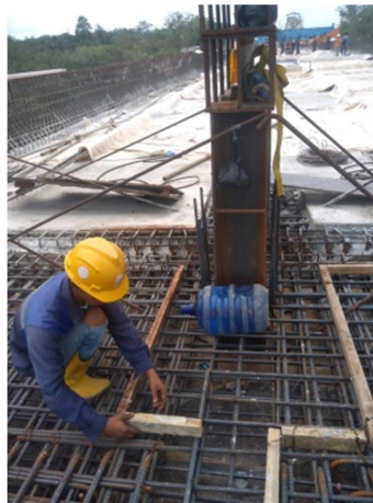
Gambar 4. 13 Pemasangan stop cor (Sumber : Dokumentasi Kerja Praktek 2023)
