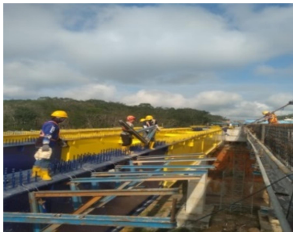
Gambar 4. 6 Pemasangan Kantilever sayap (Sumber : Dokumentasi Kerja Praktek 2023)
