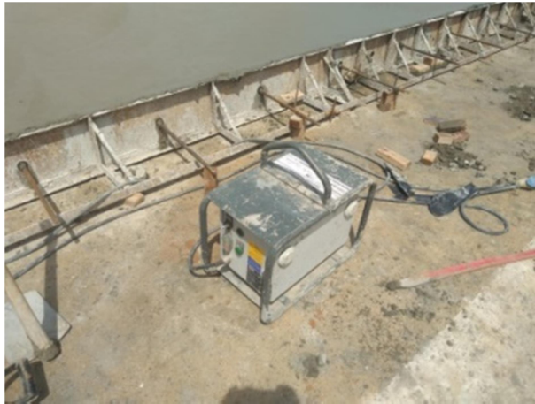
Gambar 3. 34 Vibrator Councrete (Sumber : Dokumentasi Lapangan 2023)
