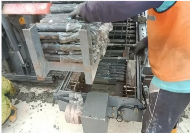
Gambar 3. 59 Proses Pemasangan Dowel (Sumber : Dokumentasi Lapangan 2023)
