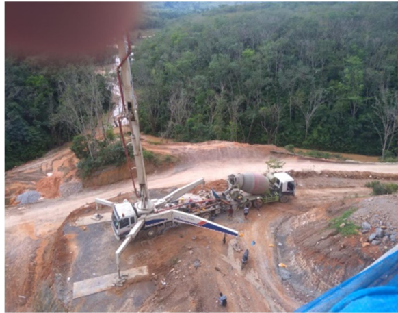
Gambar 4. 16 Pengecoran menggunakan concrete pump (Sumber : Dokumentasi Lapangan 2023)
