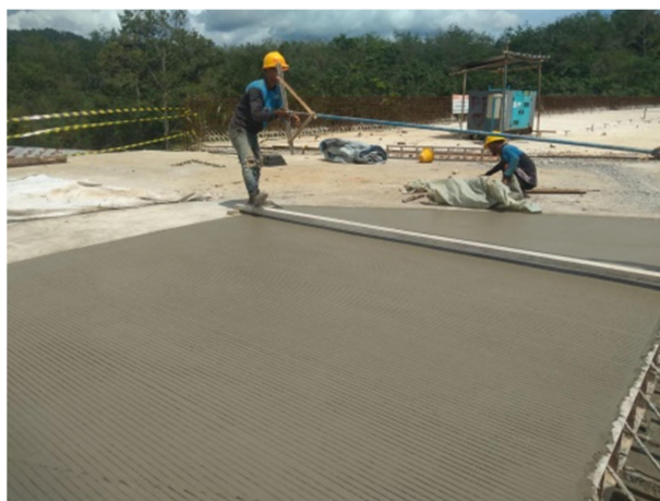
Gambar 3. 42 Penghalusan permukaan rigid
