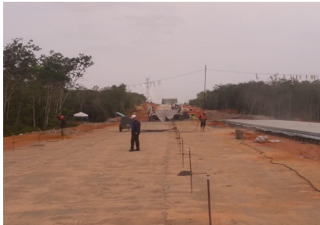
Gambar 3. 47 Pekerjaan Pembersihan lahan
