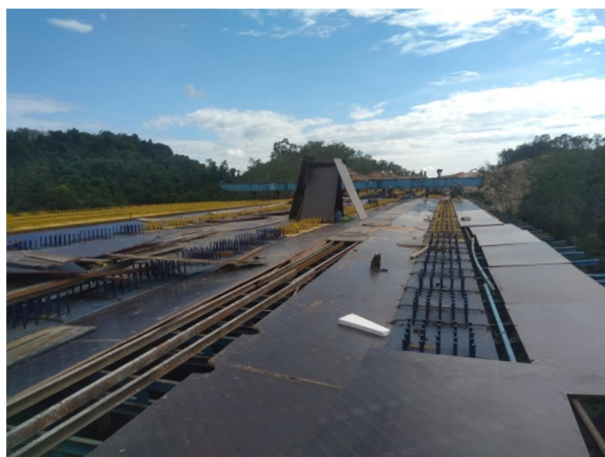
Gambar 4. 9 Pemasangan papan Phenolip
