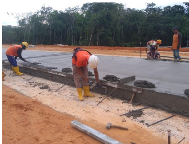
Gambar 3. 60 Proses pemasangan Tie Bar (Sumber : Dokumentasi Lapangan 2023)
