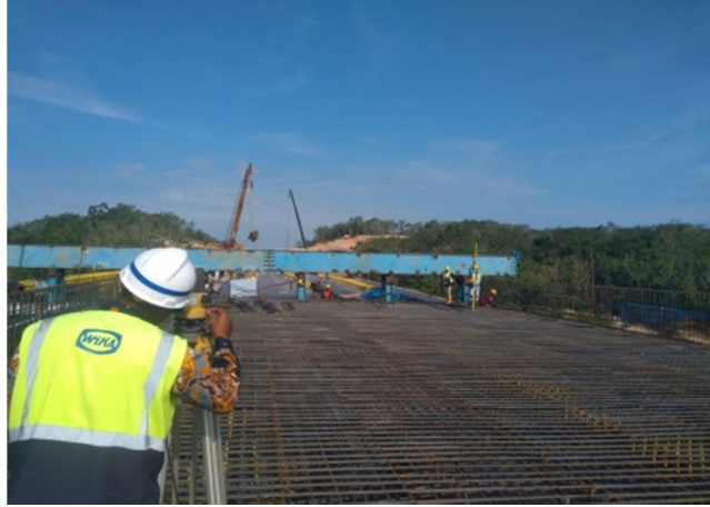
Gambar 3. 10 Pekerjaan Stake Out Top Cor Slab (Sumber : Dokumentasi Kerja Praktek 2023)
