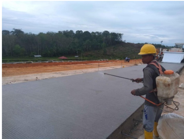
Gambar 3. 64 Proses penyemprotan antisol
