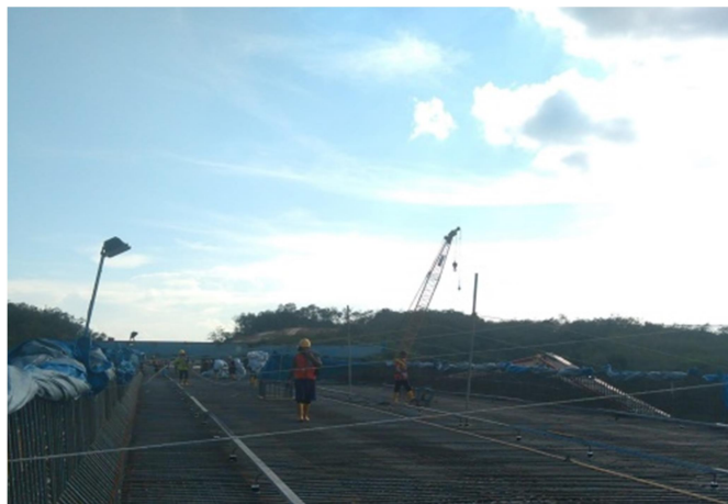
Gambar 3. 11 Penyirman untuk persiapan pengecoran (Sumber : Dokumentasi Kerja Praktek 2023)
