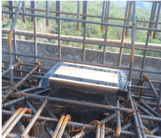
Gambar 4. 12 Pemasangan dack drain (Sumber : Dokumentasi Kerja Praktek 2023)
