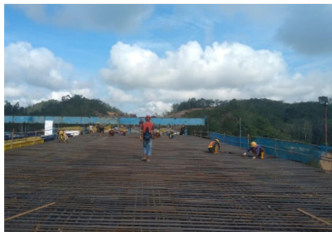
Gambar 3. 7 Pekerjaan Pengikatan Tulangan
