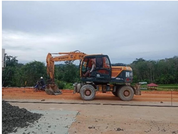
Gambar 3. 52 Wheel Excavator (Sumber : Dokumentasi Lapangan 2023)
