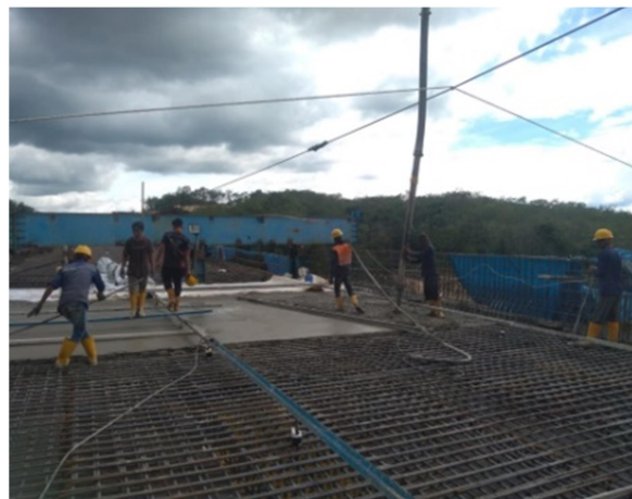
Gambar 4. 16 Pengecoran menggunakan concrete pump (Sumber : Dokumentasi Lapangan 2023)
