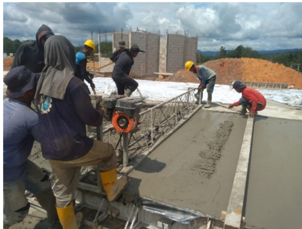
Gambar 3. 41 Perataan menggunakan mesin screed (Sumber : Dokumentasi Lapangan 2023)
