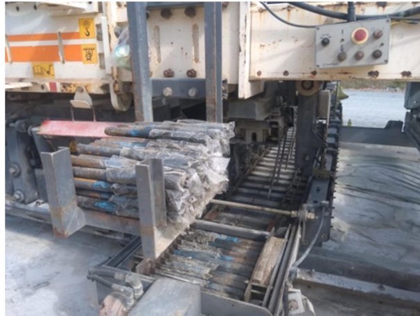
Gambar 3. 48 Pekerjaan memasukan Dowel (Sumber : Dokumentasi Lapangan 2023)
