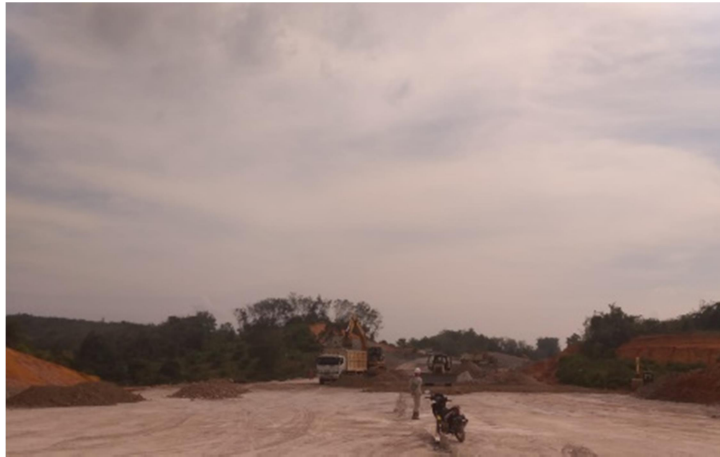
Gambar 3. 16 Pekerjaan Penimbunan Tanah Subraged (Capping Layer) (Sumber : Dokumentasi Lapangan 2023)
