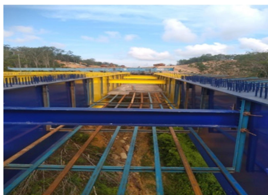
Gambar 3. 1 Pemasngan Trasbar Struktur Bawah
