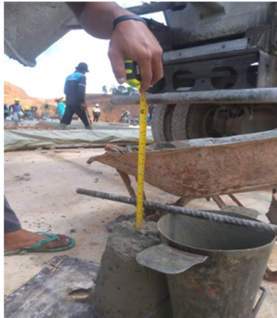
Gambar 3. 38 Uji slump pemengecoran rigid manual
