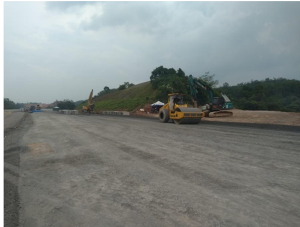
Gambar 3. 24 Pekerjaan Pemadatan LD (Sumber : Dokumentasi Lapangan 2023)
