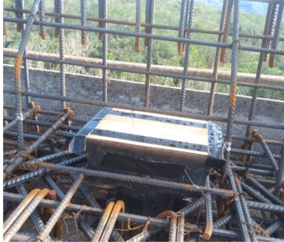
Gambar 3. 9 Pemasangan Dack Drainese
