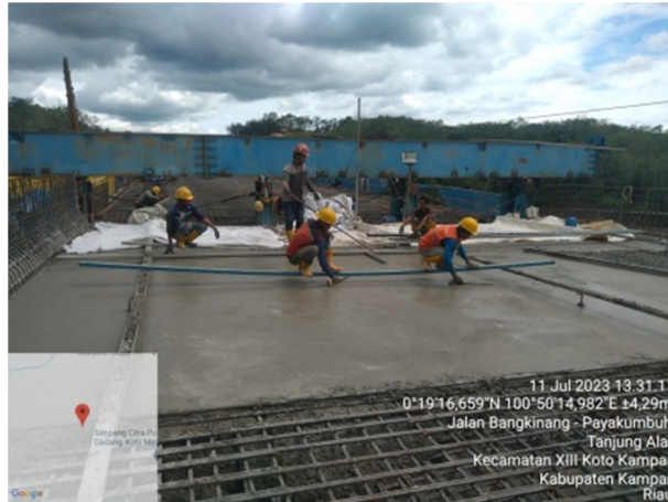
Gambar 3. 14 Pekerjaan Grouving, Penghalusan dan curing (Sumber : Dokumentasi Kerja Praktek 2023)
