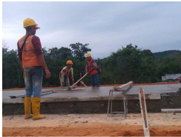
Gambar 3. 43 Pekerjaan grooving
