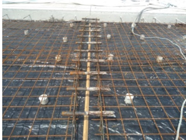
Gambar 3. 32 Pekerjaan Pemasangan Dowel (Sumber : Dokumentasi Lapangan 2023)
